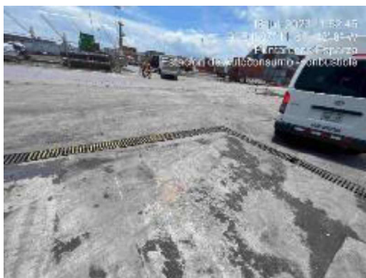
Filtro de arena situado en el perímetro de la estación de combustible que muestra suelo contaminado.
