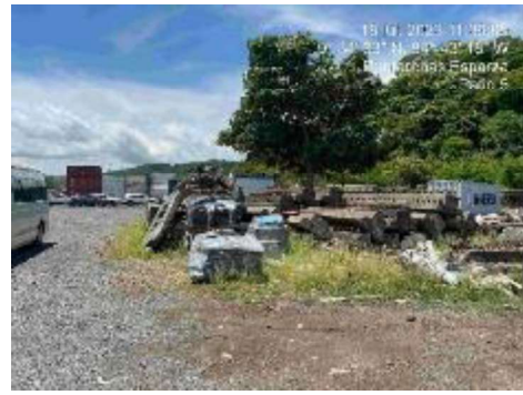
Zona de almacenamiento de escombros (1546,26 m 2 ) situada en el Patio 5: Se observaron algunos tubos de 3 pulgadas, vigas de hormigón, madera, pellets, cables, neumáticos, entre otros. Se observó suelo contaminado
