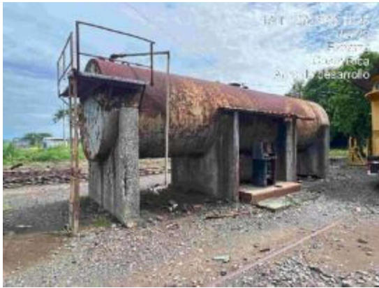
Tanque de almacenamiento sobre suelo (AST) de una estación de servicio de combustible abandonada (aproximadamente 5000 galones)
