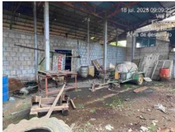
Suelo contaminado dentro del antiguo taller
