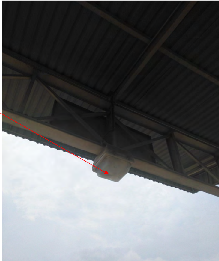
Figura 2. Luminaria fluorescente sellada ubicada en la estación de servicio.
