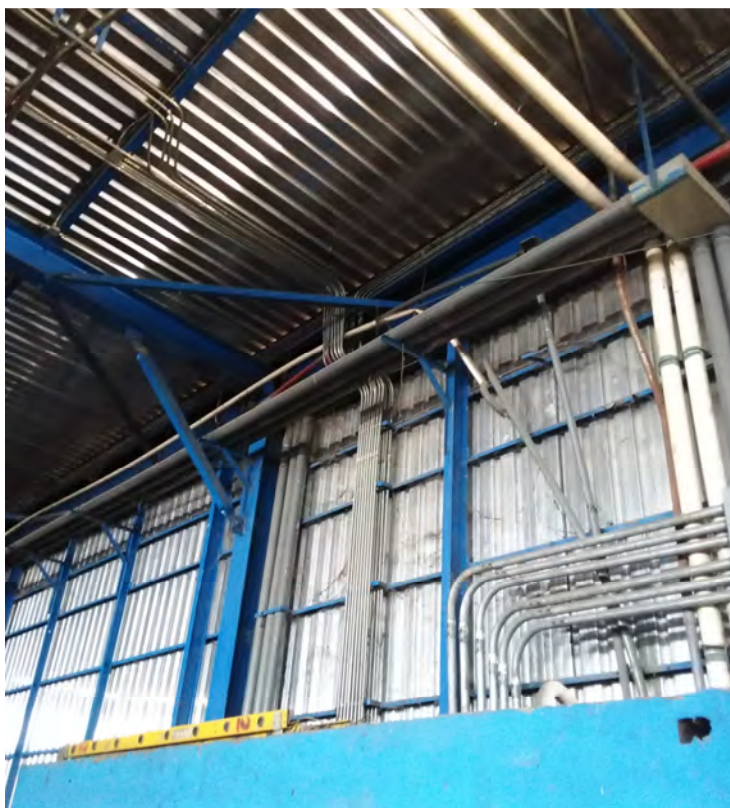
Figura 2. Tuberías eléctricas en EMT del edificio K.
