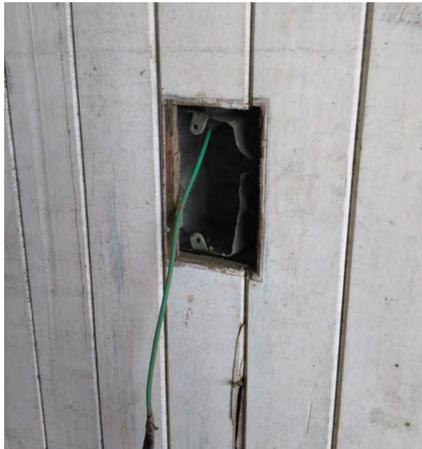
Figura 3. Caja de salida para tomacorriente.
