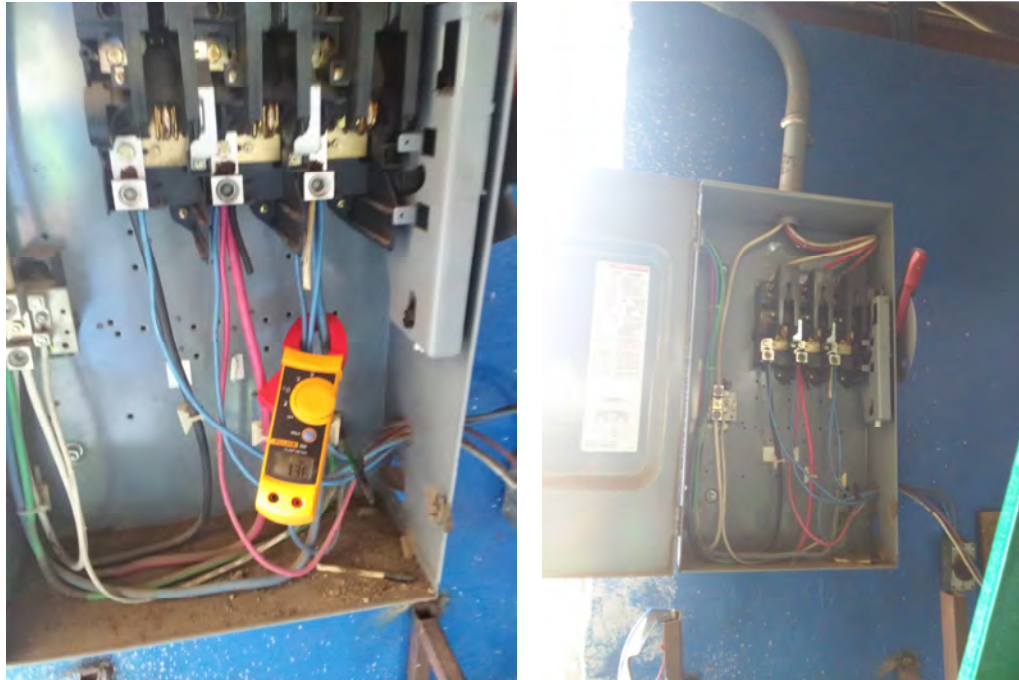
Figura 5. Tablero del hangar de maquinaria, las violaciones al código son evidentes.
