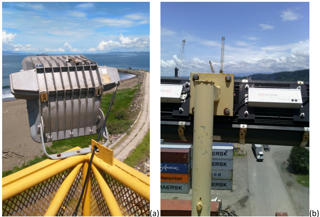
Figura 2. Lámpara Metalar 1500W (a), lámpara LED MW 500W (a).
