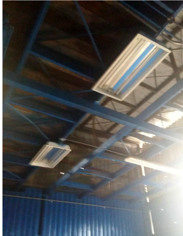
Figura 4. Luminarias fluorescentes en edificio G.
