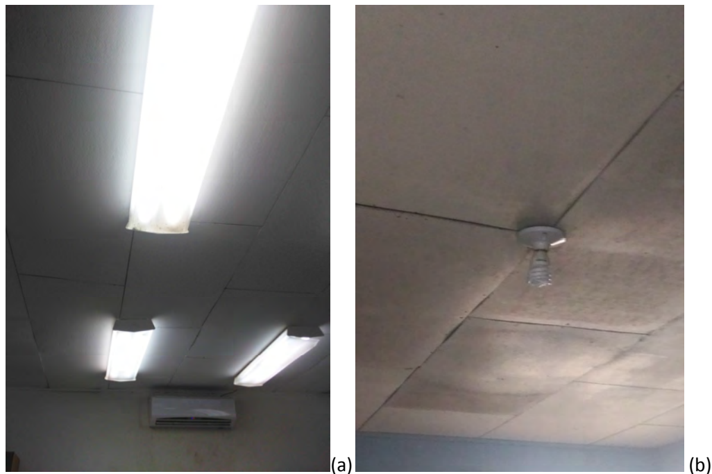
Figura 3. Luminarias fluorescentes tubulares (a) y tipo compacta integrada (b).
