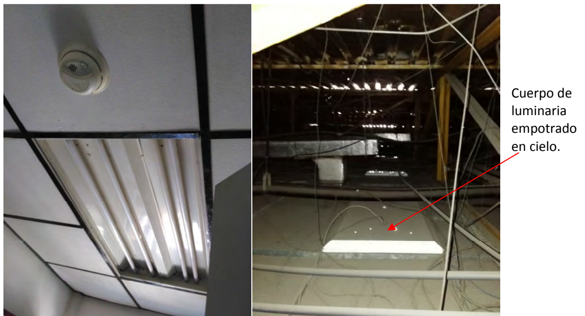
Figura 3. Luminarias empotradas en el cielo del edificio O.
