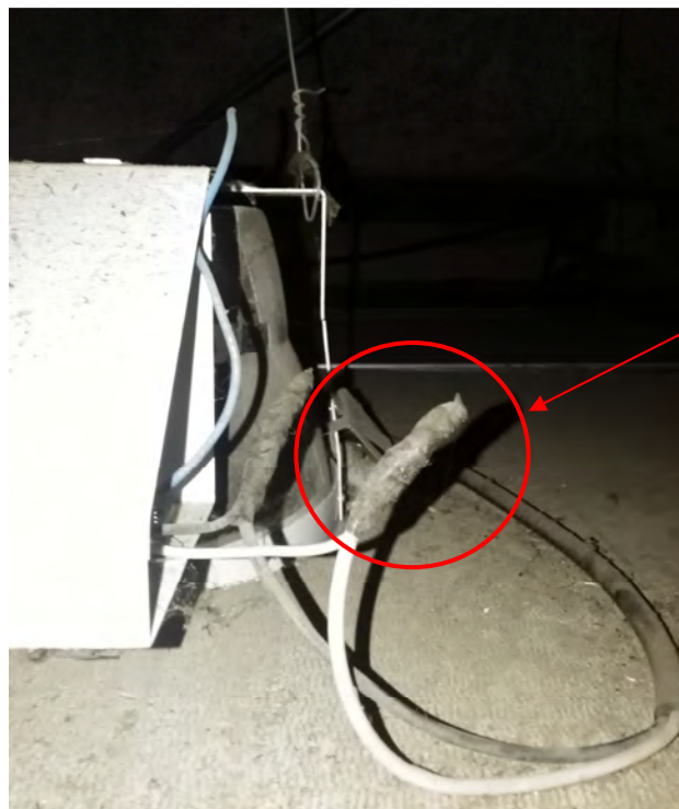
Figura 3. Conexión de conductores eléctricos de las luminarias.
