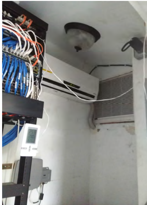
Figura 10. Aire acondicionado ubicado en el mismo recinto el rack de red (a), aterrizamiento de los equipos (b).
