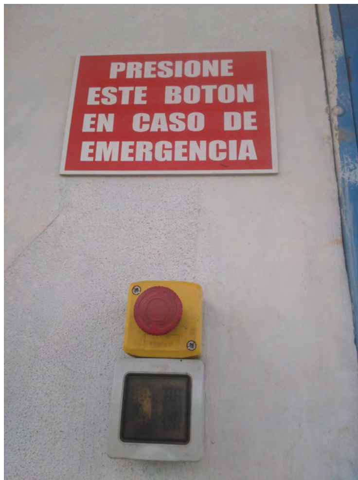
Figura 3. Botón para paro de emergencia ubicado en el edificio S.
