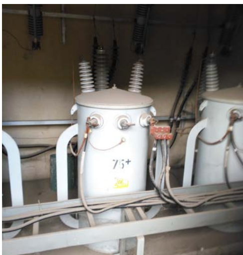
Figura 1. Banco de transformadores
