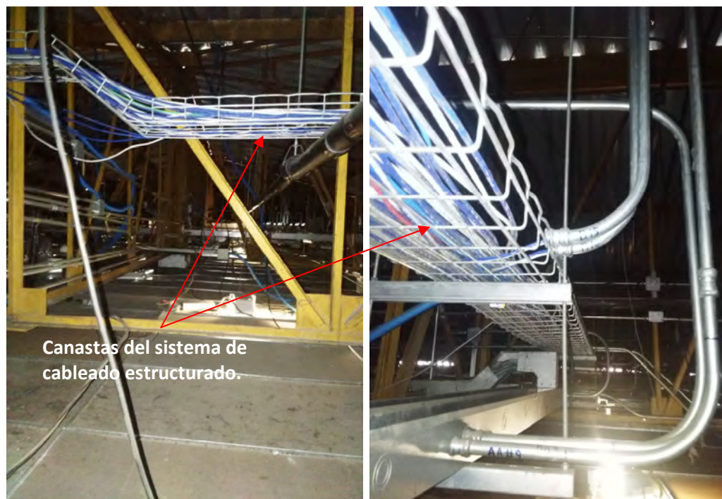
Figura 8. Canastas para el cableado estructurado.
