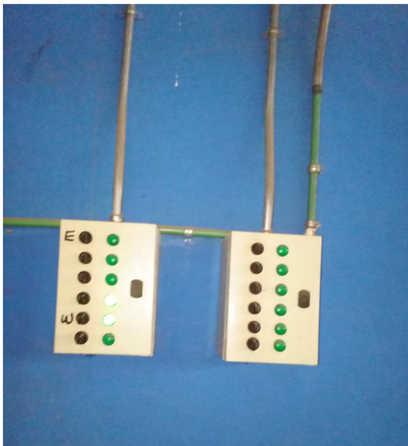
Figura 2. Botoneras utilizadas para encender las luminarias.
