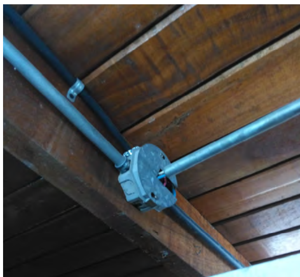
Figura 2. Caja de registro eléctrico.
