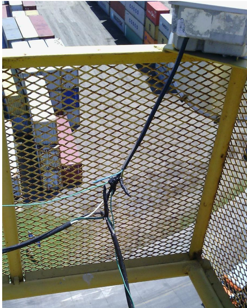
Figura 4. Conexión de conductores eléctricos, aislada con tape.
