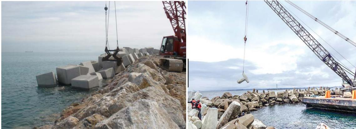
Figura 67. Colocación de piezas especiales del manto, bien por medios terrestres o medios marítimos
