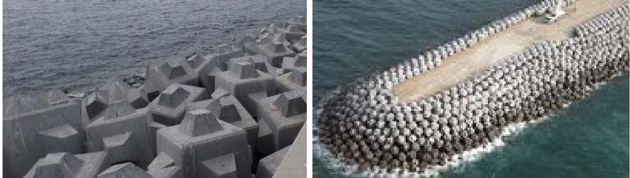
Figura 7. Protecciones costeras con cubípodos
