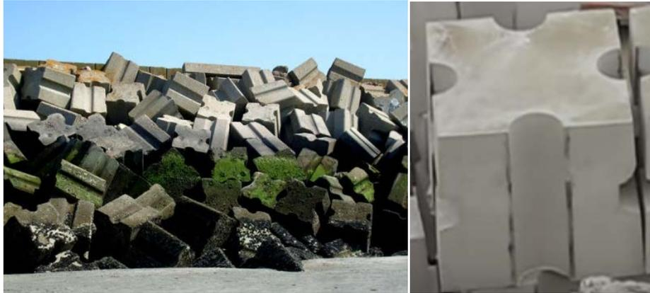
Figura 9. Protecciones costeras con antifer
