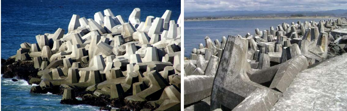
Figura 8. Protecciones costeras con dolos
