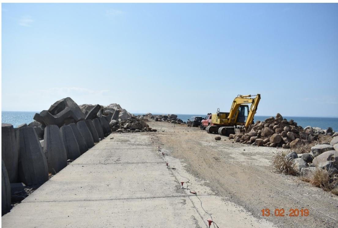
**Foto 4. Colocación de geófonos de 4.5 Hz para las pruebas MASW**
