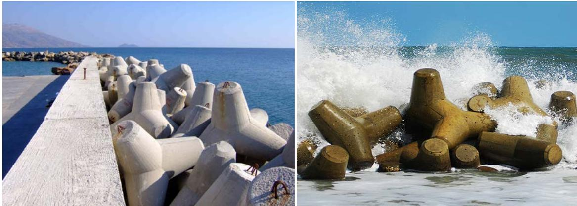
Figura 5. Protecciones costeras con tetrápodos
