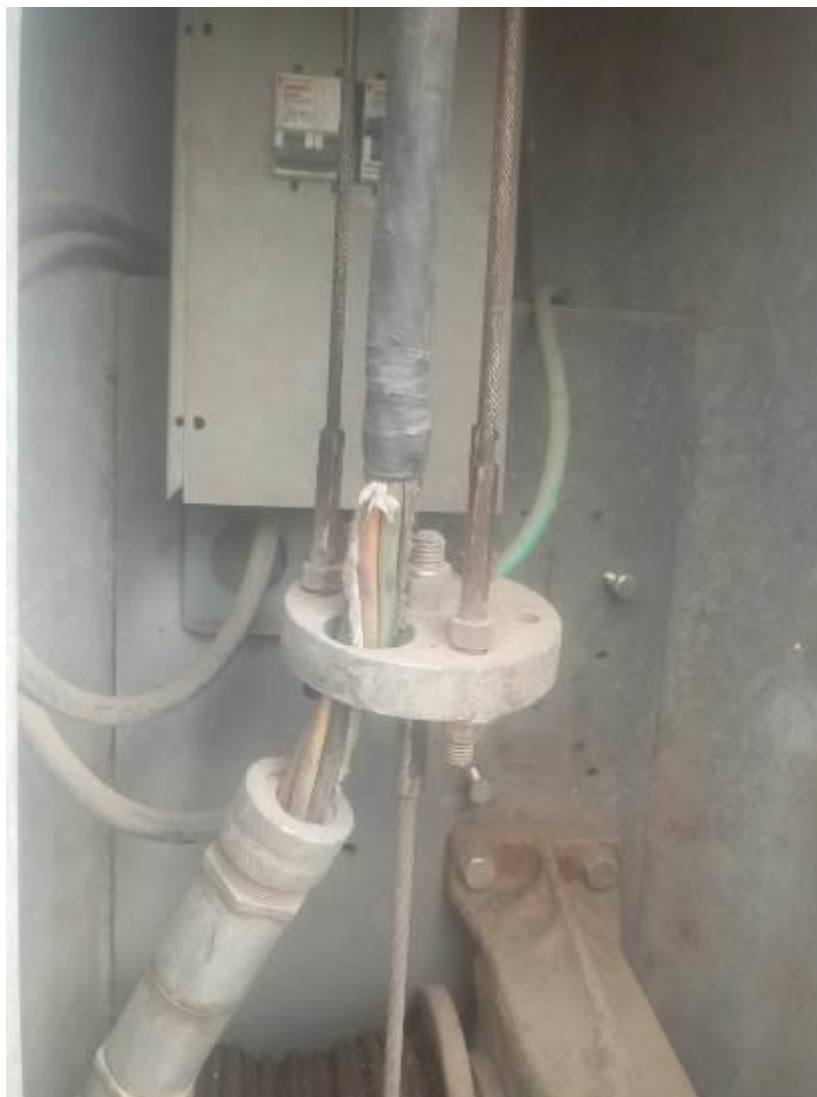
Figura 8. Revisión al sistema de izaje en postes de luces con corona
