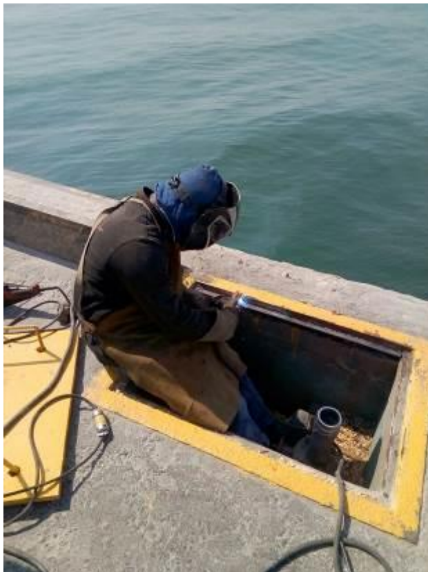
Figura 1. Instalación de soportes y tapas en tomas de agua muelle
