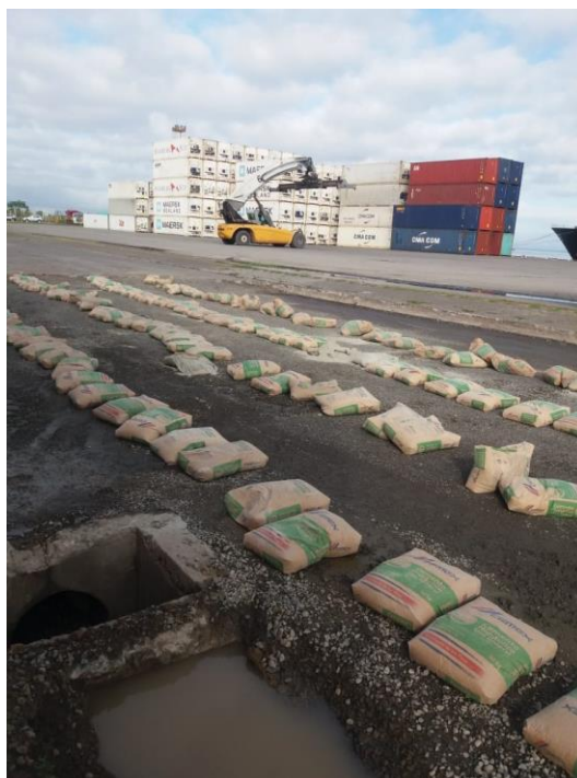
Figura 13. Trabajos para base estabilizada en calle entre patios 1 y 2
