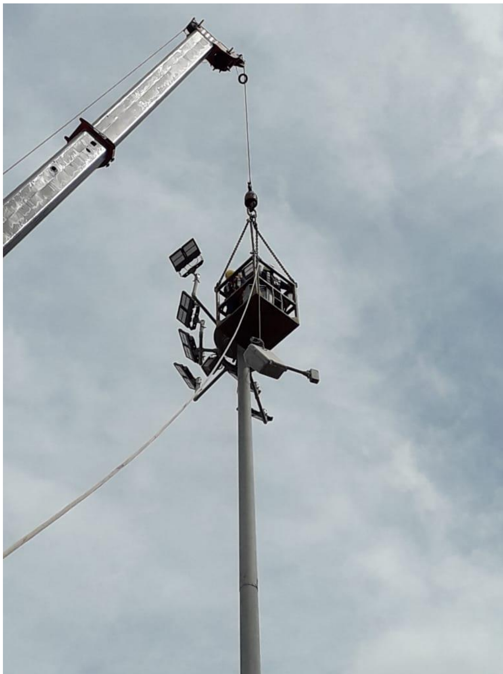
Figura 46. Proceso de instalación nuevas luminarias LED
