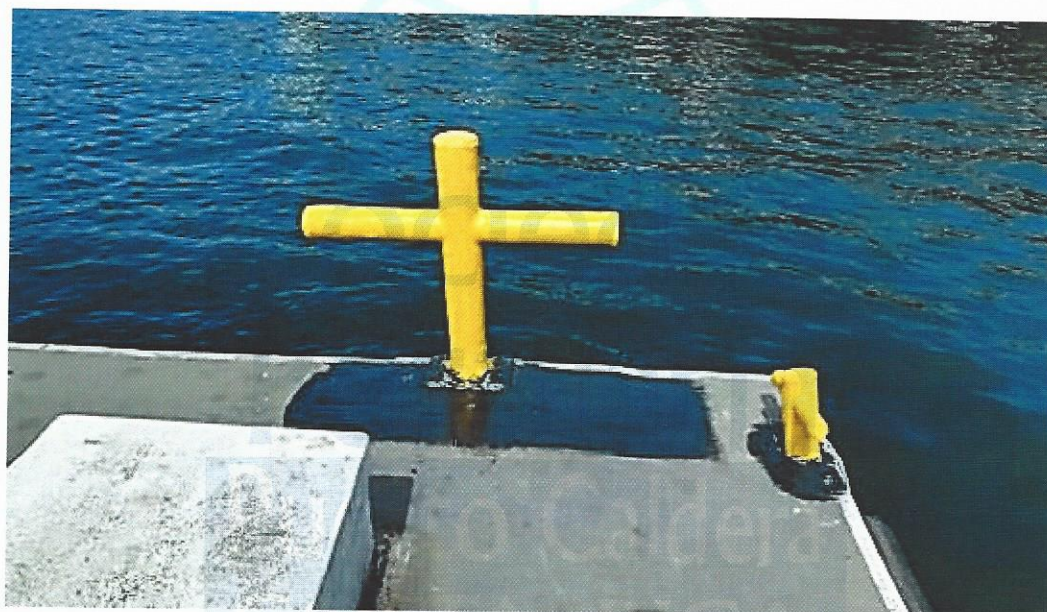
Figura 51. Reparación de bita
