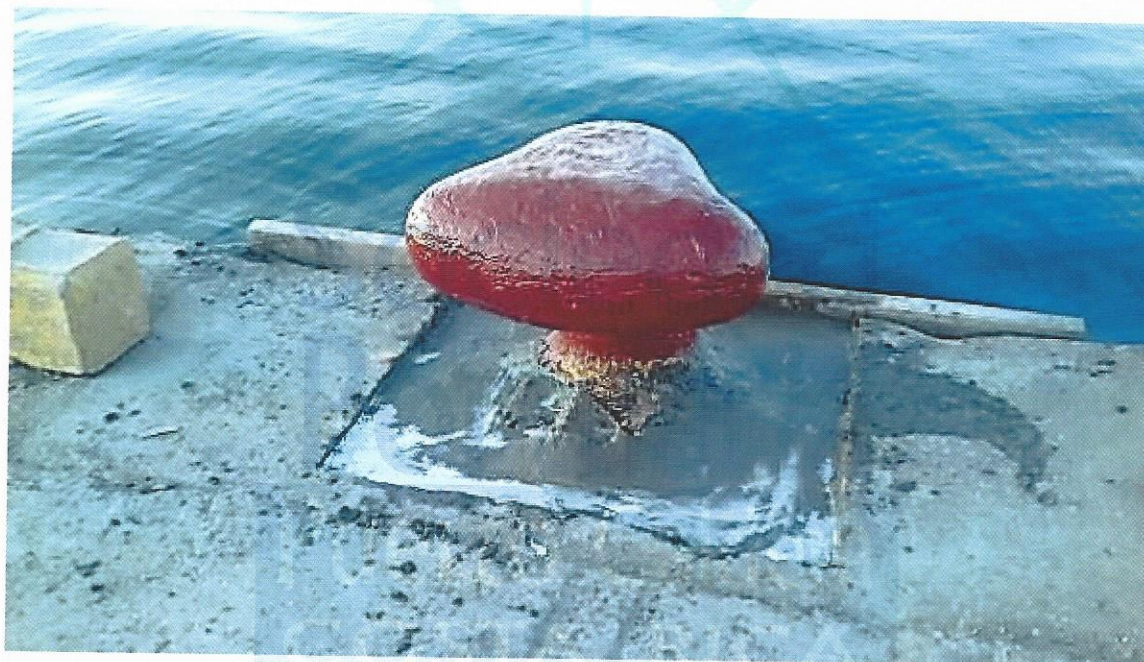
Figura 16. Proceso de aplicación de mortero de reparación en bases
