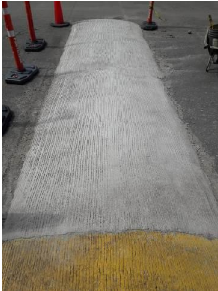
Figura 43. Colado de reductor de velocidad en sector de la bascula uno
