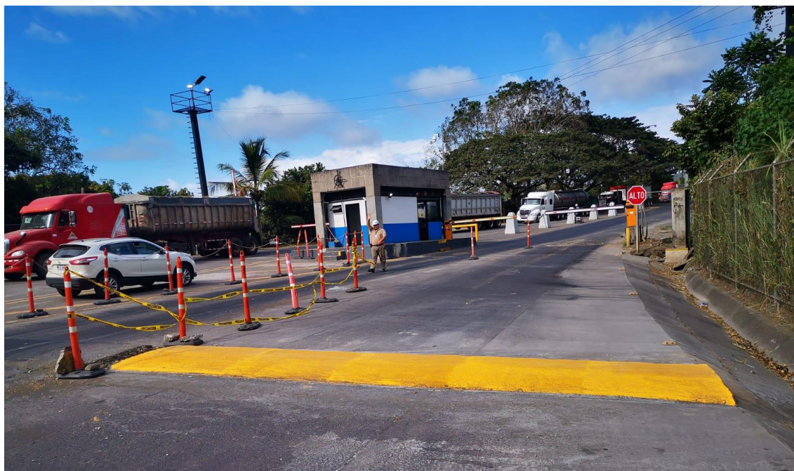
Figura 50. Reductor ECO 1 luego de intervención con acabado pintura
