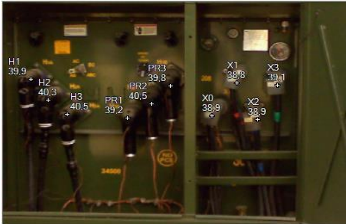
Figura 11. Inspección transformador de bodega uno
