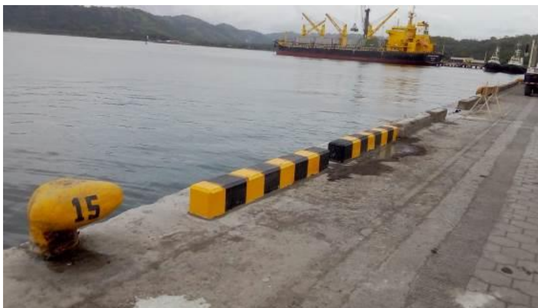
Figura 40. Instalación de muros guardarruedas nuevos
