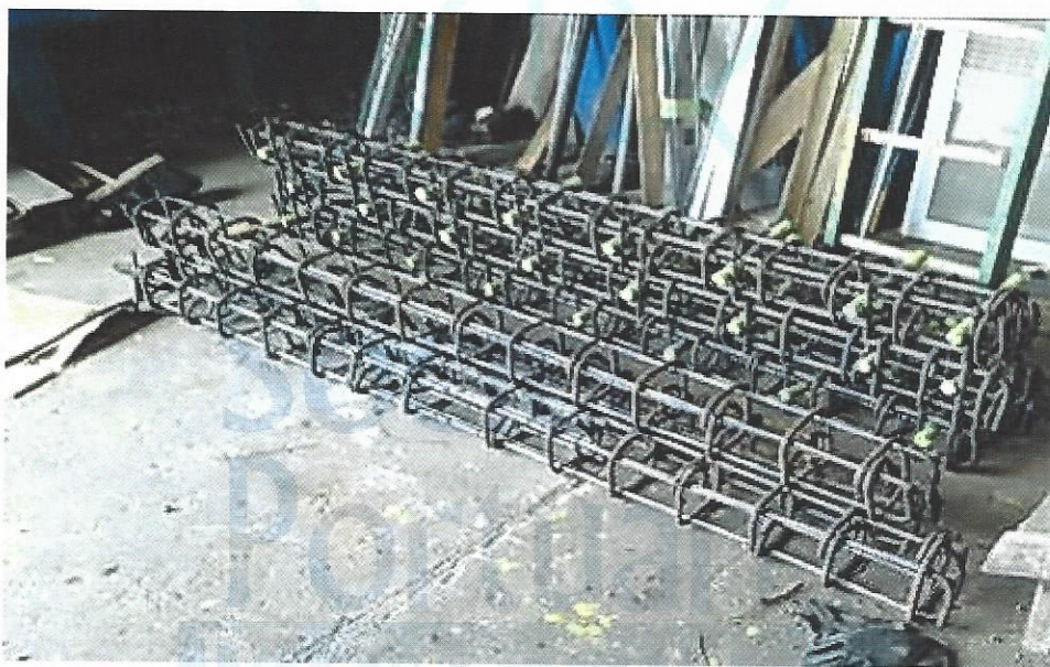
Figura 17. Confección de armaduras para muros guardaruedas
