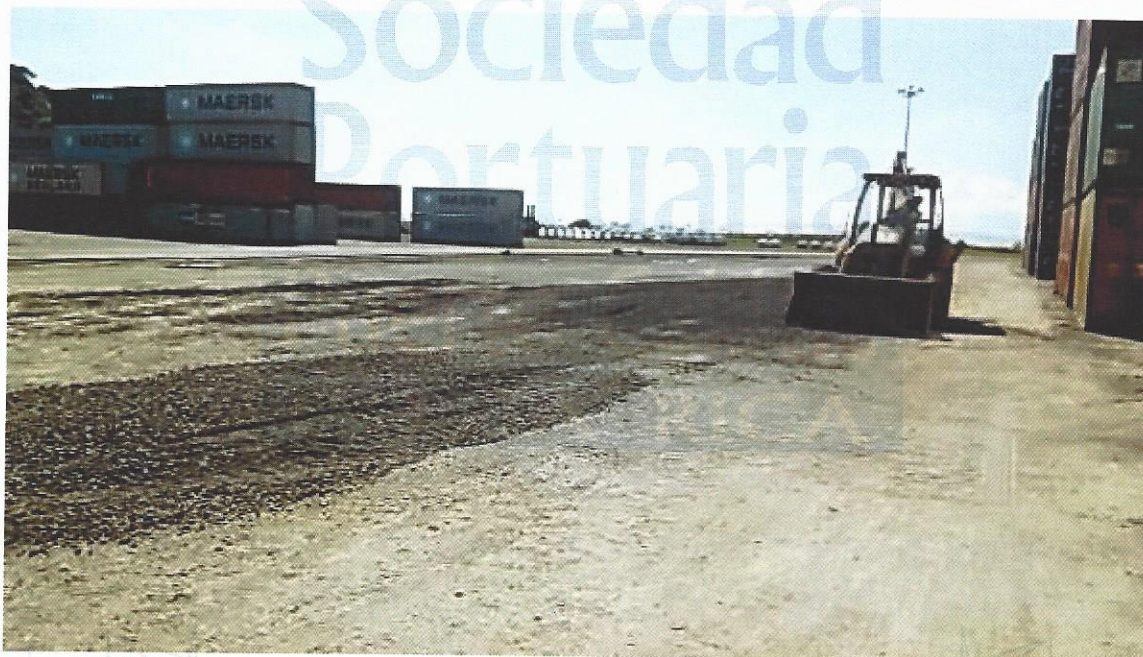
Figura 27. Trabajos de acabado en rasante de patio dos.
