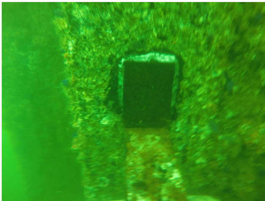
Figura 37. Soldadura en base de soporte de ánodos instalados
