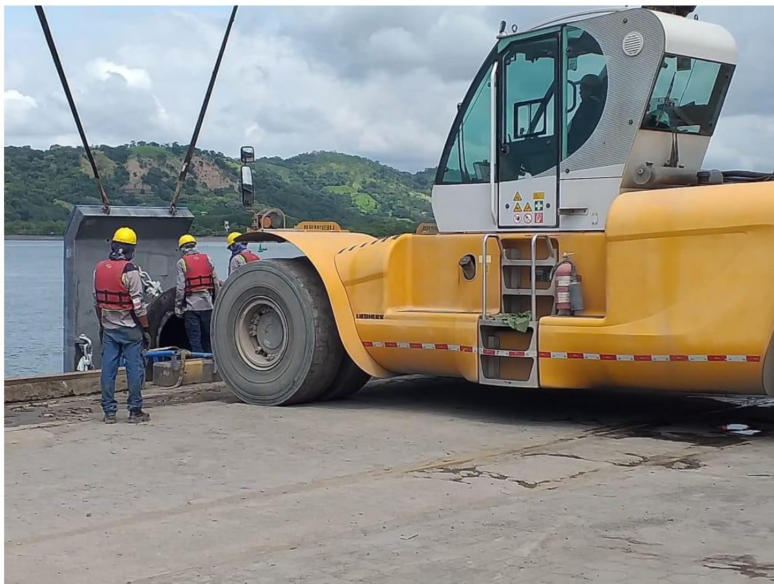
Figura 27. Instalación defensas en sitio
