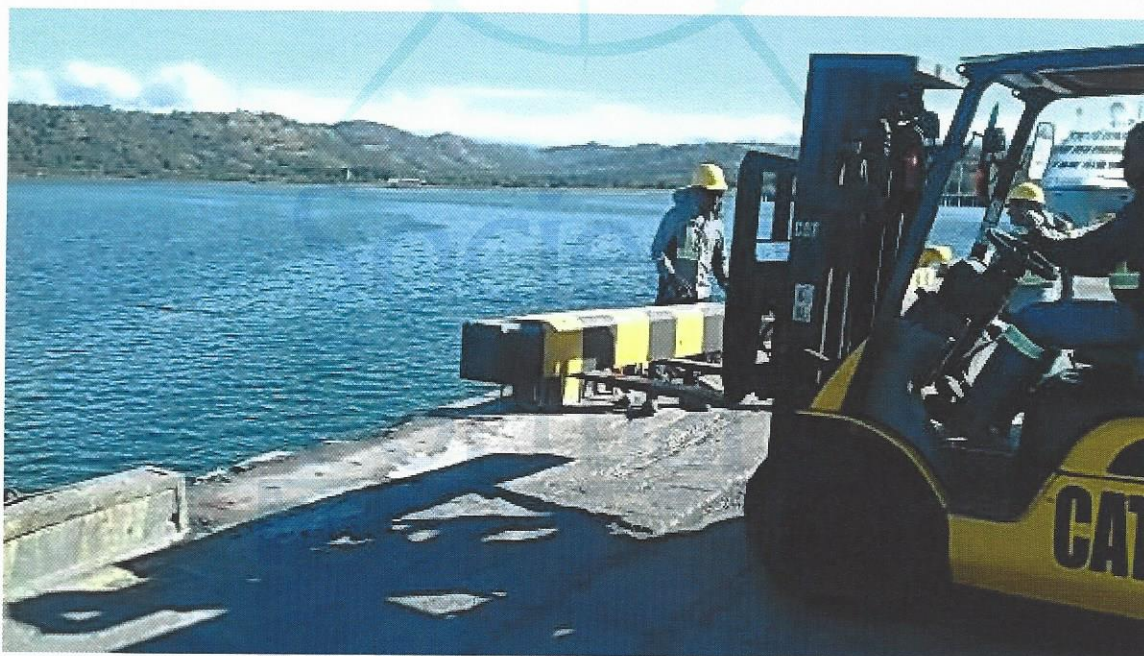
Figura 21. Proceso de instalación de nuevos muros guardaruedas
