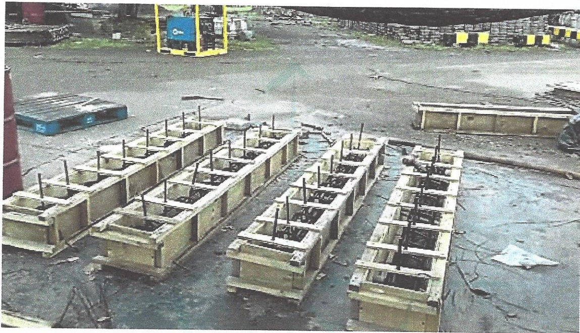
Figura 18. Proceso de armado pre-colado muros guardaruedas
