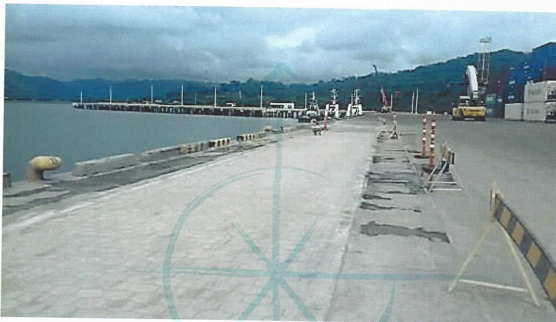
Figura 8. Reparación de adoquines puesto dos
