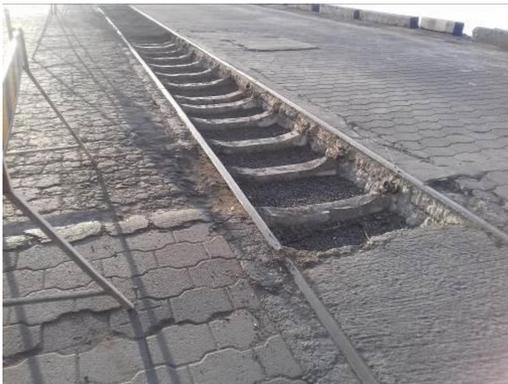
Figura 32. Proceso de demolición entre líneas tren del puesto tres
