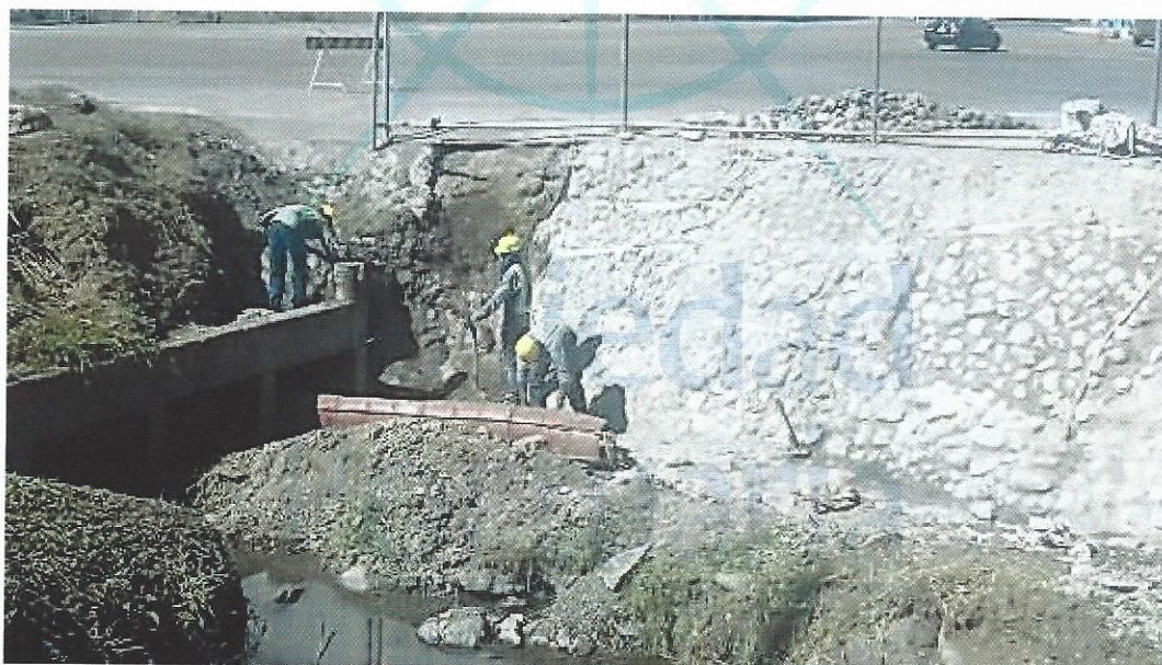
Figura 55. Finalización de revestimiento de piedra en paredes del talud y canal
