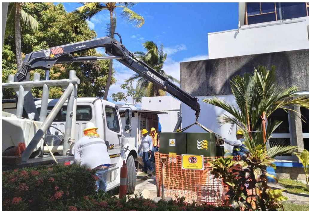
Figura 13. Proceso instalación transformador edificio administrativo
