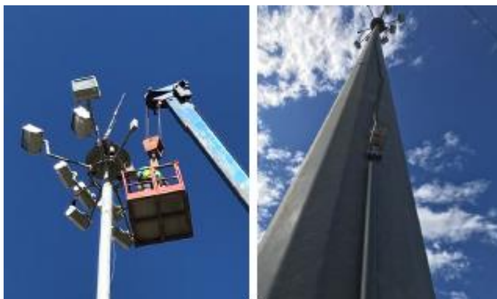
Figura 17. Revisión pararrayos en postes con corona de luces
