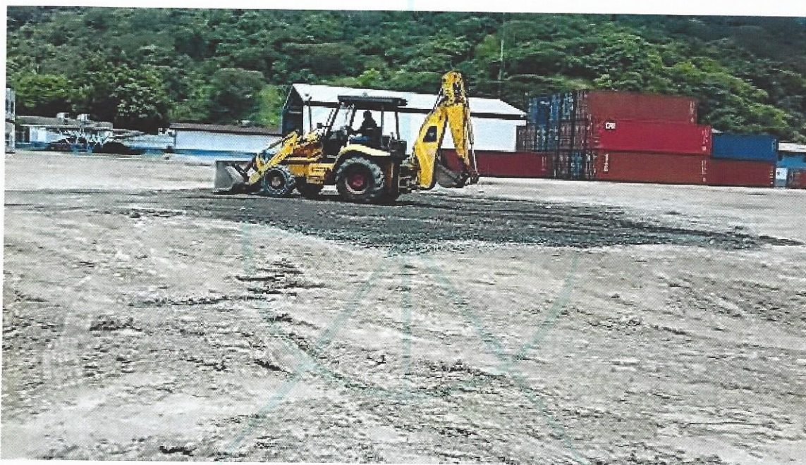
Figura 26. Mejoras con nuevo material de base granular en patio cuatro
