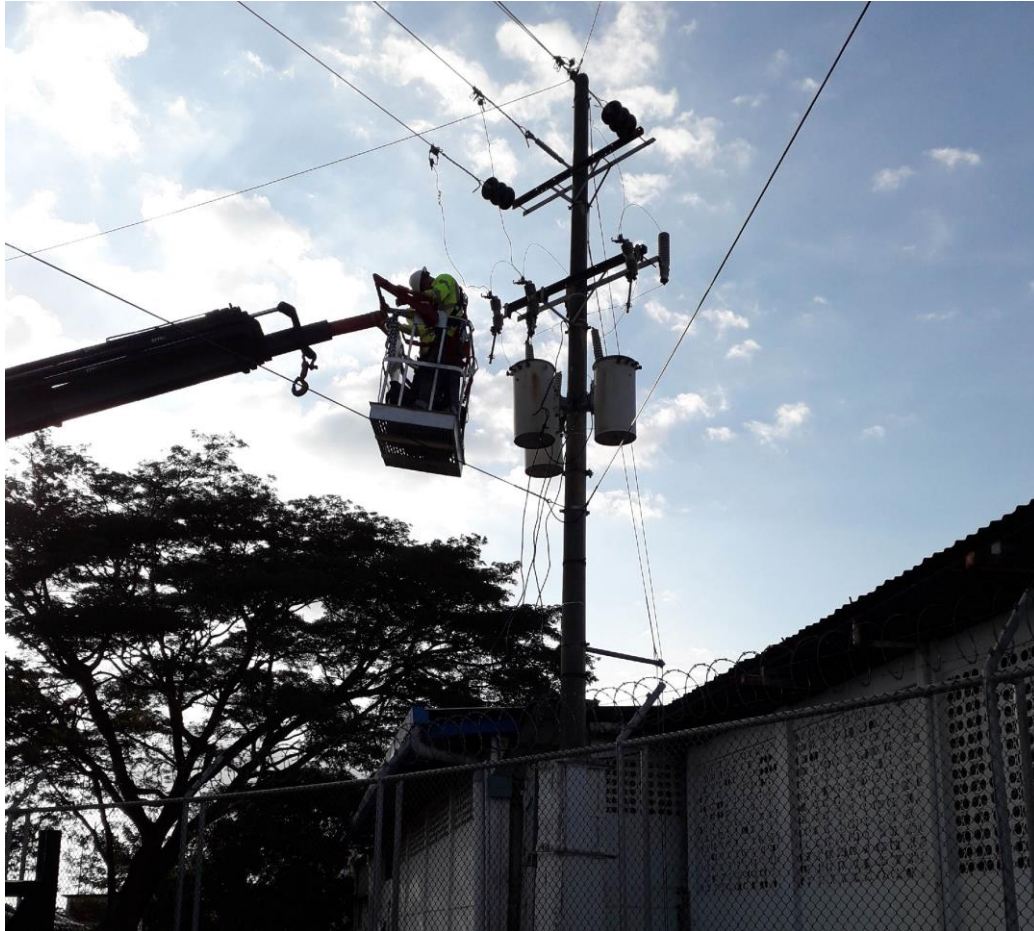
Figura 10. Mantenimiento bancos de transformadores
