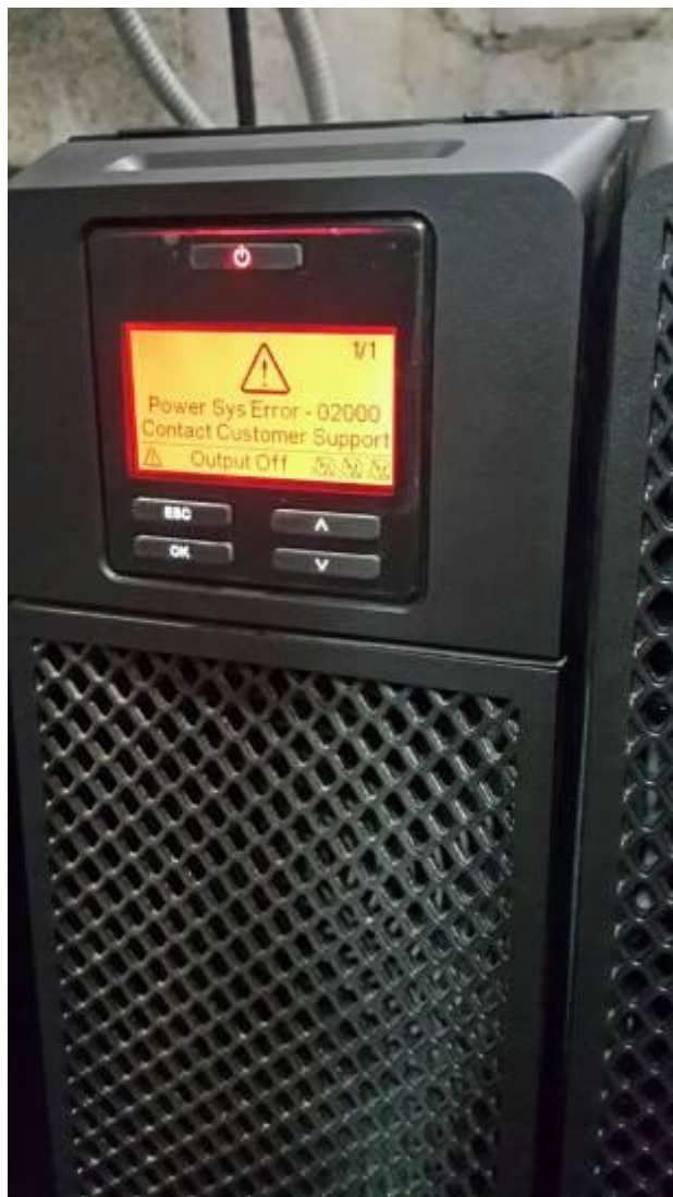
Figura 7. Revisión de avería en UPS del A-220
