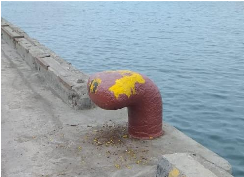
Figura 28. Limpieza para posterior reposición de capas de pintura
