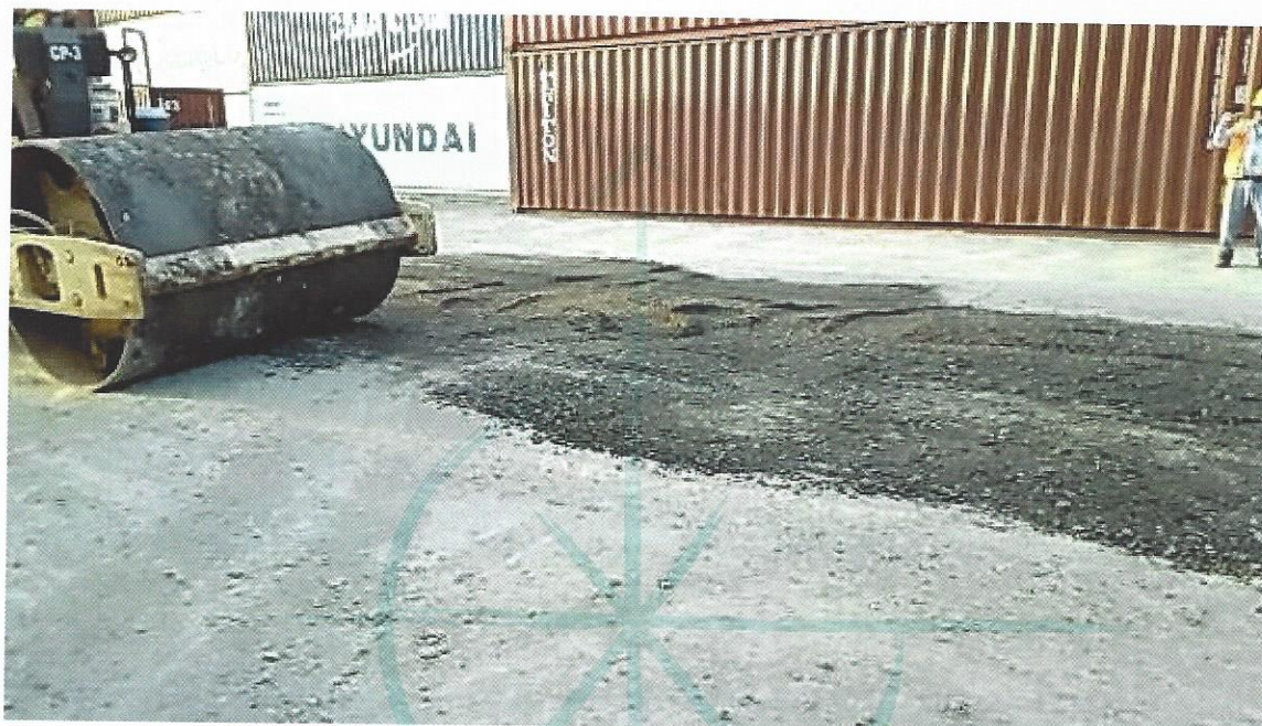
Figura 28. Trabajos de compactación en patio dos.
