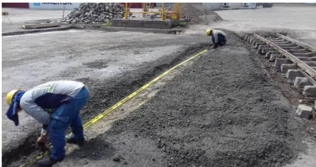
Figura 29. Mantenimiento sistema eléctrico torres de iluminación
