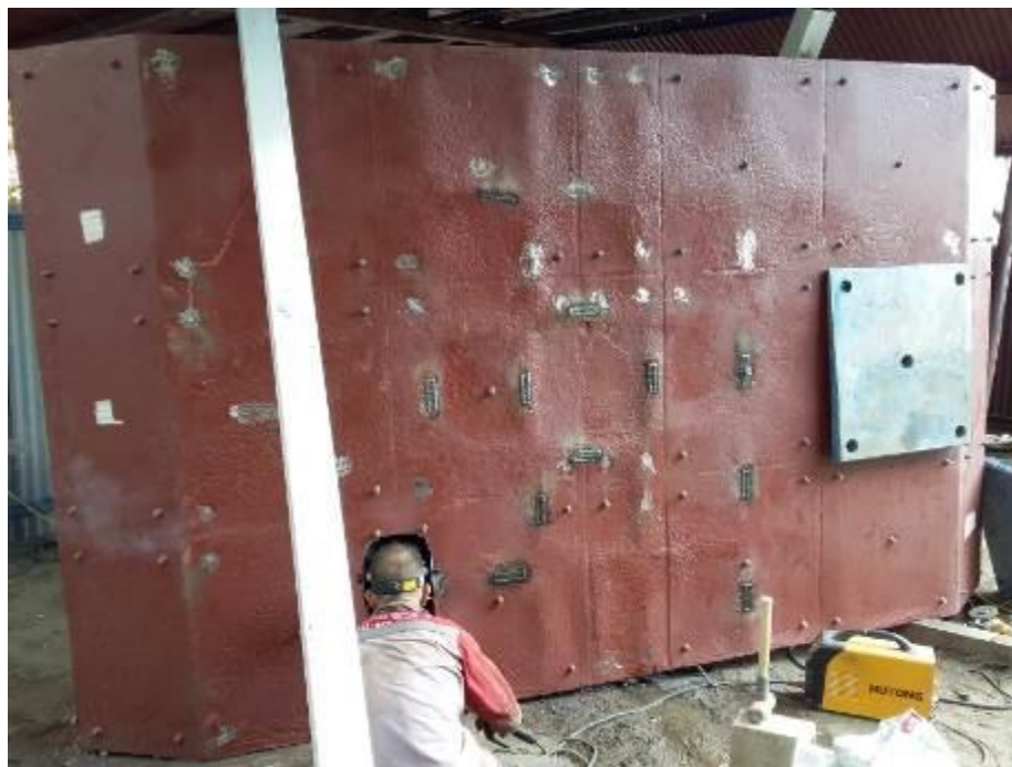
Figura 47. Proceso de reparación con soldadura en zonas con reventaduras
