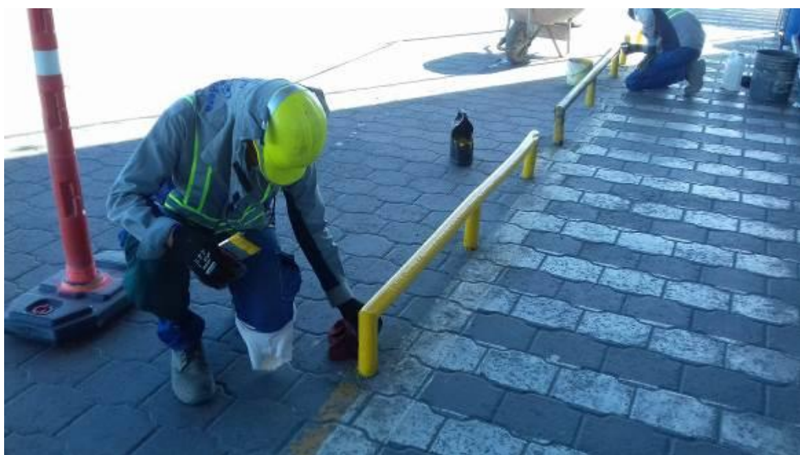
Figura 3. Reparación y pintura de tubos de protección paso peatonal junto a bodega uno
