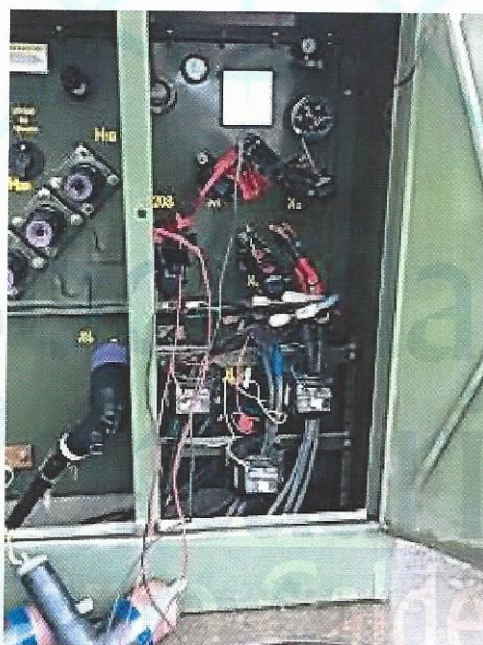
Figura 42. Mantenimiento banco de transformadores pruebas eléctricas
