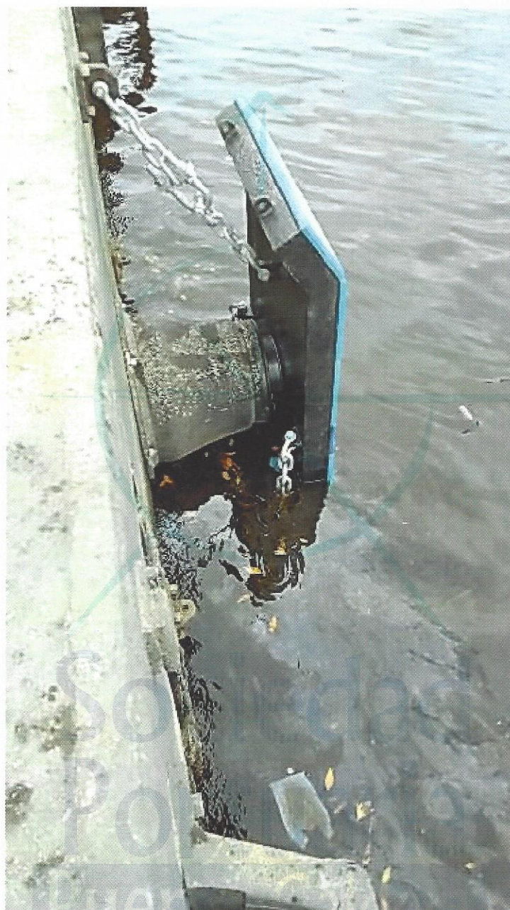
Figura 23. Proceso de instalación defensa 26 puesto 3
