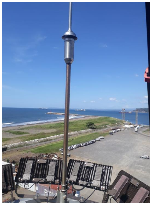
Figura 17. Vista de un pararrayo instalado
