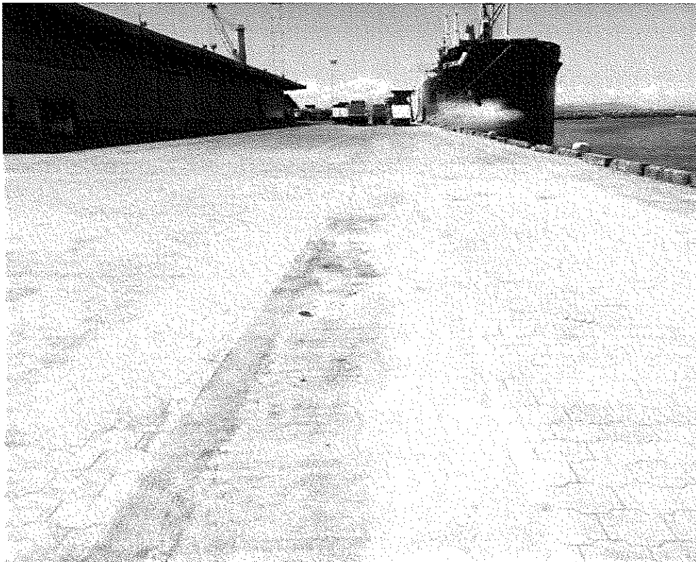
Figura 10. Reparación de pavimentos de concreto
