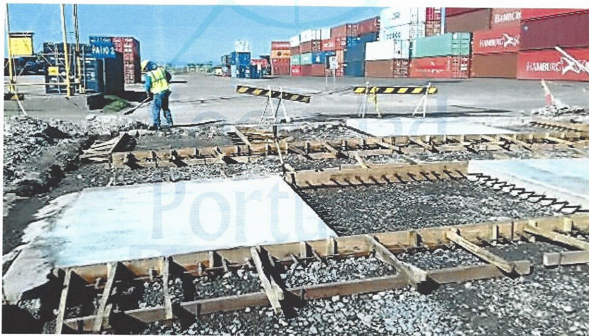
Figura 3. Colado de losas de concreto
