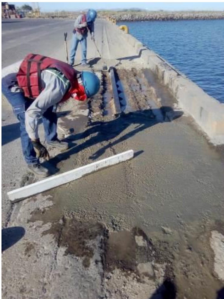
Figura 34. Colado de área de viga cabezal en el puesto uno
