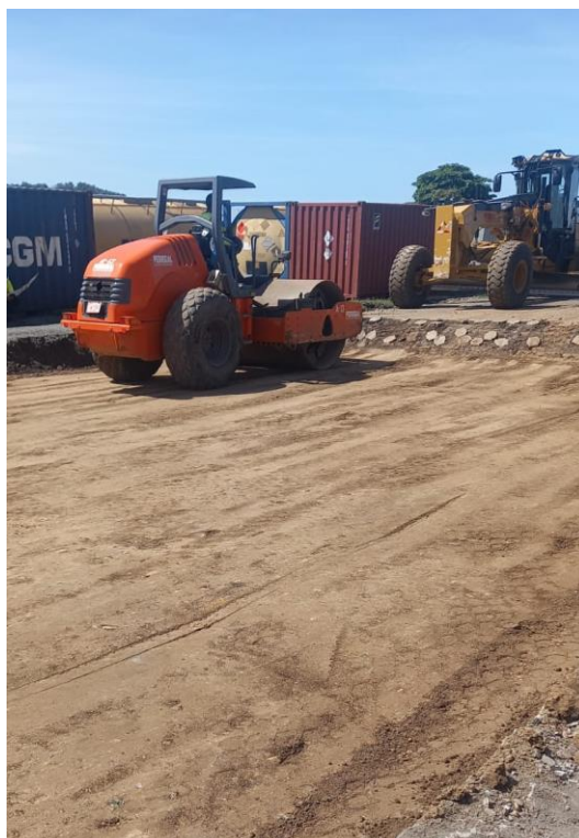
Figura 12. Trabajos de compactación
