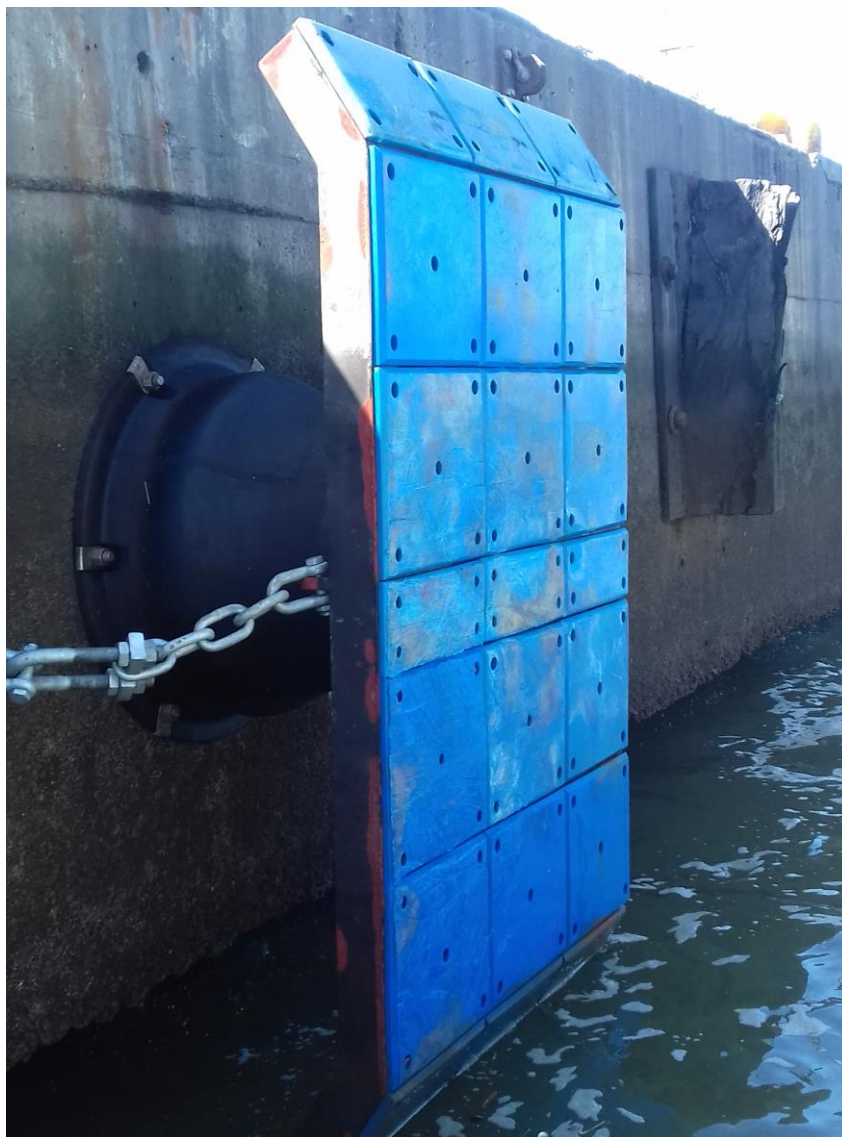
Figura 49. Instalación defensa N°5 en el muelle uno
