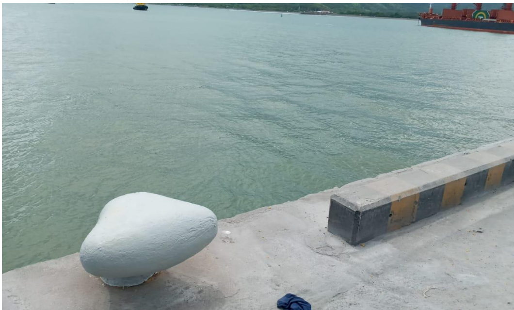
Figura 24. Proceso de aplicación de pintura base para bitas
