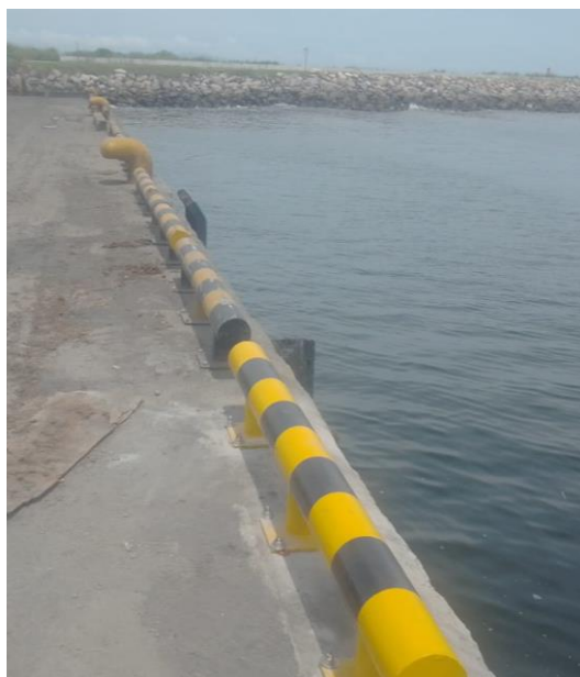
Figura 20. Muro guardarueda fabricado e instalado
