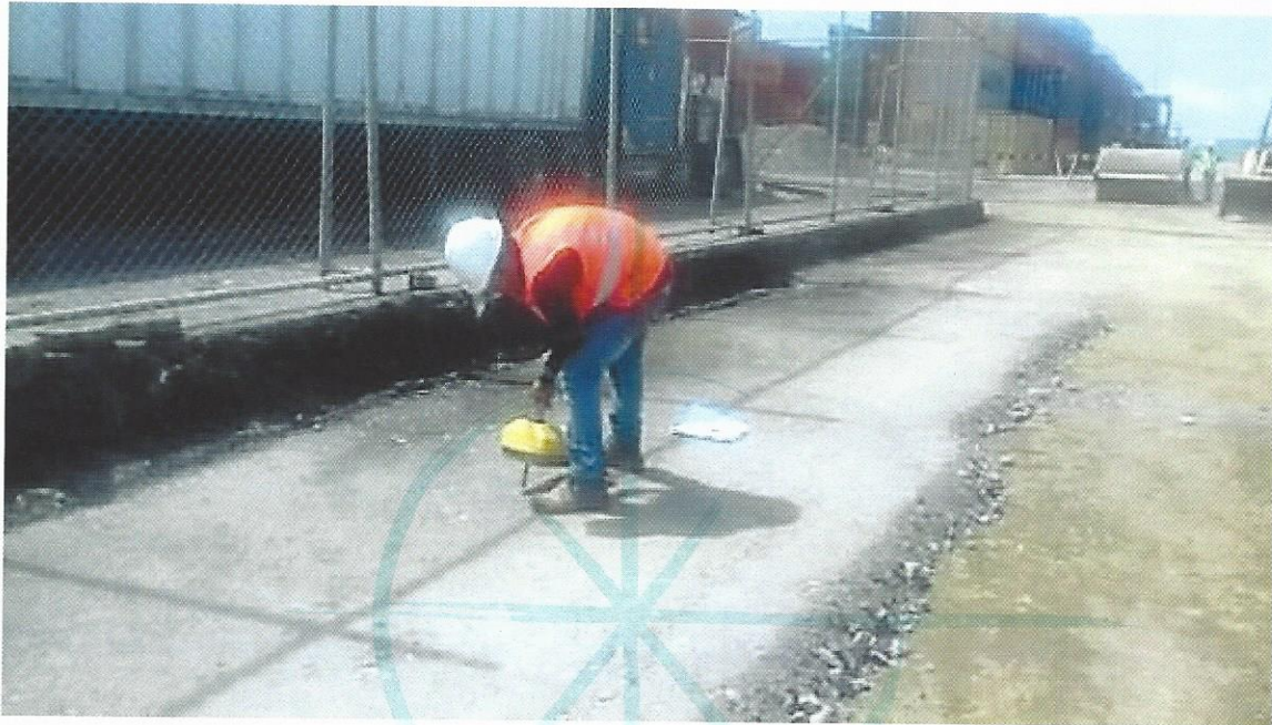
Figura 2. Pruebas de compactación en capas de material colocadas
