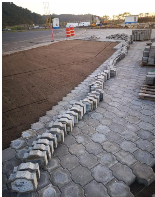
Figura 15. Trabajos colocación adoquín en puesto 1
