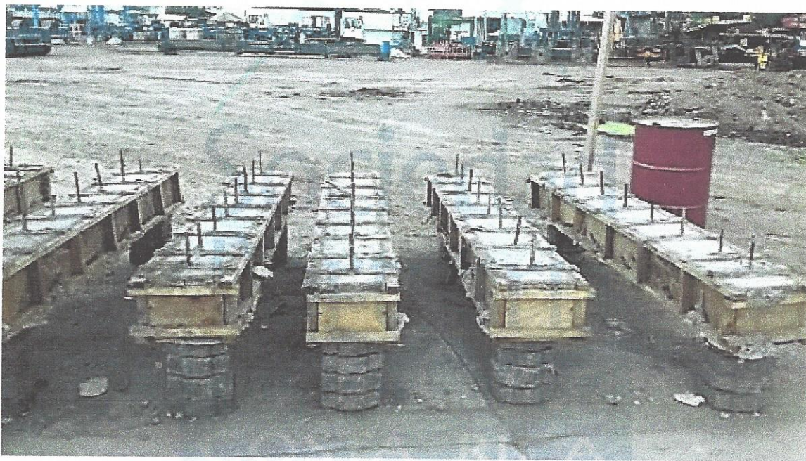
Figura 19. Nuevos muros guardaruedas colados
