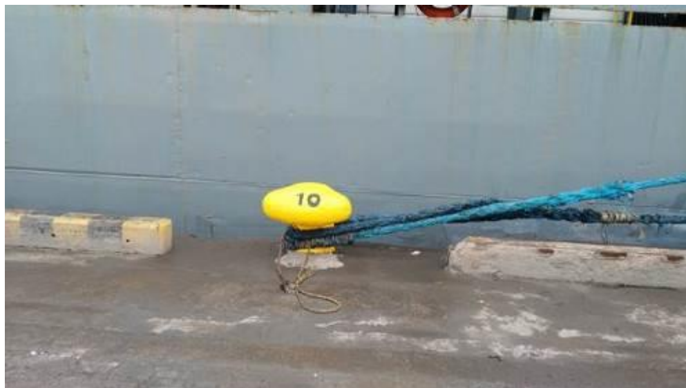
Figura 51. Pintura y numeración de bitas en el puesto uno
