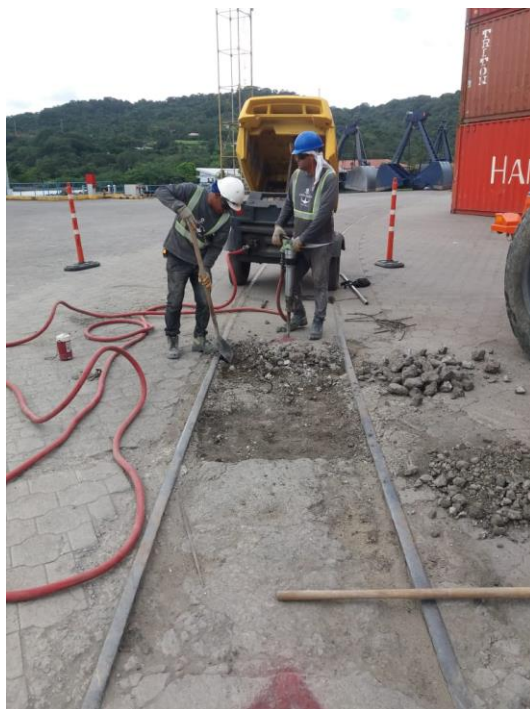
Figura 47. Demolición para trabajos de bacheo
