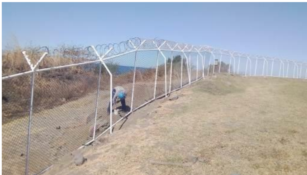
Figura 64. Proceso de reparación en malla perimetral
