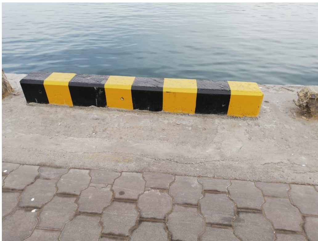
Figura 23. Muro guardarueda concreto fabricado e instalado
