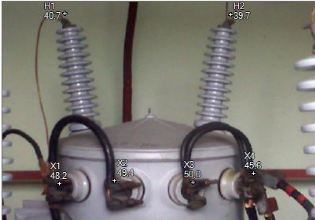
Figura 10. Inspección transformador INCOP del edificio administrativo
