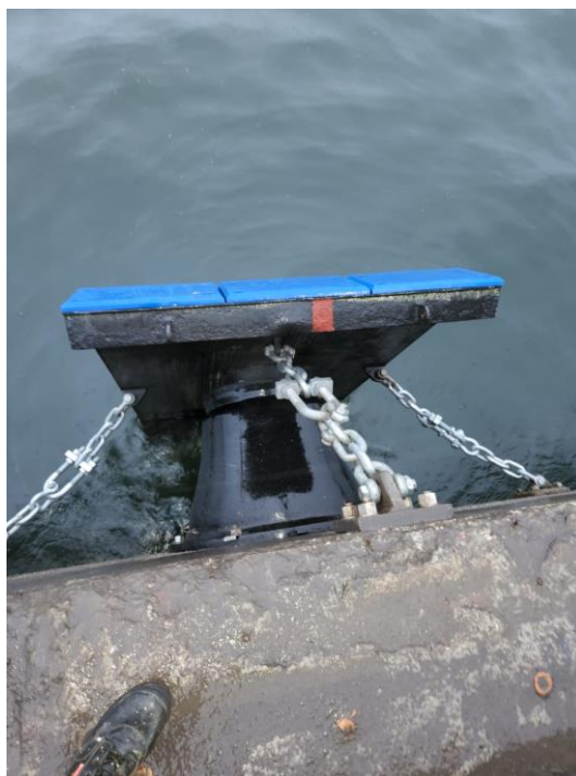
Figura 23. Instalación defensas en sitio
