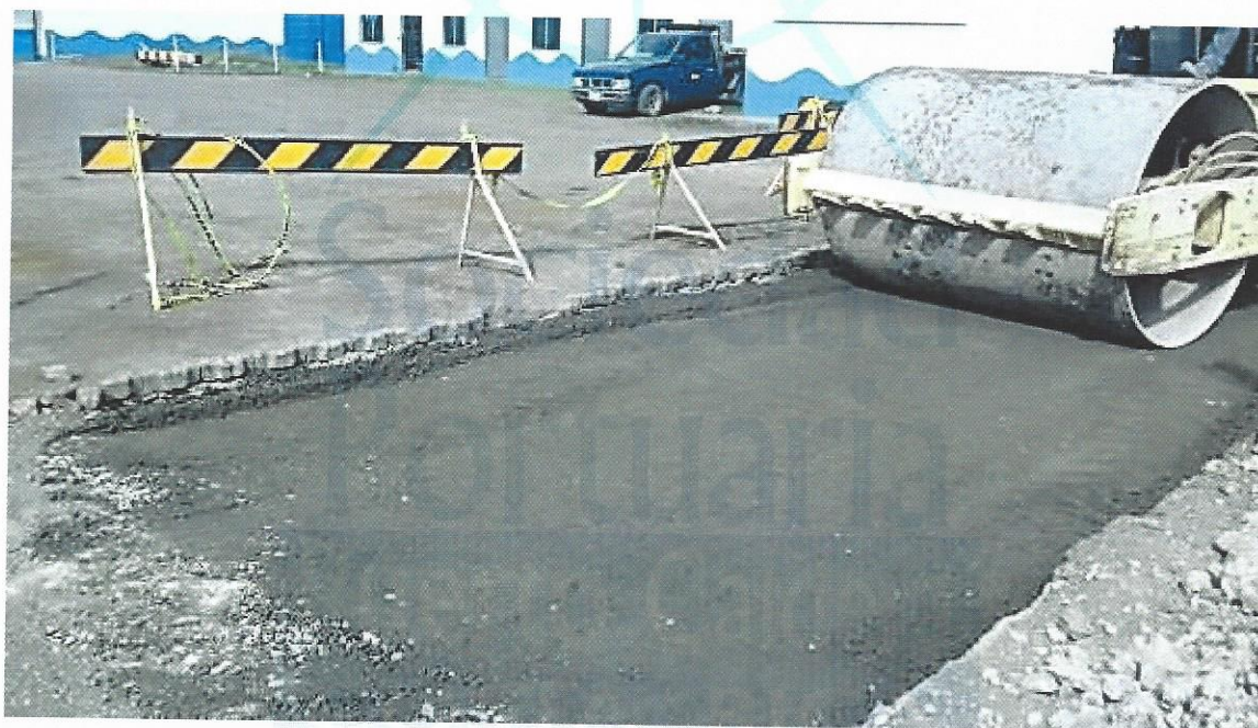
Figura 9. Colocación de base estabilizada en área de adoquines torre 6
