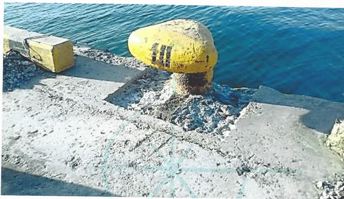
Figura 15. Demolición realizada alrededor de bases bitas
