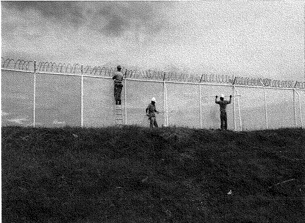
Figura 2. Mantenimiento de malla perimetral
