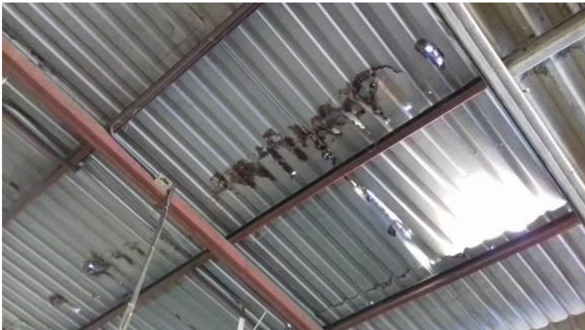
Figura 4. Cambio de láminas de techo dañadas en estancia del pañolero
