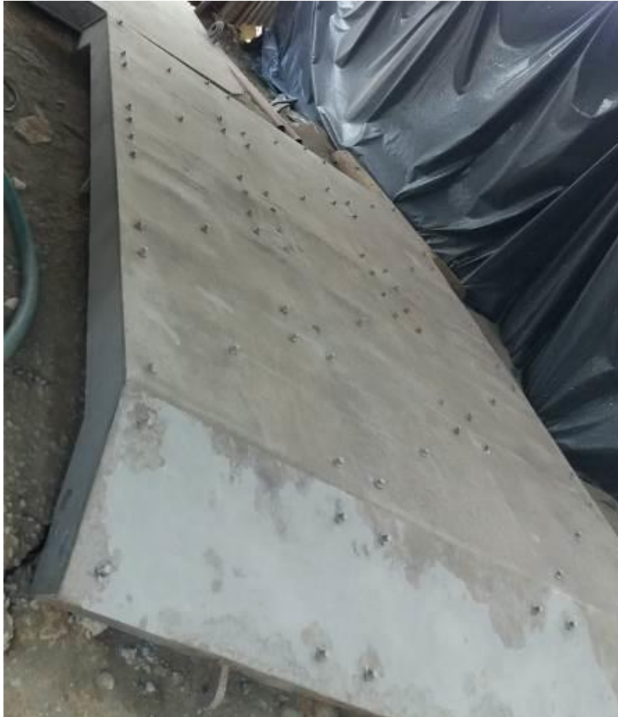
Figura 46. Panel defensa puesto uno en proceso de sand blasting
