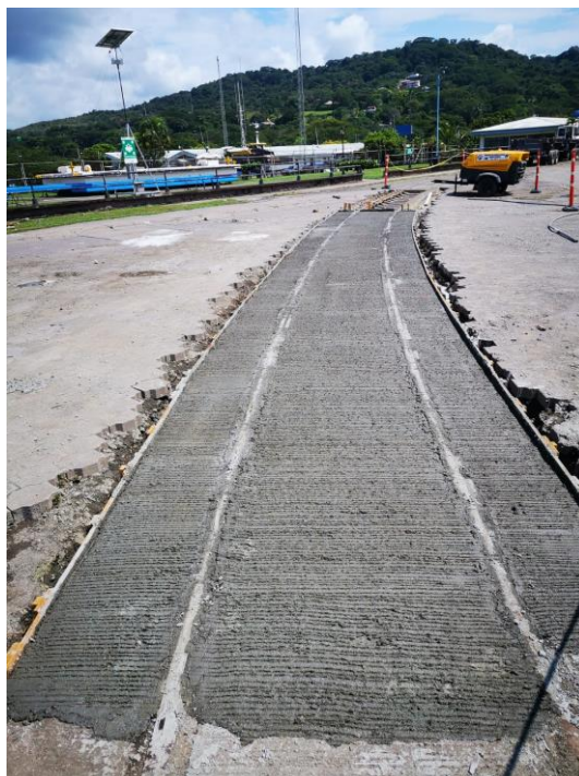
Figura 45. Colado de rieles con concreto premezclado alta resistencia
