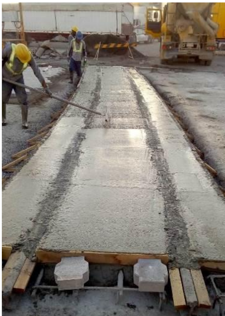
Figura 33. Colado entre líneas del tren en costado oeste caseta de vigilancia A-220
