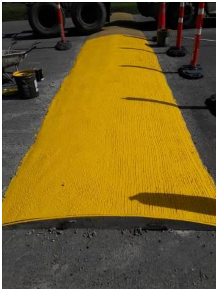
Figura 44. Confección y acabado de reductor sector de báscula uno
