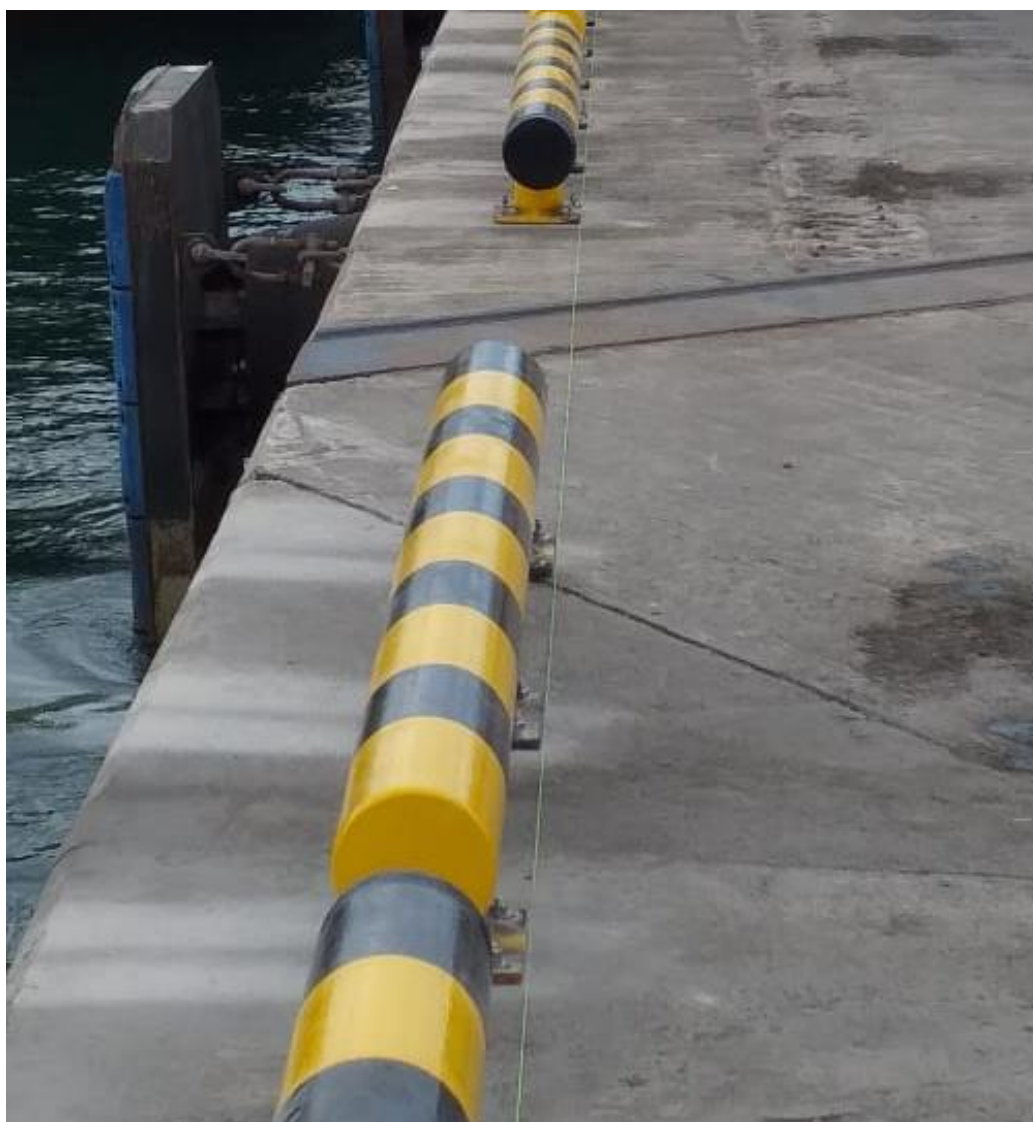
Figura 21. Instalación de nuevo diseño guardarruedas
