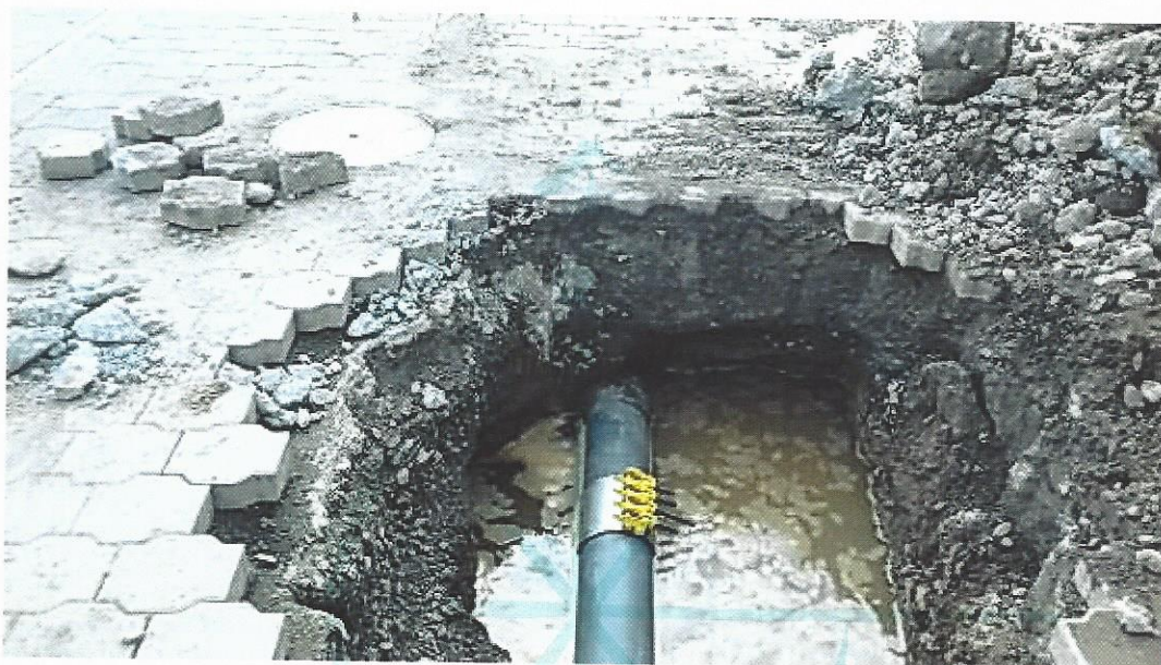
Figura 31. Reparación fuga de agua puesto dos
