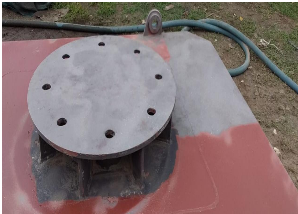
Figura 25. Intervención sand blasting
