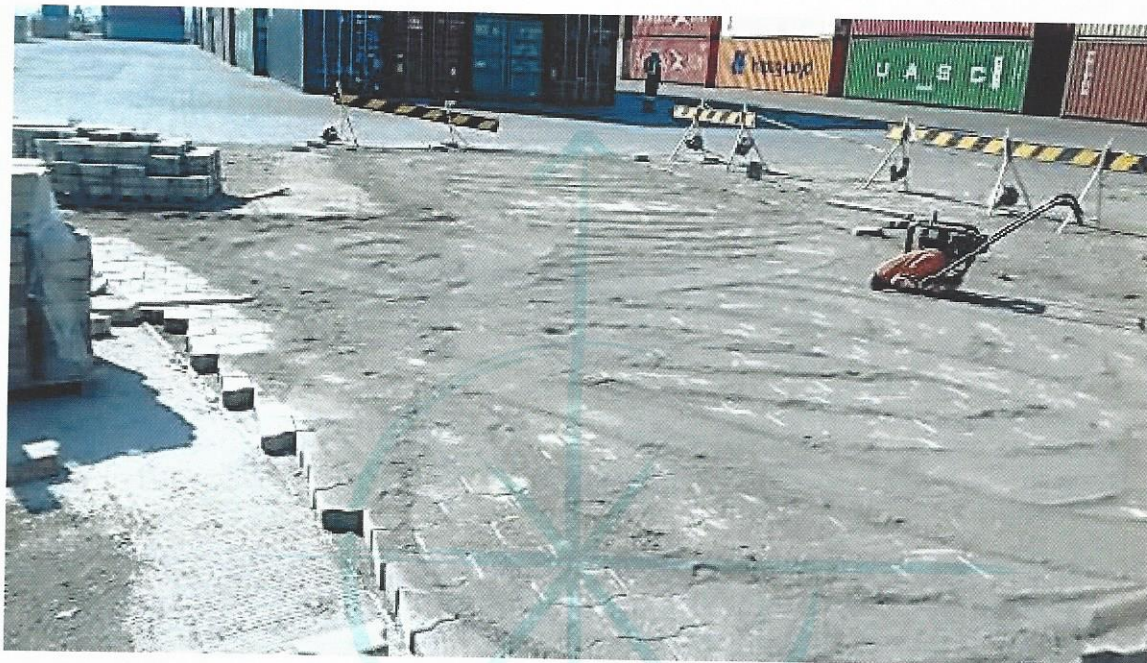
Figura 10. Colocación de adoquines en sector diagonal a torre 6
