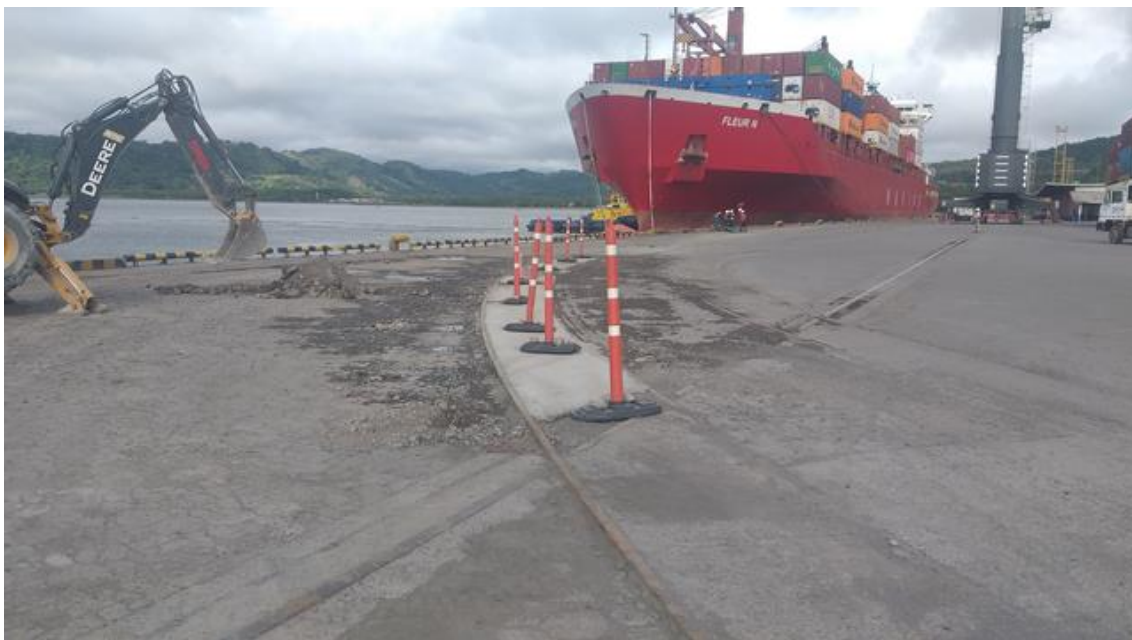
Figura 48. Intervención con concreto de alta resistencia en puesto 1
