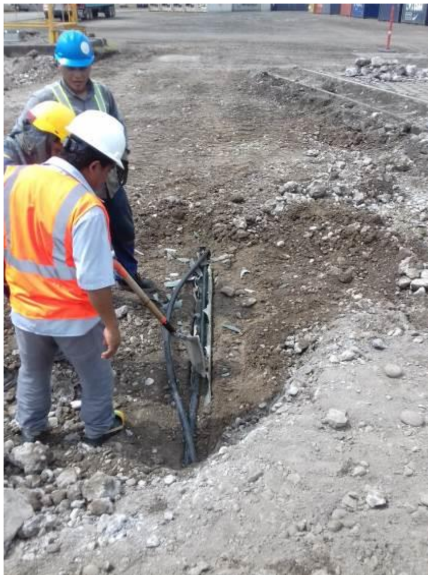
Figura 19. Trabajo previo al cambio del cable de media tensión dañado
