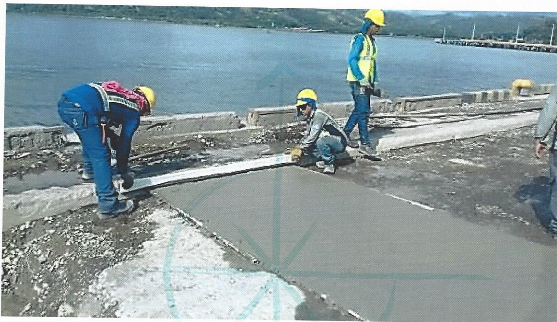
Figura 6. Preparación de base pavimento adoquines puesto dos
