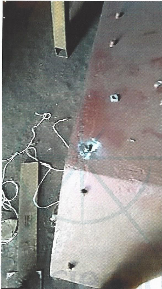
Figura 22. Mantenimiento de pintura y espárragos en panel de defensa marina 26 puesto 3
