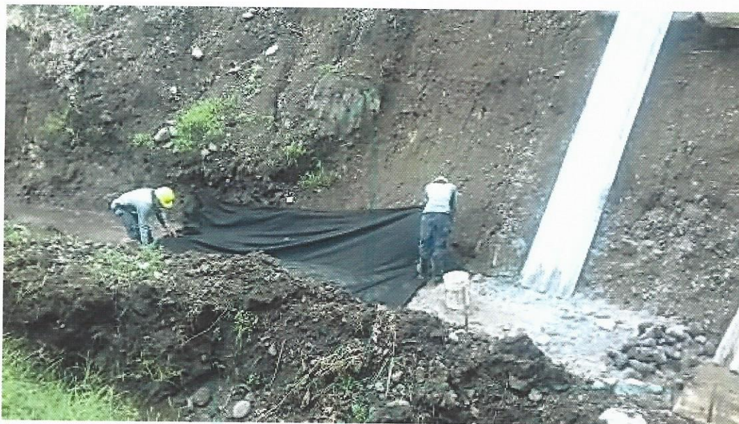
Figura 54. Proceso de colocación geotextil y revestimiento con piedra y mezcla
