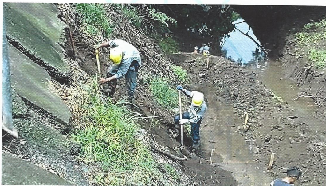
Figura 53. Preparación de las paredes del talud y fondo del canal
