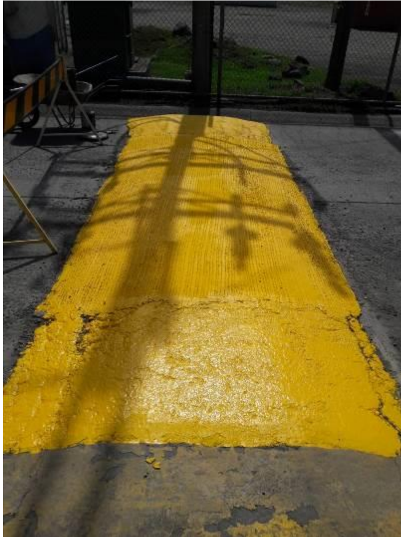
Figura 45. Confección y acabado de reductor de velocidad en el sector de eco 5
