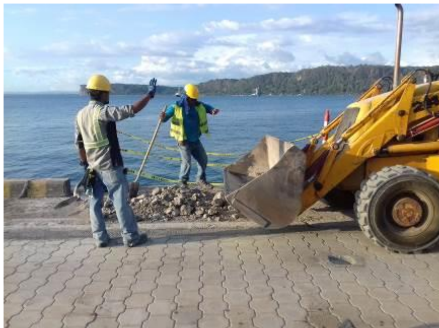
Figura 39. Trabajos de demolición de muros guardaruedas intervenidos
