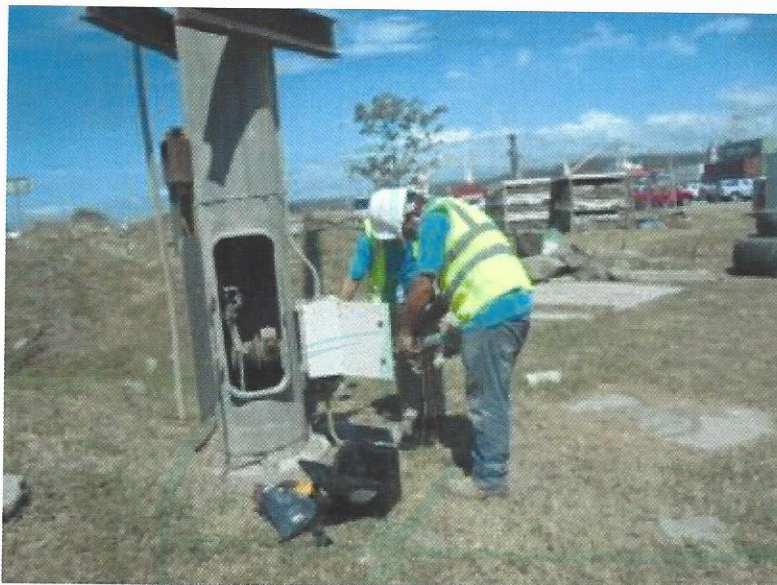
Figura 49. Revisión de desconectadores del sistema
