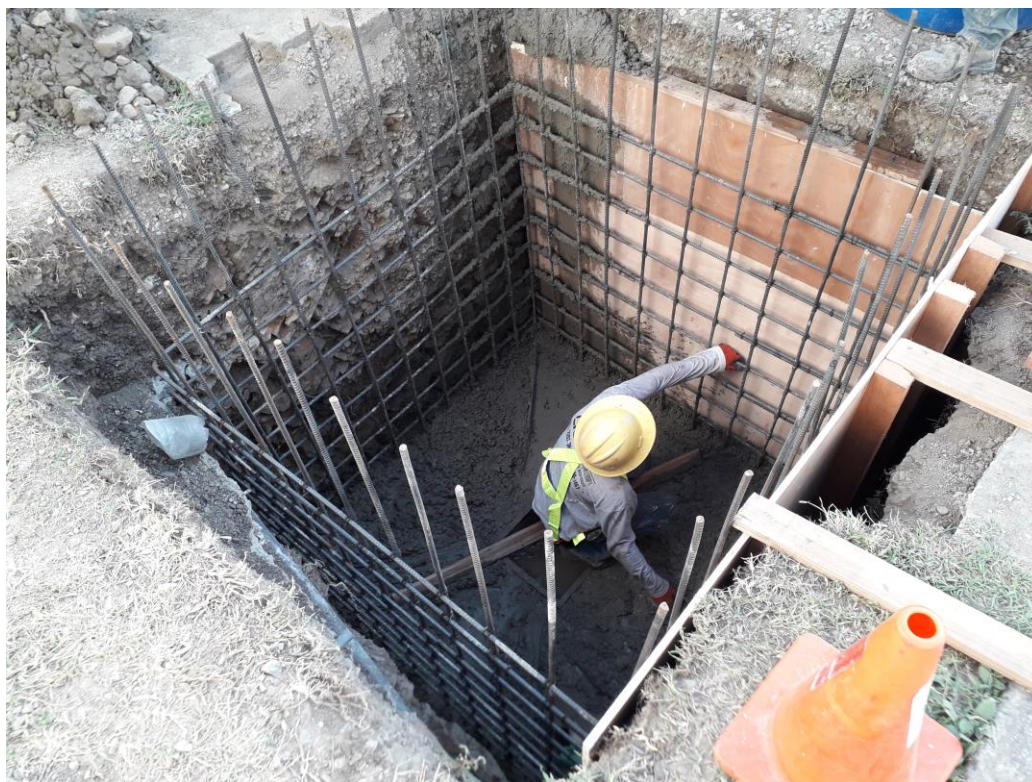
Figura 11. Proceso de armado caja de registro para transformador pedestal Edificio administrativo
