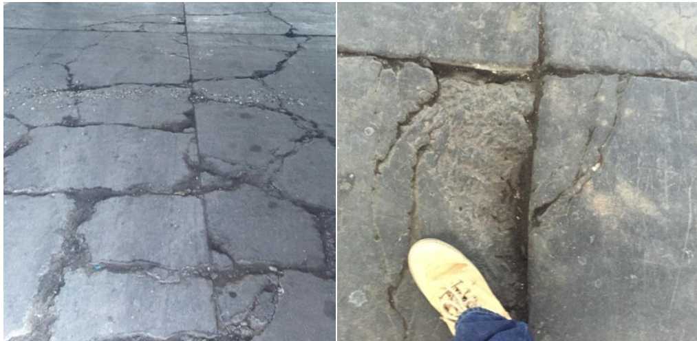
Figura 7. Losa de piso con fisuras y juntas en mal estado
