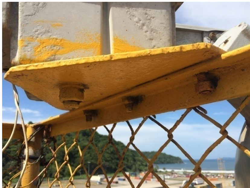
Figura 5. Anclaje indebido de luminaria
