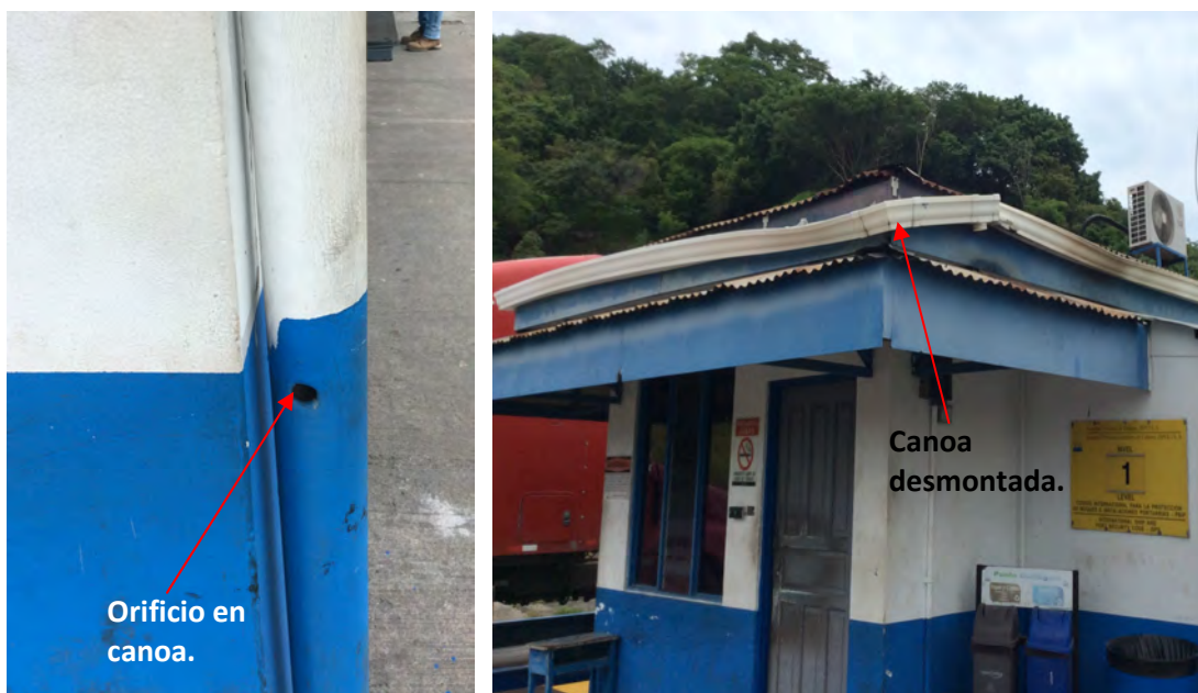
Figura 2.2. Estado de las canoas y bajantes.
