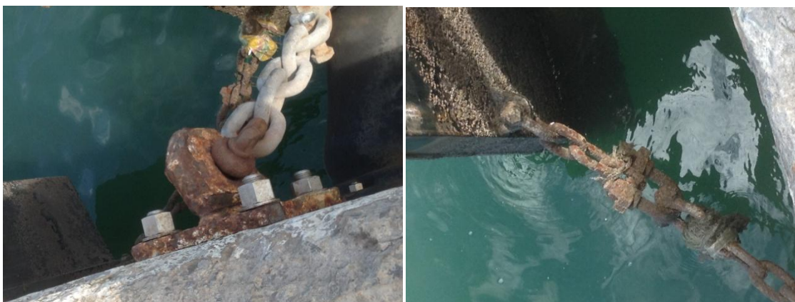
Figura 3. Defensas con deterioro por corrosión
