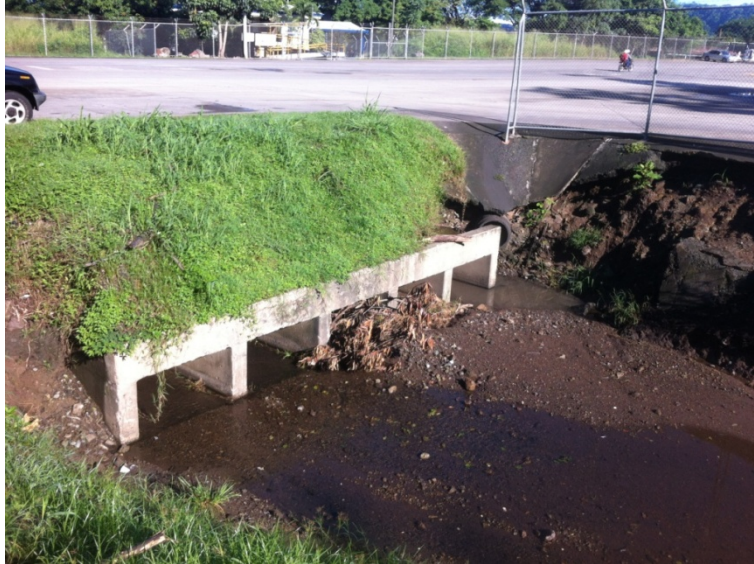
Figura 59. Alcantarilla de cuadro, son 5 cajones de aproximadamente 1.5m de ancho y 0.76m de altura. Además también se aprecia el efecto de erosión en margen derecha de canal.
