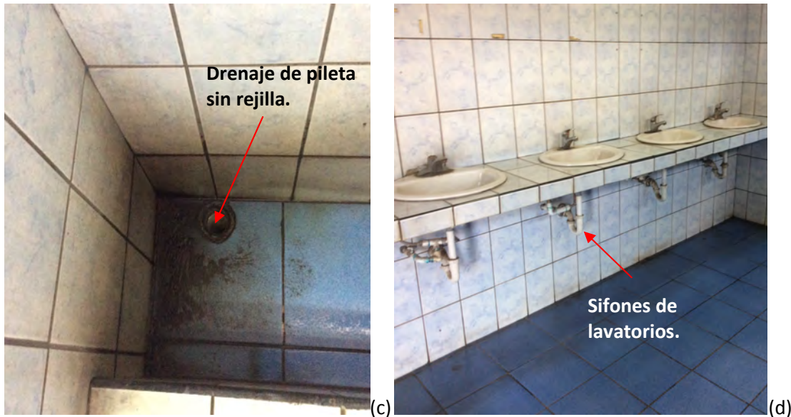
Figura 2.1 Llaves de baños donde se presentan fugas (a), desagüe sin rejilla de duchas y pileta (b) y (c), lavatorios con sus respectivos sifones (d).
