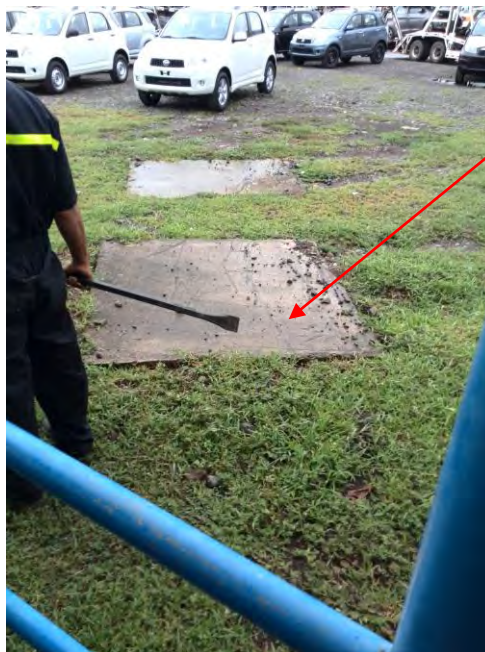
Figura 2.2 (c) Tanque séptico que recoge las aguas de los edificios A y V.
