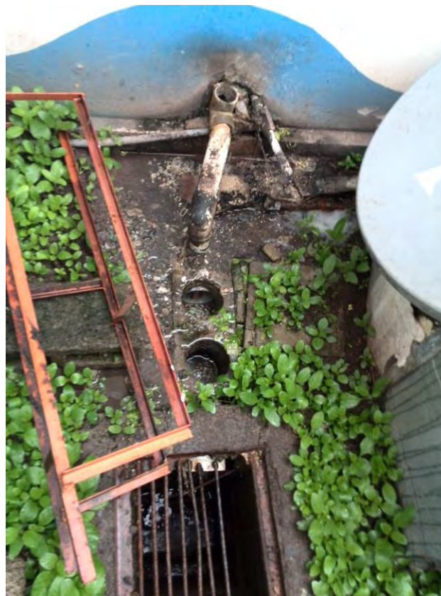
Figura 2.8 Trampa de aguas grasas del comedor principal del edificio A
