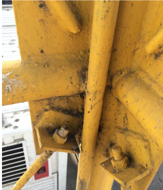
Figura 3. Conexiones de arriostres inadecuadas
