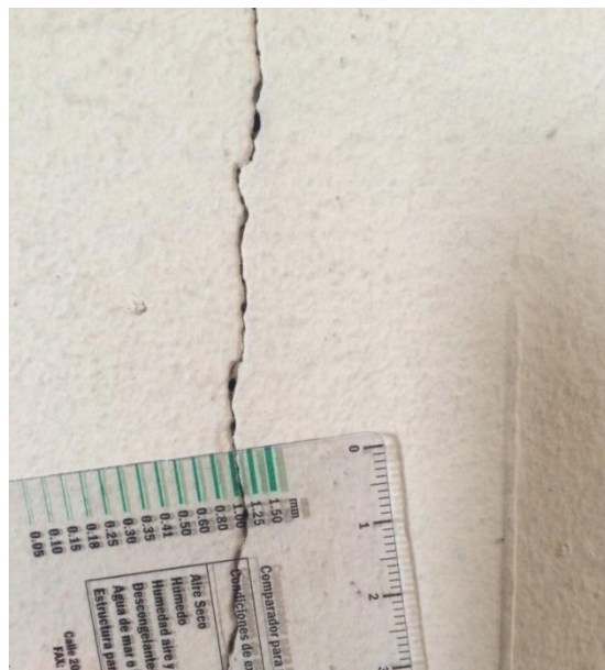
Figura 3. Fisura vertical en centro de paño de pared
