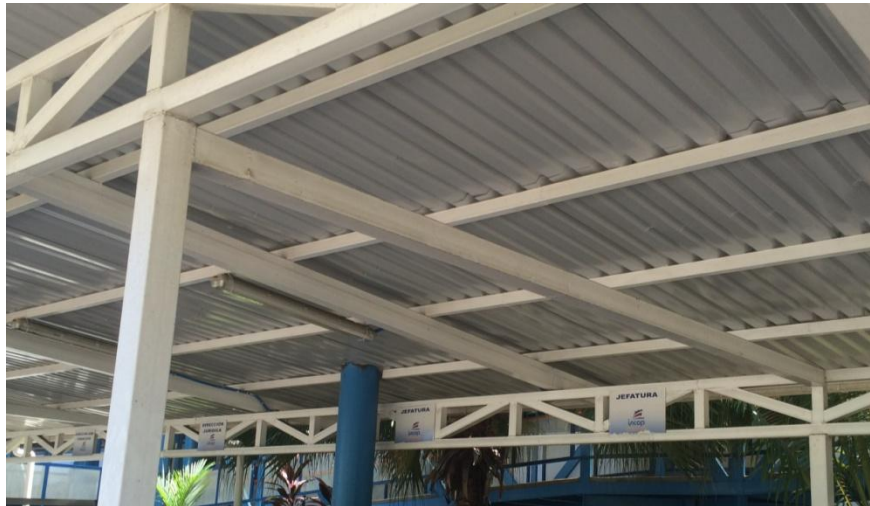
Figura 3. Marcos con arriostramiento inadecuado
