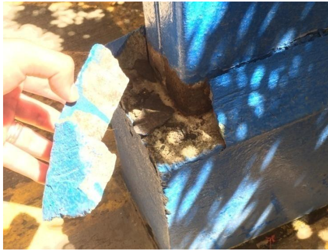
Figura 5. Corrosión en base de columna
