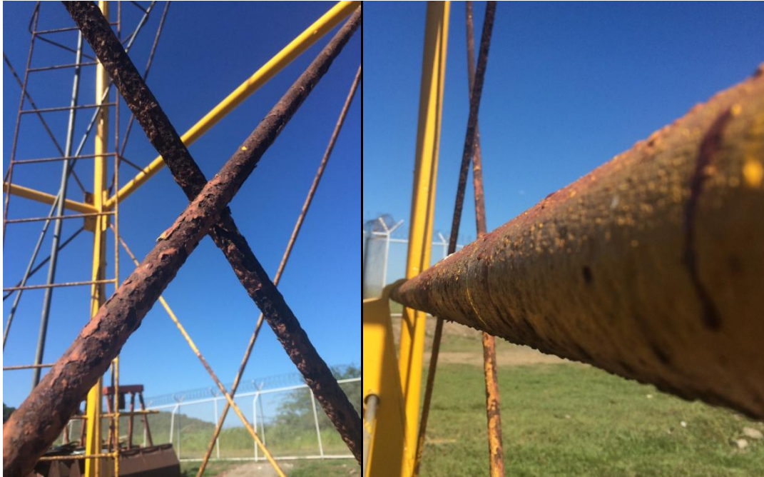
Figura 3. Corrosión excesiva en la estructura
