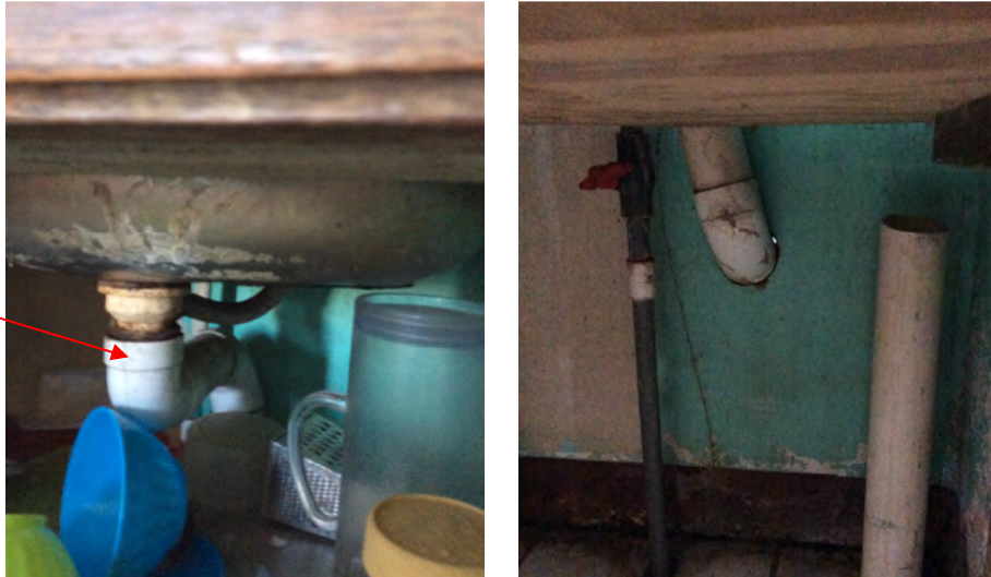
Figura 2.2. Desagüe de fregadero en cocina.
