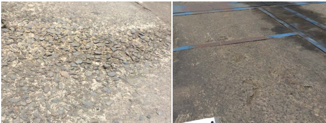
Figura 4. Losas con abrasión
