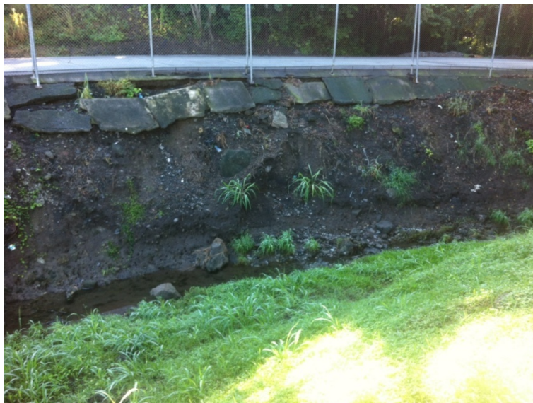
Figura 58. Erosión en margen derecha de canal. Es evidente el desprendimiento de la protección de concreto.
