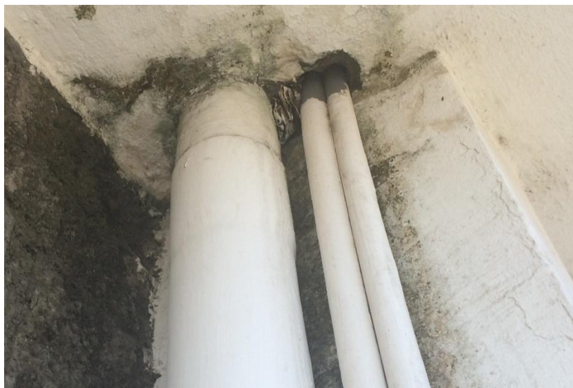
Figura 2. Pasantes de tuberías
