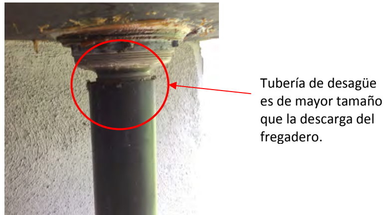
Figura 2.33. Desagüe de fregadero en las oficinas del MAG.
