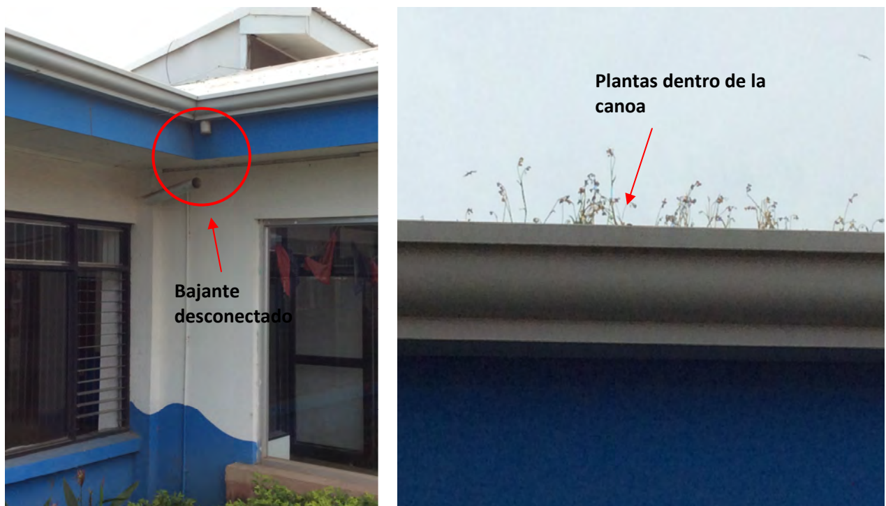
Figura 2.1. Canoas del sistema de aguas pluviales del edificio U.
