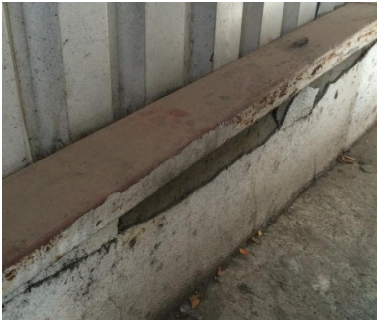
Figura 3. Viga debajo del portón de entrada con fisuras
