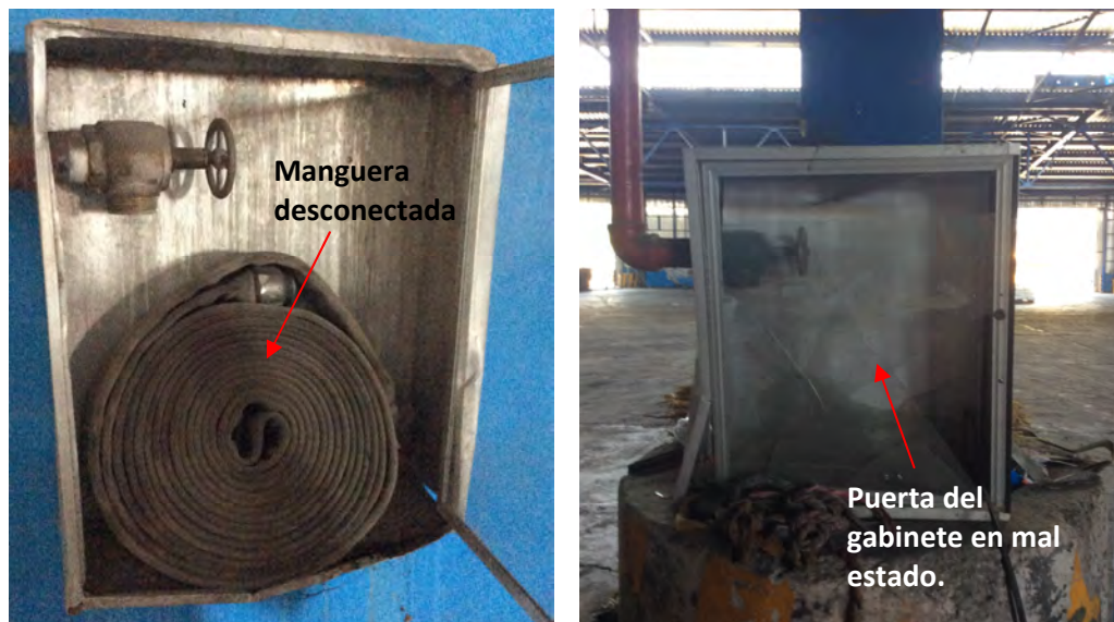
Figura 2.2. Gabinetes de sistema de supresión contra incendios.
