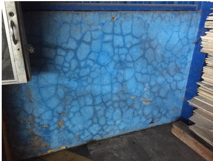
Figura 6. Repello de zócalo de mampostería en mal estado
