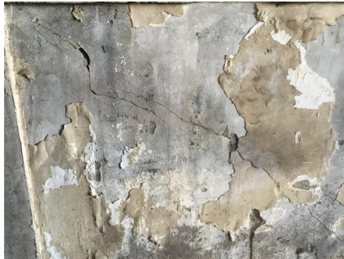
Figura 7. Fisura diagonal en zócalo de mampostería
