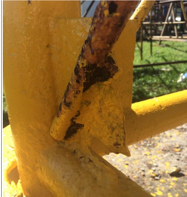
Figura 5. Unión de marco con arriostres con corrosión excesiva.
