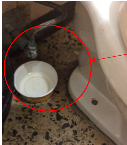
Figura 2.1. Fuga en tanque de inodoro en baño de tesorería.
