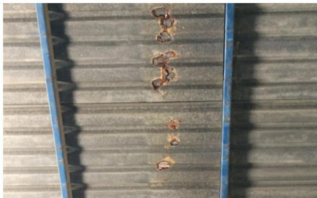
Figura 8. Cubierta de techo en mal estado
