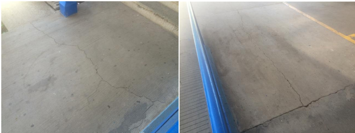
Figura 6. Losa de piso en mal estado
