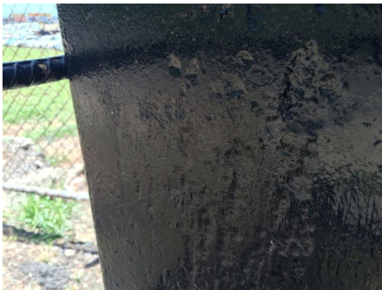
Figura 2. Porosidad en el pilar principal
