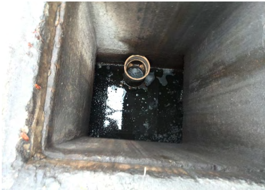
Figura 2.4 (a) Tanque séptico para las aguas de las oficinas administrativas del edificio K y O.
