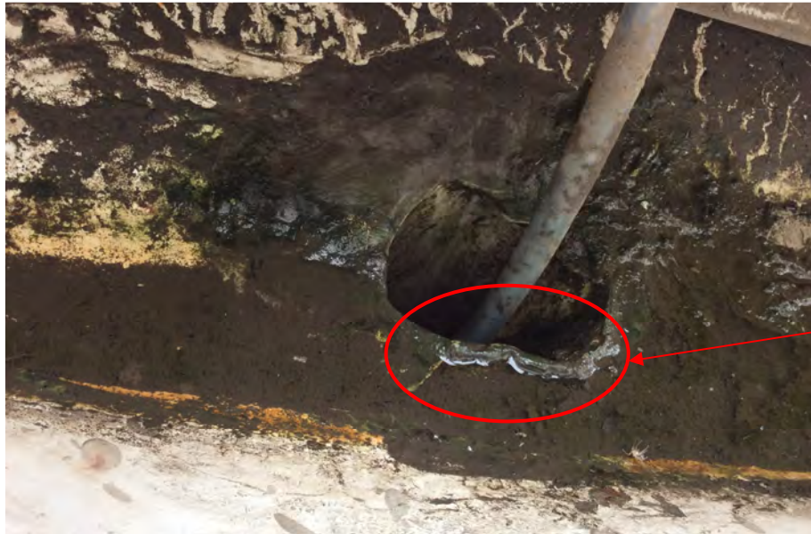
Figura 2.50. Boquilla de canoa de techo de primer nivel.
