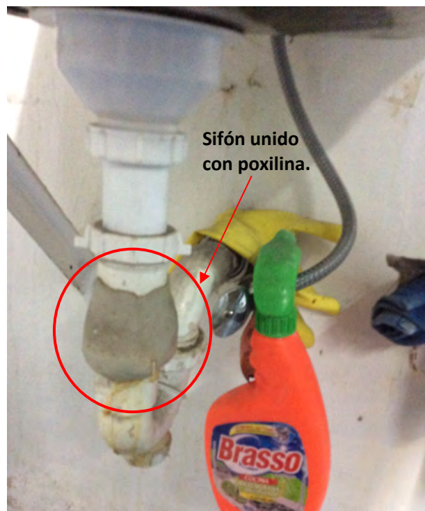
Figura 2.4. Sifón mal conectado.
