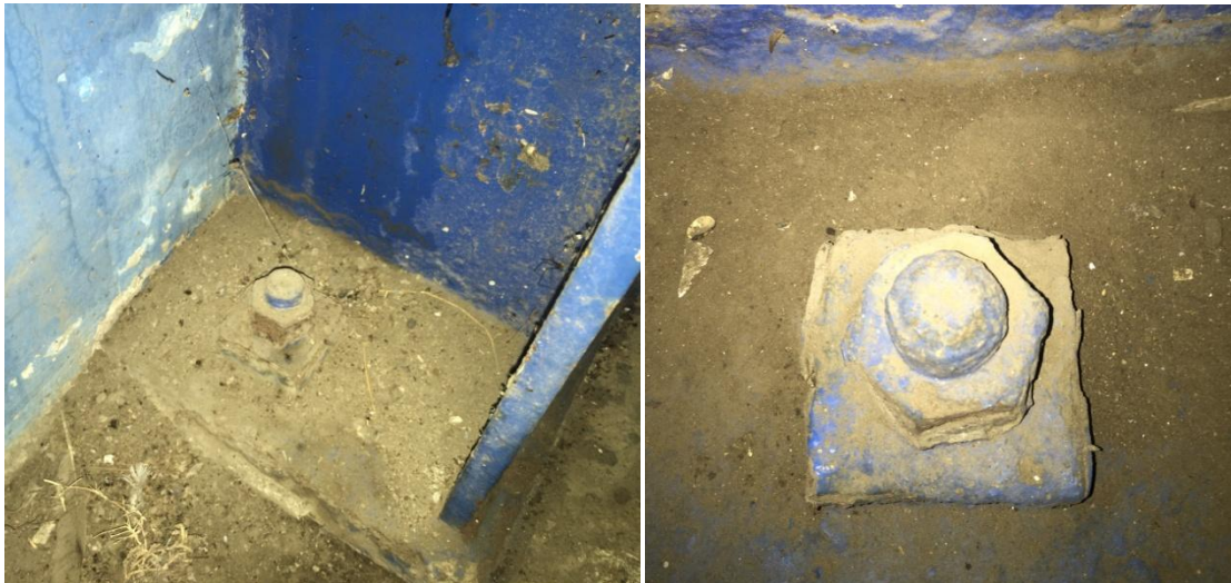
Figura 6. Óxido en placas de columnas y pernos
