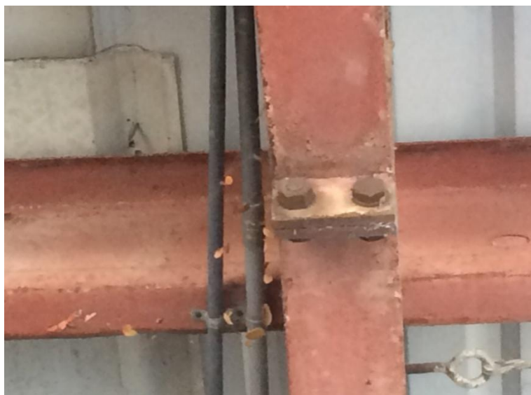
Figura 7. Pernos con corrosión
