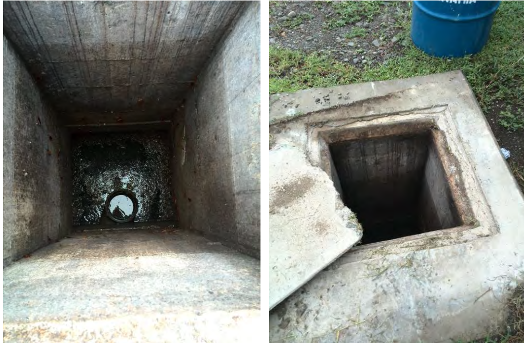
Figura 2.2 (a), (b) Tanque séptico que recoge las aguas de los edificios A y V.
