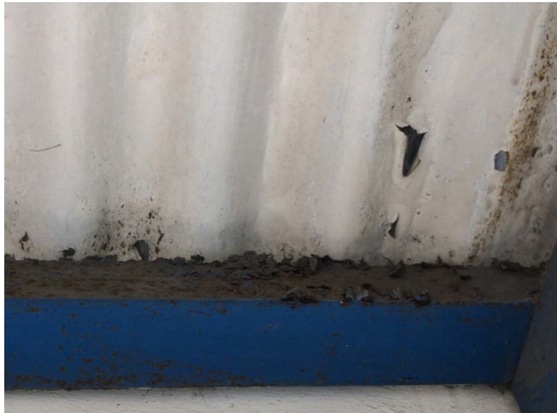
Figura 5. Estructura de techo con corrosión
