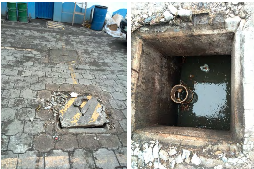
Figura 2.5 (a), (b) Tanque séptico para las aguas de los edificios P y Q.
