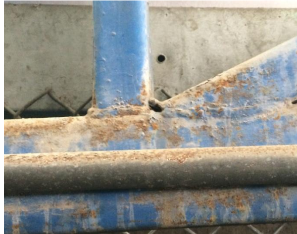
Figura 7. Soldaduras en mal estado
