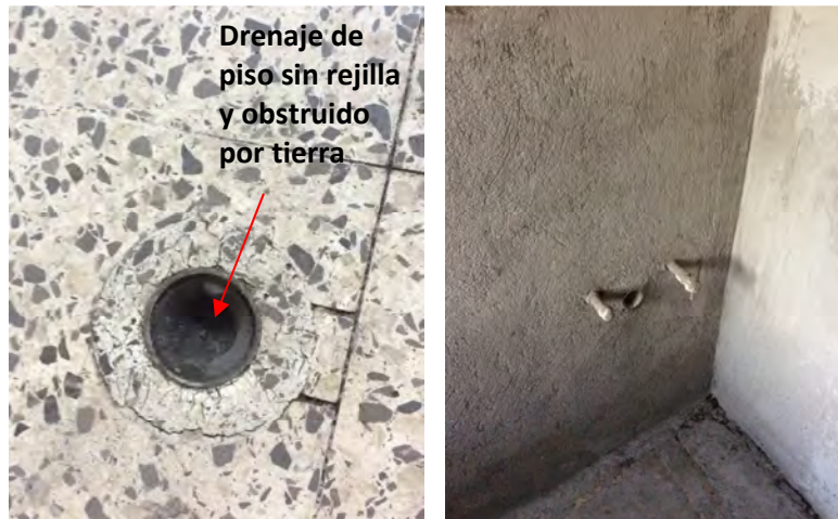
Figura 2.5. Previstas en segunda planta, drenajes obstruidos.
