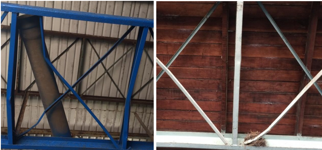
Figura 7. Estructura de entrepiso de mezzanine en mal estado.
