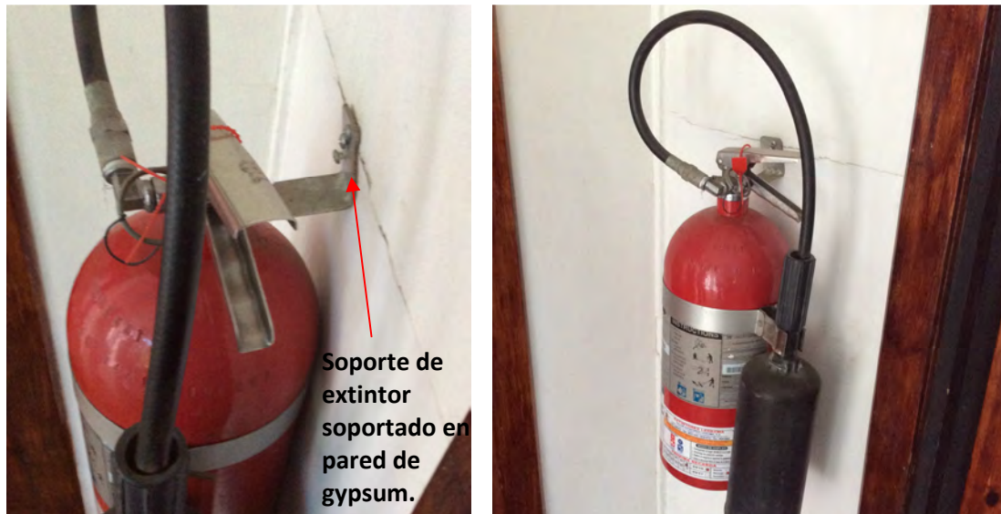
Figura 2.4. Extintor soportado en pared de gypsum.
