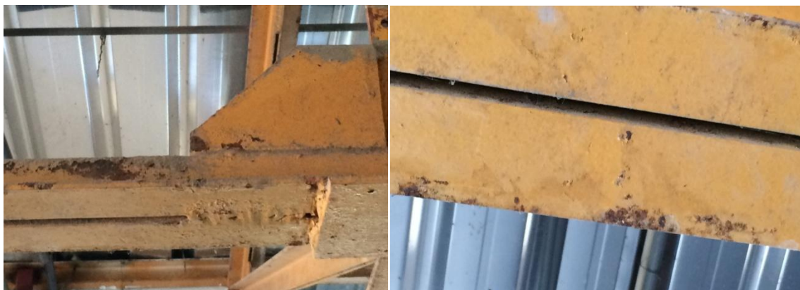
Figura 3. Corrosión en elementos estructurales
