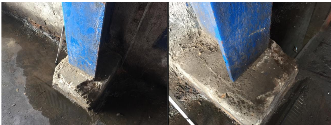
Figura 9. Pedestales deteriorados
