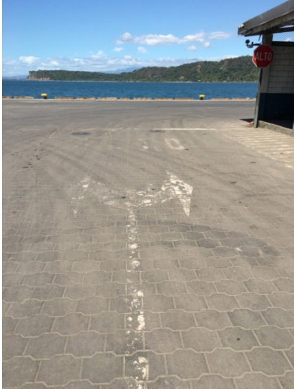
Figura 30. Deterioro de señal horizontal en calle 2
