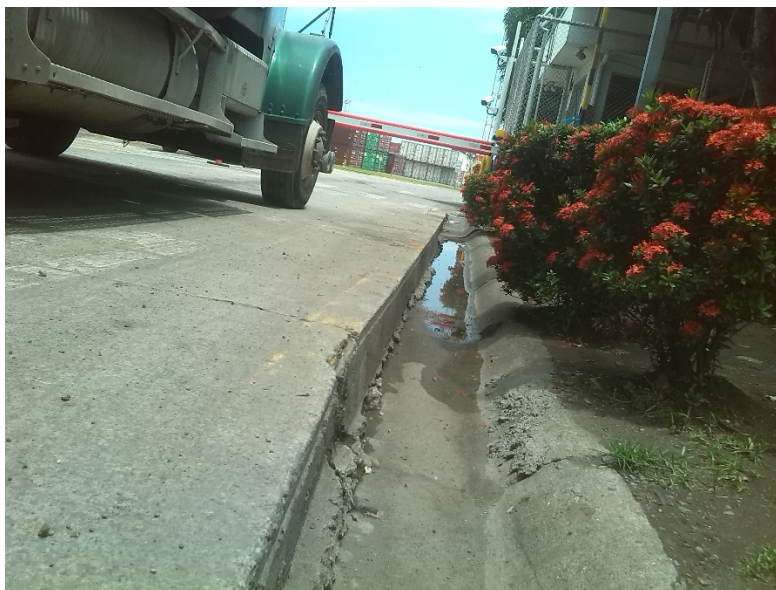
Figura 19. Falta de Soporte en Espaldón
