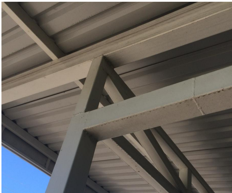
Figura 2. Elementos verticales con discontinuidades
