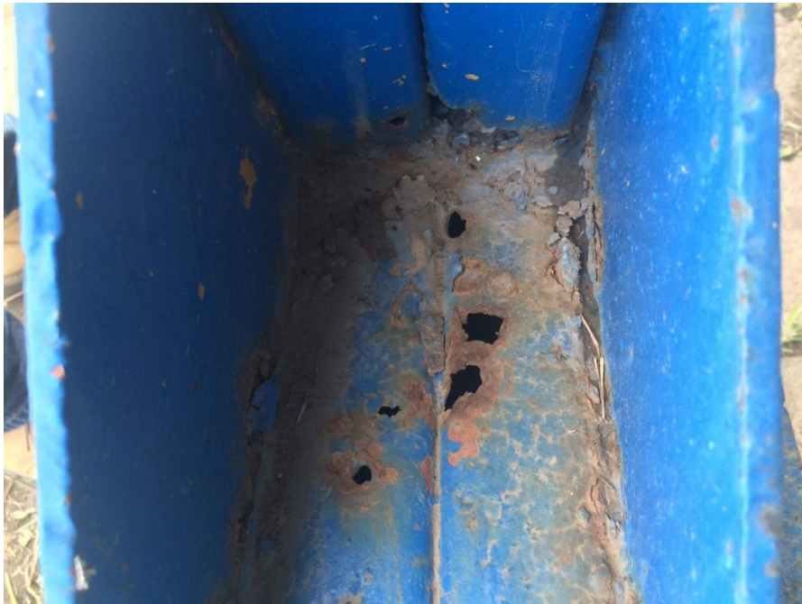
Figura 10. Acumulación de agua en uniones
