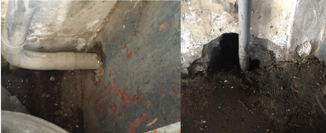
Figura 5. Instalaciones eléctricas atravesando elementos estructurales sin el detalle correcto.
