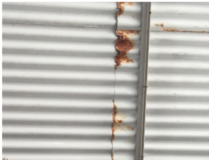
Figura 6. Cubierta de techo presenta corrosión
