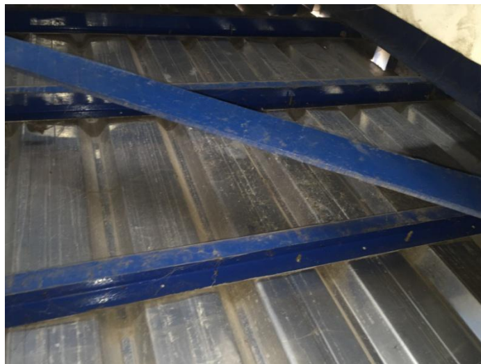
Figura 2. Arriostramiento lateral de marcos de nave industrial
