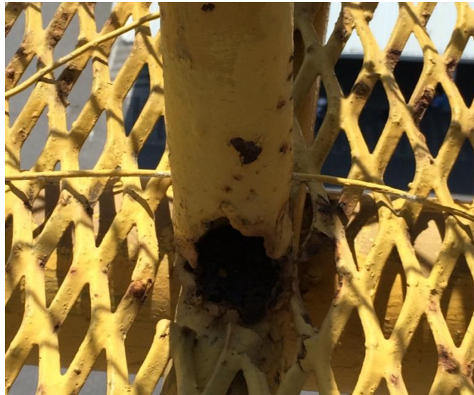
Figura 5. Soldaduras presentan corrosión y están mal confeccionadas
