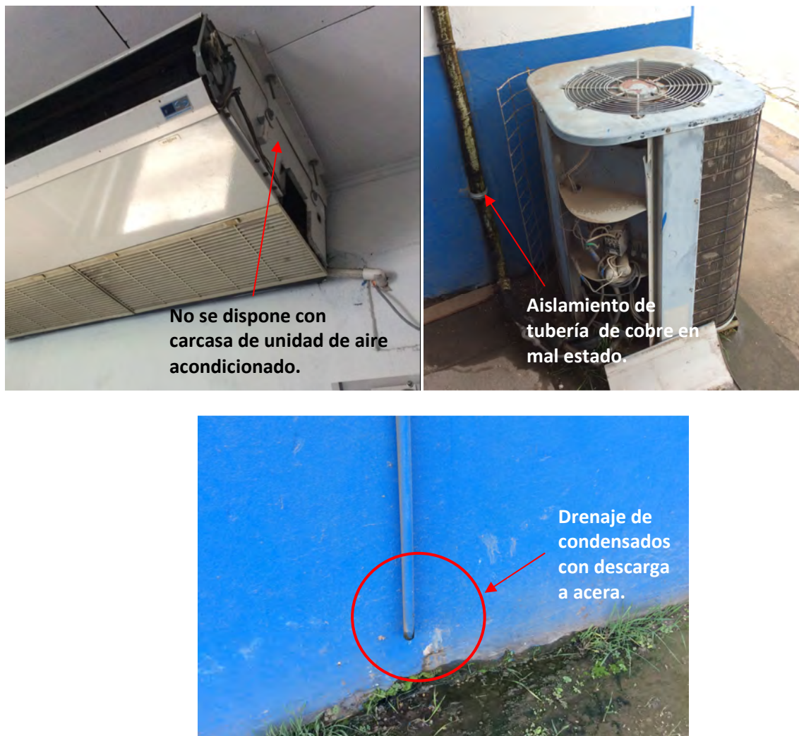
Figura 2.1. Unidad de aire acondicionado del edificio E.
