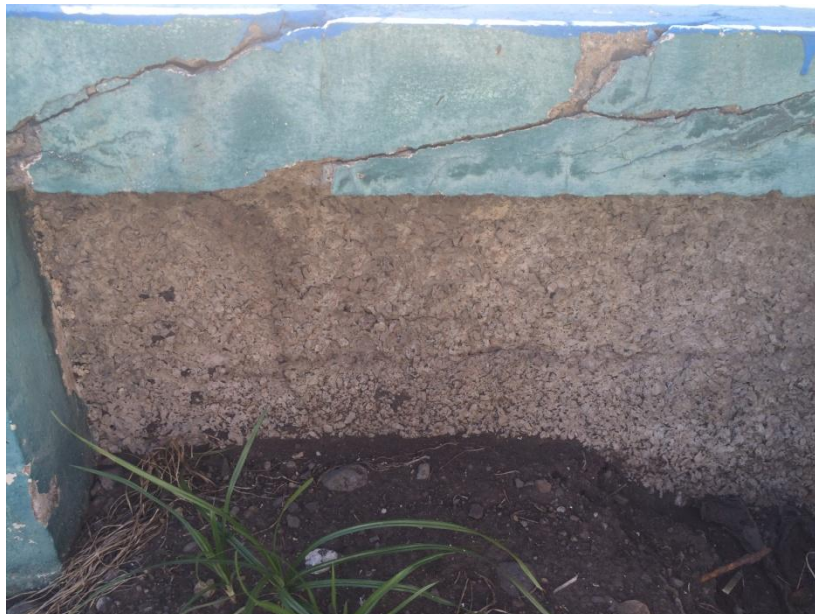
Figura 7. Zócalo de mampostería en mal estado
