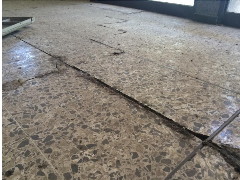
Figura 6. Patrón de falla en contrapiso
