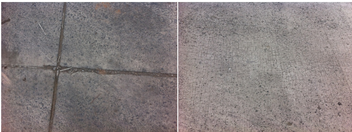
Figura 10. Mal Estado de Juntas con Pulimiento de agregados y Grietas en malla
