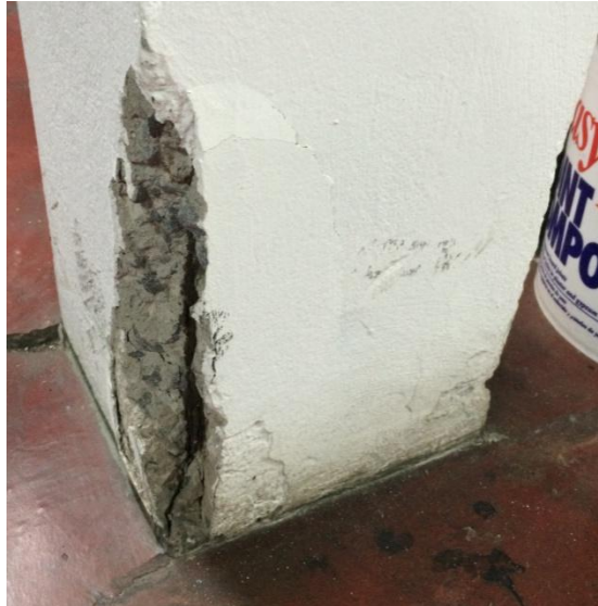
Figura 5. Fisura en columna
