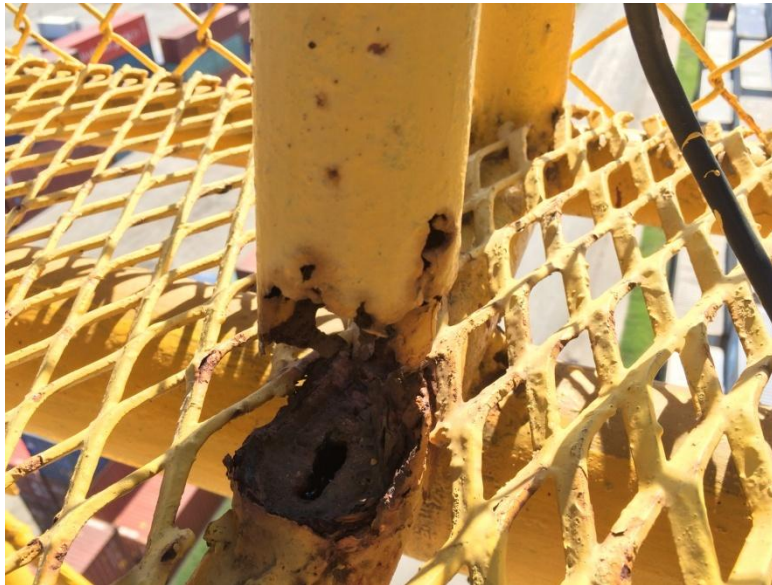
Figura 4. Plataforma de Jordomex deteriorada por corrosión.
