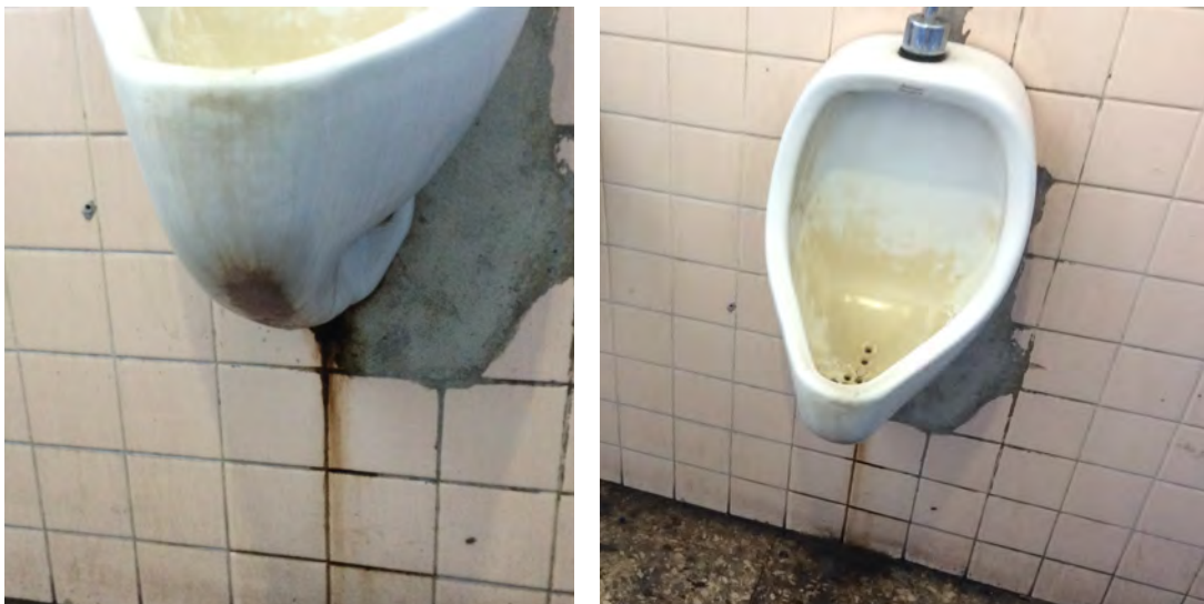
Figura 2.7. Fuga en orinales.
