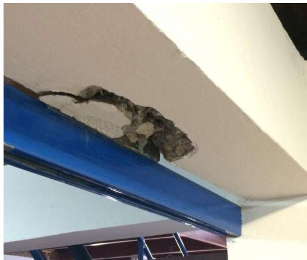
Figura 2. Viga con pérdida de recubrimiento.
