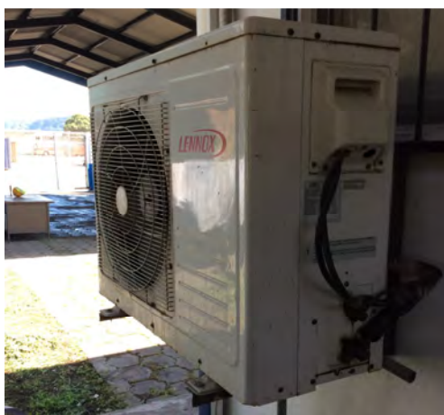
Figura 2.6. Condensador de aire acondicionado en cuarto sucio.
