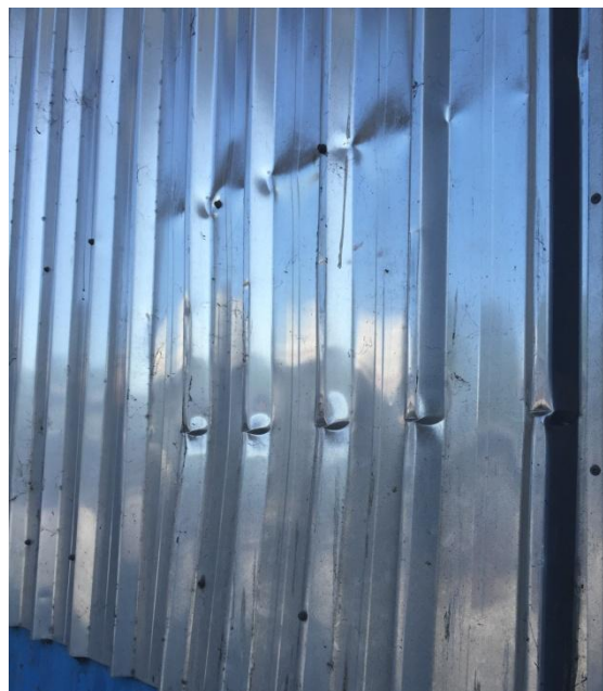
Figura 8. Lámina de cerramiento golpeada
