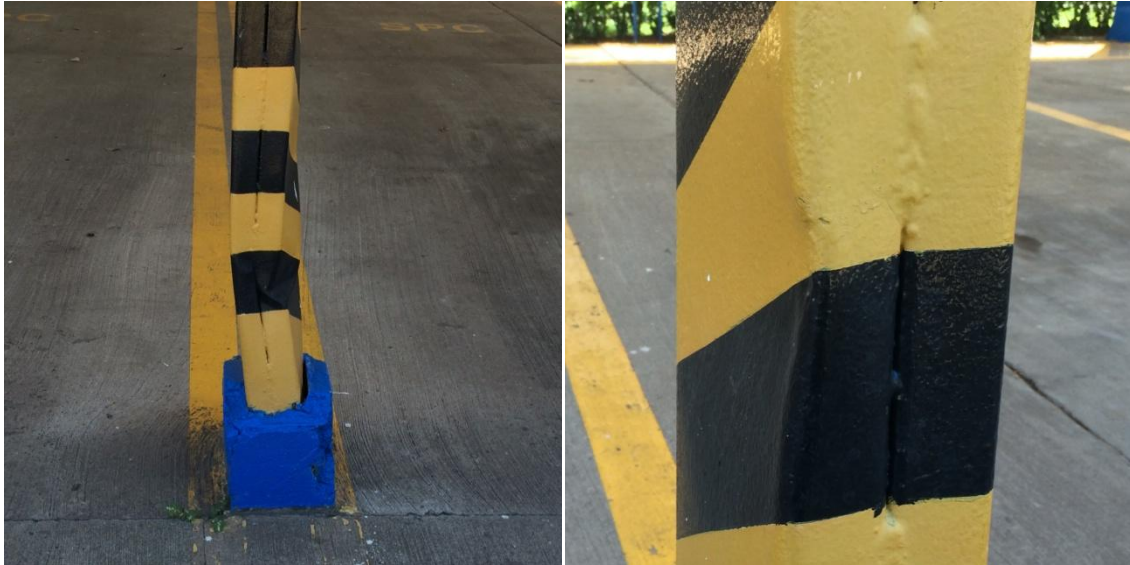
Figura 3. Pandeo en bases de columnas
