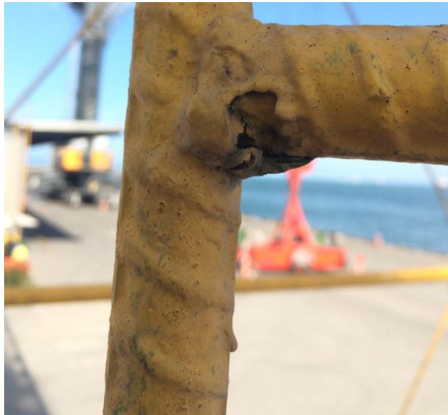
Figura 8. Elemento con pintura sin tratamiento adecuado
