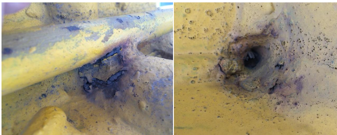
Figura 7. Corrosión en elementos metálicos
