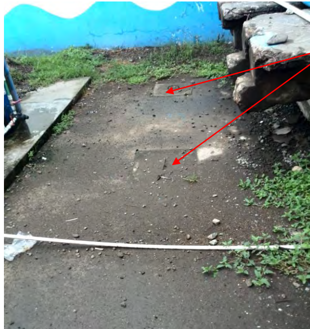
Figura 2.3 Tanque séptico que recolecta las aguas de los edificios L, M y N.
