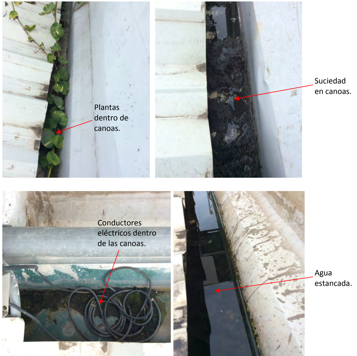
Figura 2.49. Suciedad y obstrucciones en las canoas de primer nivel del edificio A.
