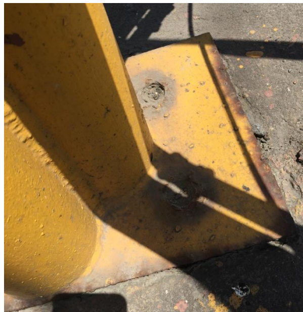
Figura 6. Pernos faltantes en placa de asiento
