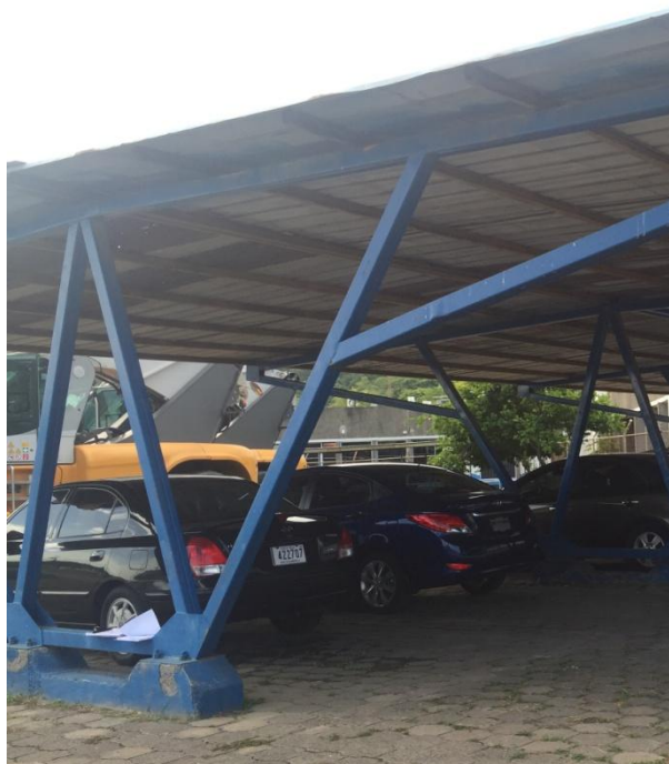
Figura 2. Discontinuidad en zona de unión entre diagonal y columna
