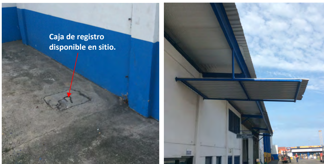
Figura 2.2 Techo y caja pluvial de edificio I.
