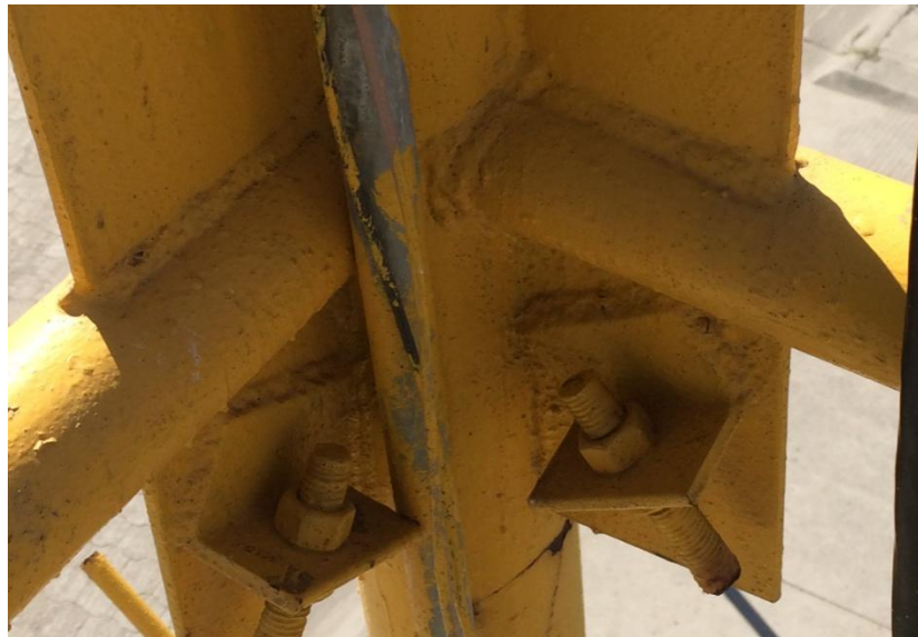
Figura 8. Soldaduras mal confeccionadas y con porosidad
