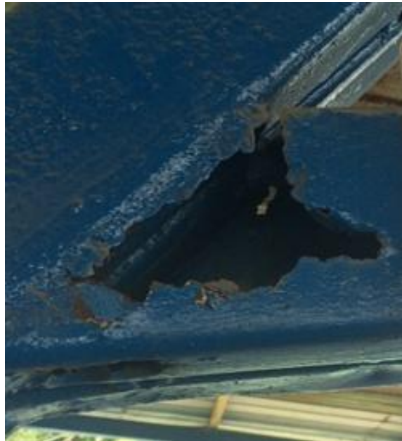
Figura 8. Pérdida de volumen de elementos estructurales por corrosión
