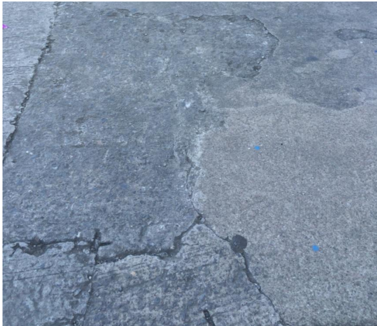
Figura 3. Abrasión de losa de piso en exterior del edificio
