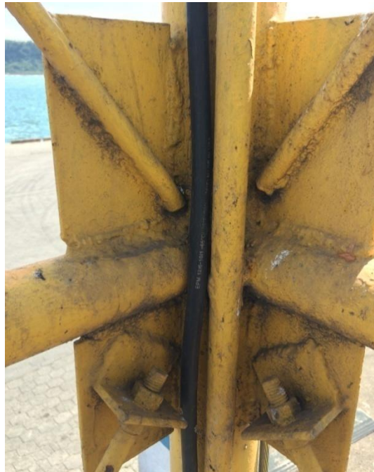
Figura 3. Elemento con pintura mal colocada
