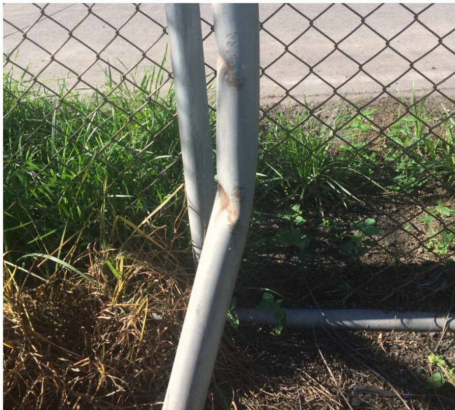
Figura 2. Deformaciones en tubos de acero de la malla
