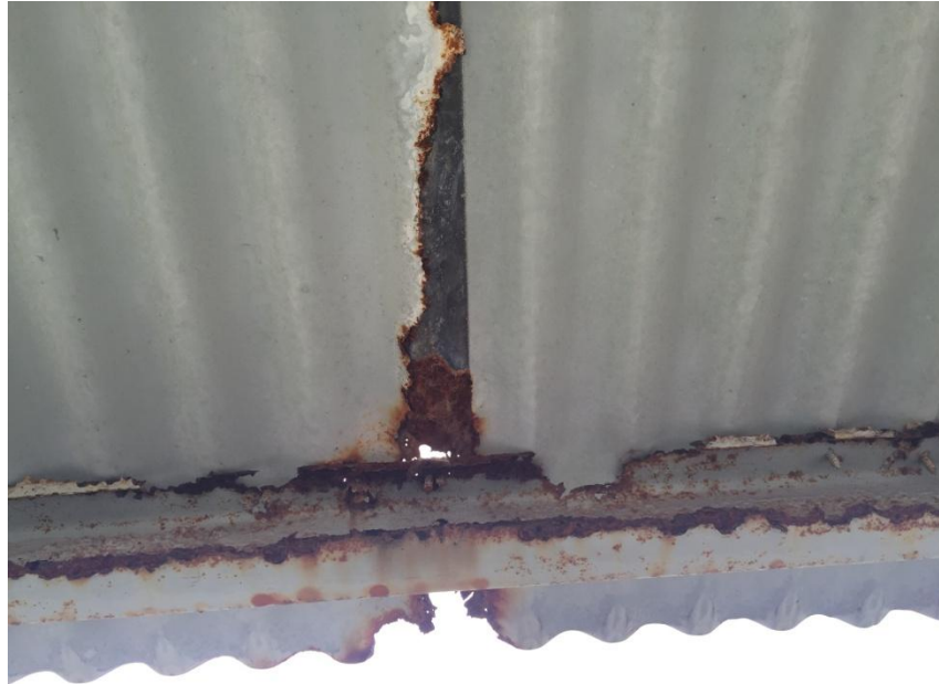
Figura 3. Corrosión en largueros
