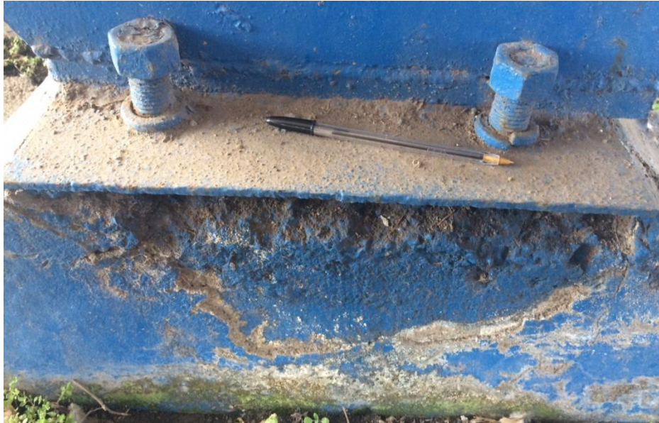
Figura 3. Pernos mal ajustados e inadecuado contacto entre placa de asiento y pedestal
