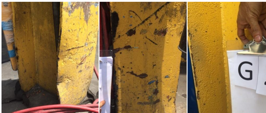
Figura 6. Bases de columnas oxidadas, golpeadas y con porosidad
