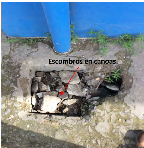
Figura 2.3. Canoas en mal estado (a), caja de registro obstruida (b), sistema de bajantes del edificio E (c).
