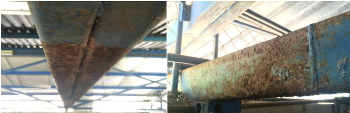
Figura 6. Corrosión en elementos estructurales
