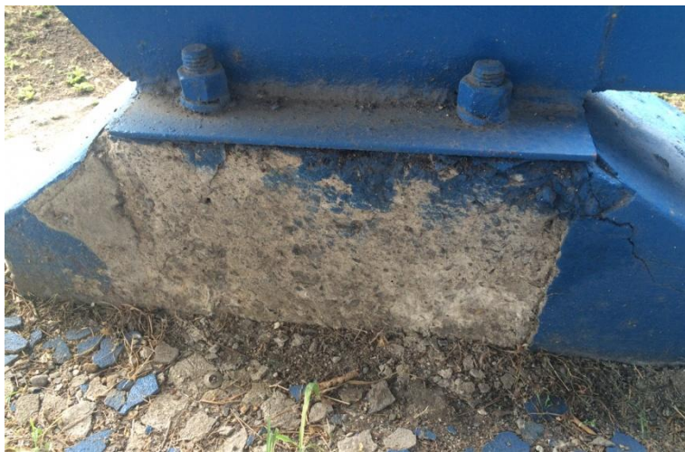
Figura 5. Pérdida de recubrimiento del concreto
