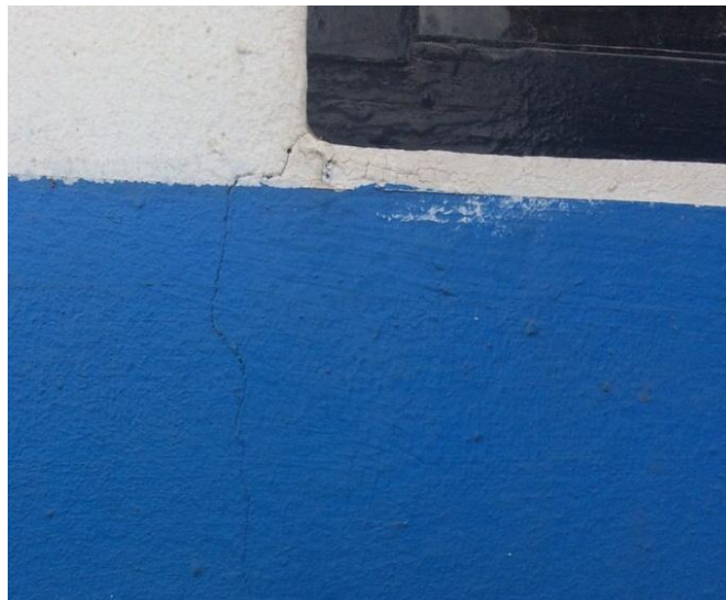
Figura 2. Fisura diagonal en esquina de ventana
