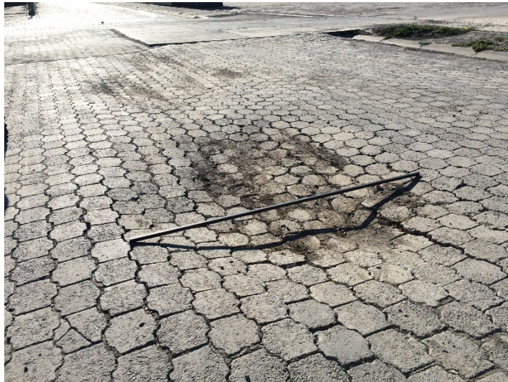
Figura 13. Hundimiento con Severidad Alta en AV3-8
