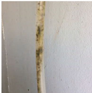
Figura 2.23. Manguera de condensados de la unidad mini split de la cabina del cajero automático del BCR.
