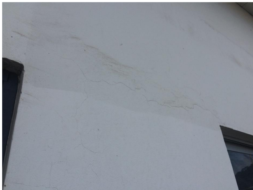
Figura 4. Grietas superficiales en repello
