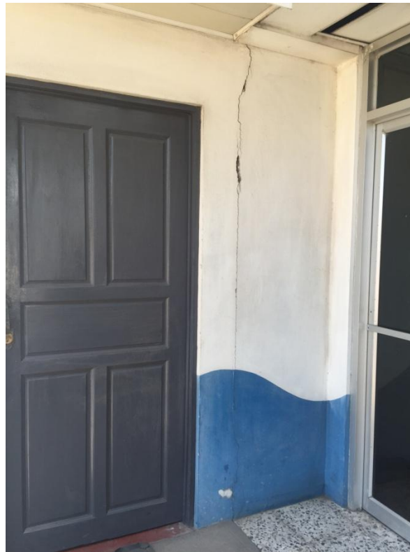
Figura 2. Fisura en unión con edificio anexo
