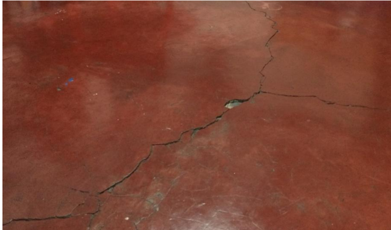
Figura 8. Fisuras en losa de piso
