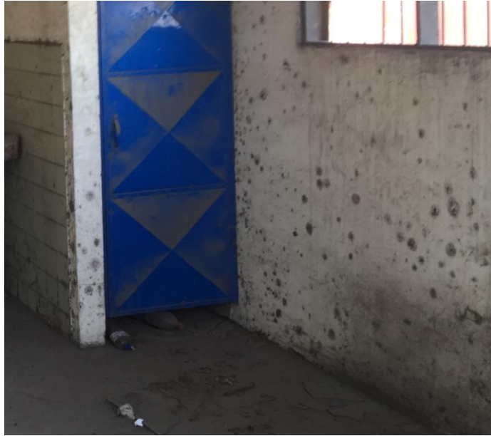
Figura 3. Repello de paredes en mal estado
