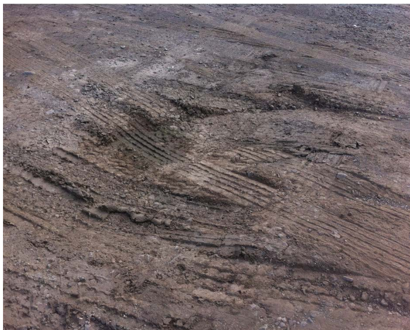
Figura 12. Daños frecuentes en Patios de lastre
