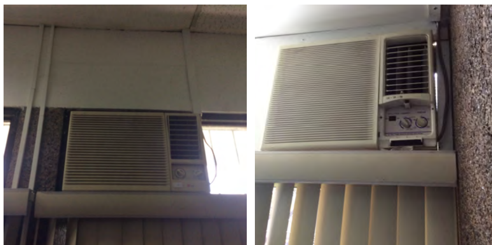
Figura 2.32. Aires acondicionados tipo ventana, ubicados en las oficinas del MAG-Agricultura.
