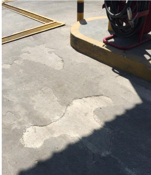
Figura 6. Abrasión en la losa de piso
