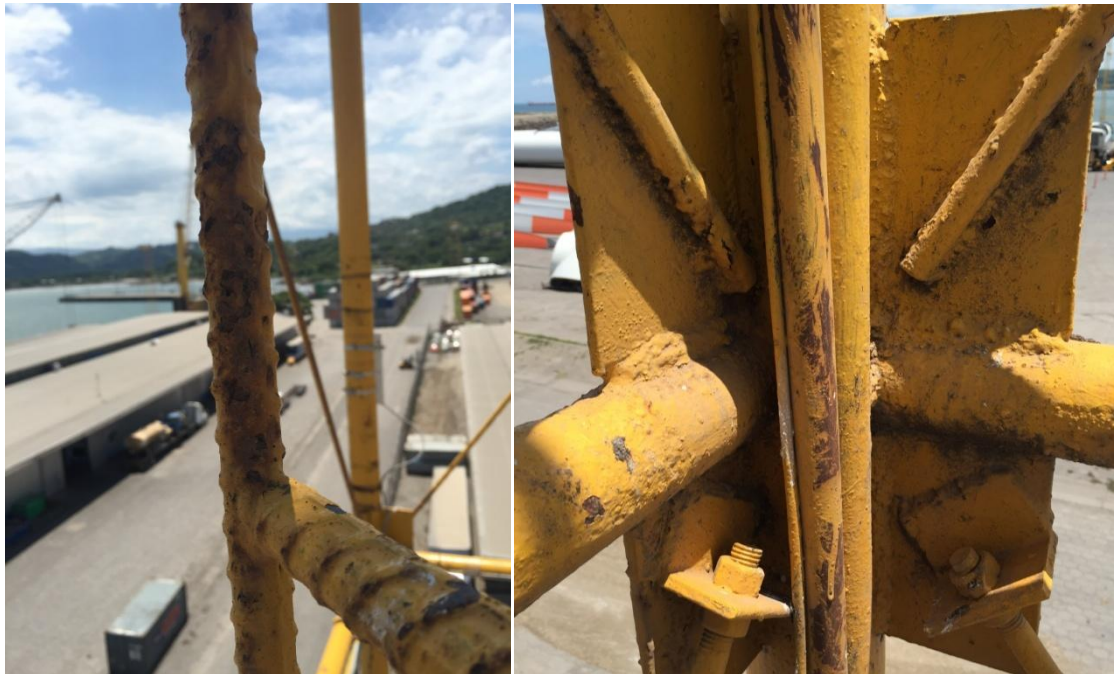
Figura 8. Corrosión en escalera y angular.
