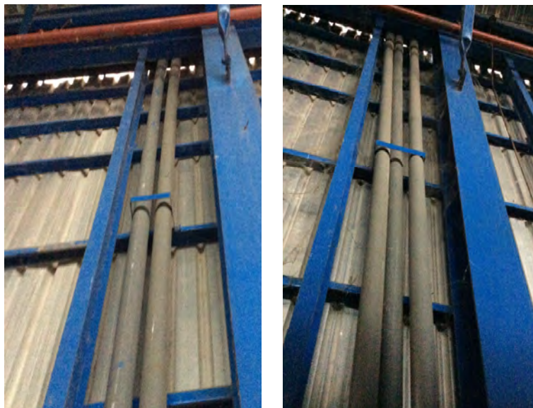
Figura 2.5. Bajantes de las canoas del techo de la bodega.
