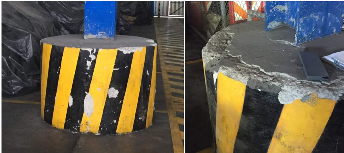
Figura 3. Pedestales protectores con deterioro leve.
