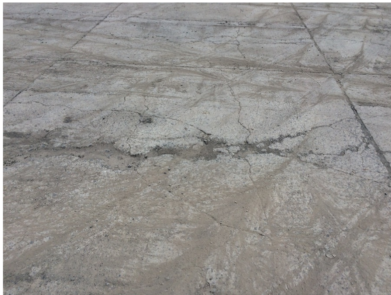
Figura 17. Losa Dividida con Severidad Alta
