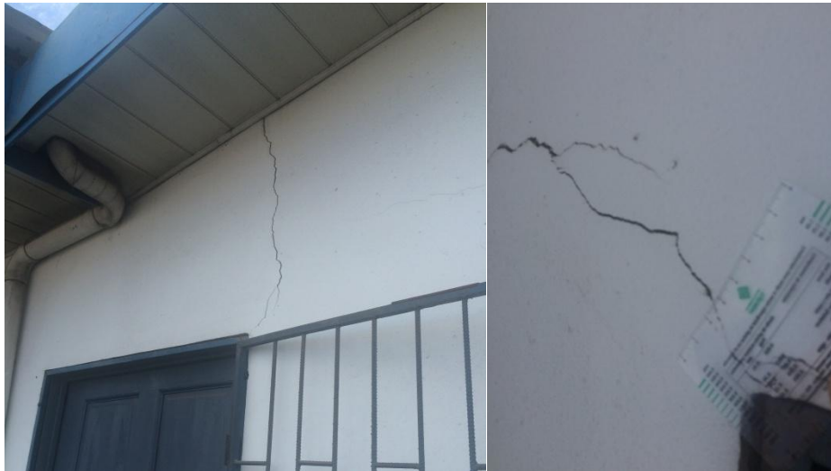
Figura 3. Fisura en pared de mampostería
