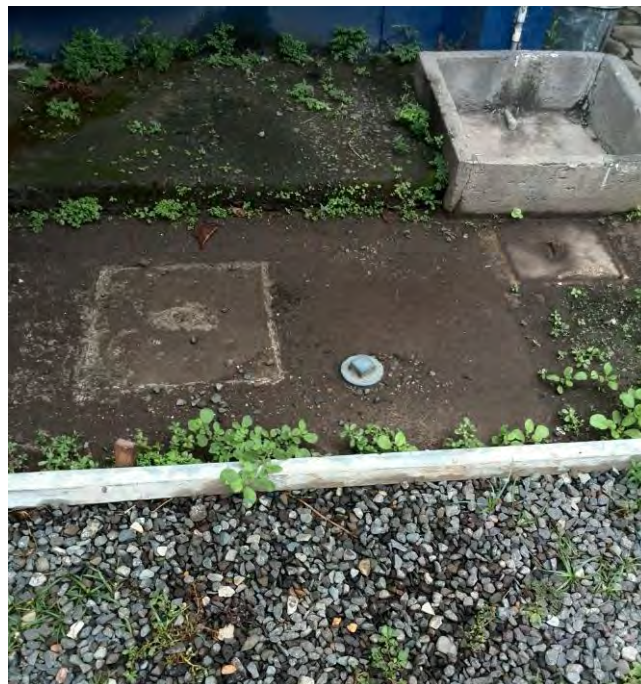
Figura 2.6 Tanque séptico para las aguas del edificio R.
