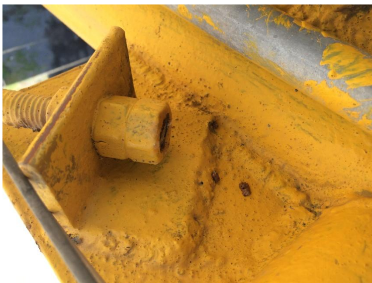
Figura 7. Soldaduras mal confeccionadas y con porosidad
