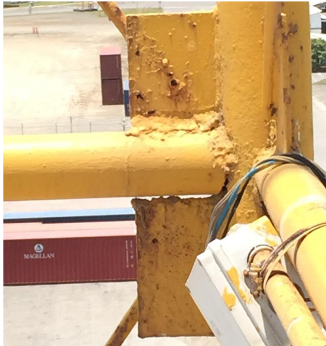
Figura 6. Corrosión en placas de arriostres.
