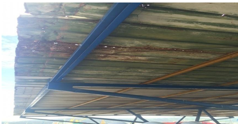
Figura 11. Cubierta de techo corroída y en mal estado
