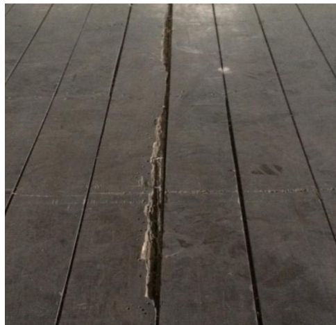
Figura 13. Tablones en mal estado
