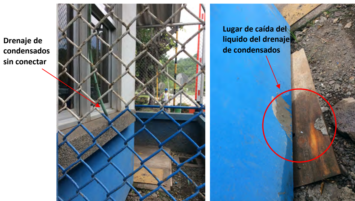
Figura 2.1. Drenaje de condensados de aire acondicionado de oficina interna.
