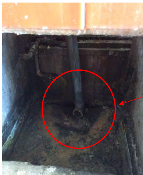
Figura 2.14. Descarga de pila en patio.
