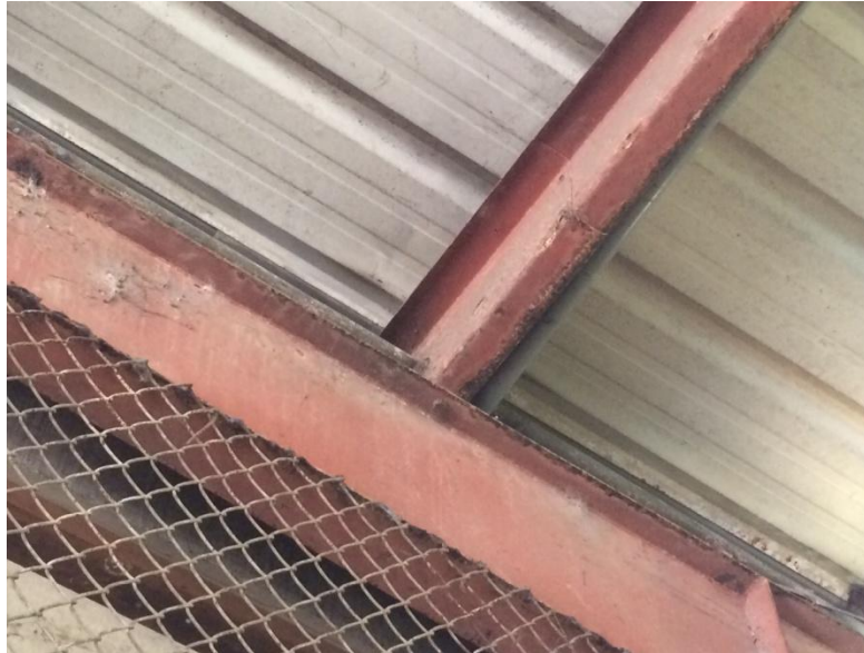
Figura 6. Vigas con corrosión
