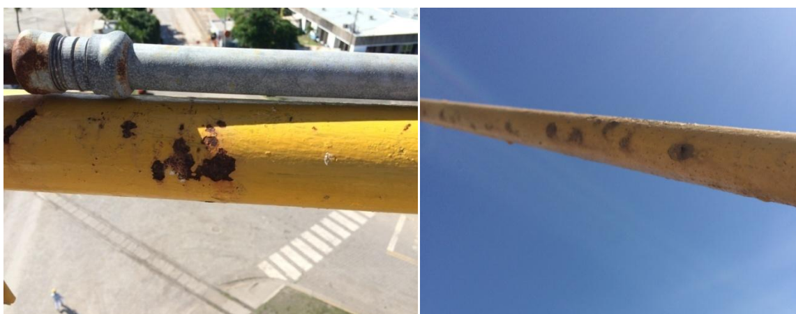
Figura 5. Corrosión presente en elementos de estructura
