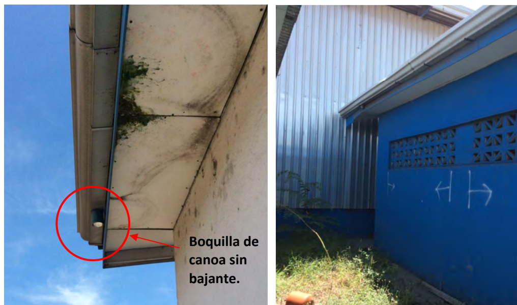
Figura 2.3. Canoas sin bajantes del edificio L.
