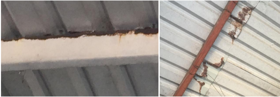
Figura 5. Corrosión en largueros y cubierta de techo
