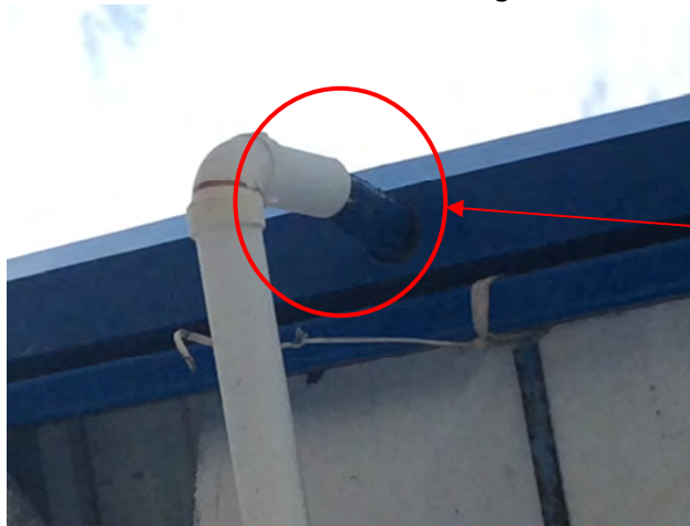
Figura 2.1. Bajante desacomodado de la boquilla.
