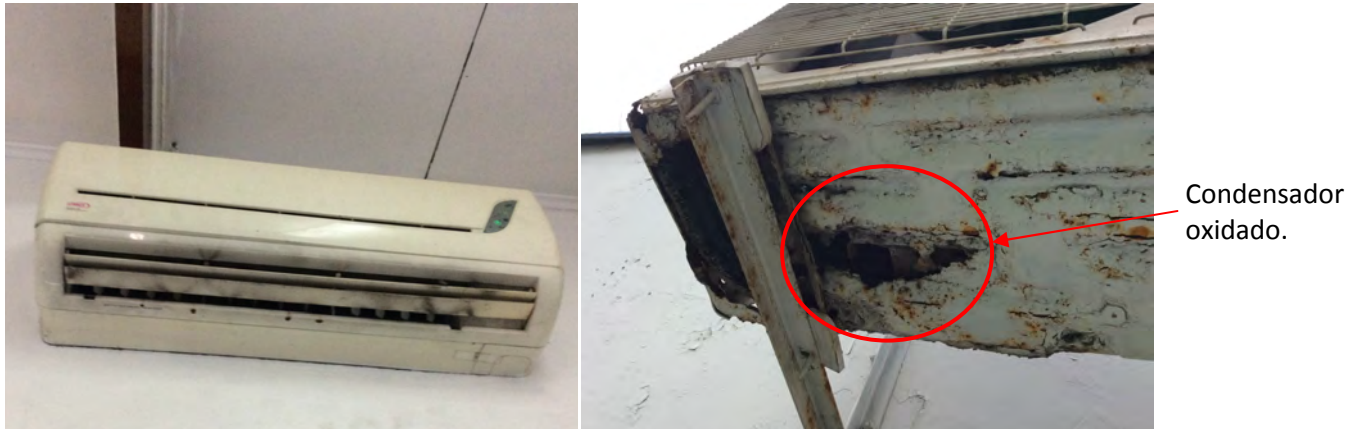
Figura 2.3. Condensador y evaporadora de aire acondicionado de consultorio médico.
