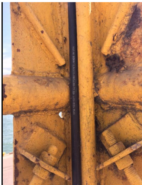
Figura 4. Unión de marco con arriostres con corrosión excesiva.
