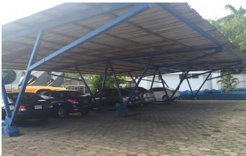
Figura 1. Estructura de techo de parqueo
