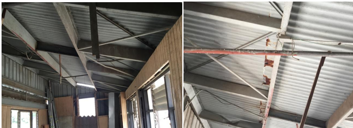
Figura 4. Estructura de techo y cubierta en mal estado
