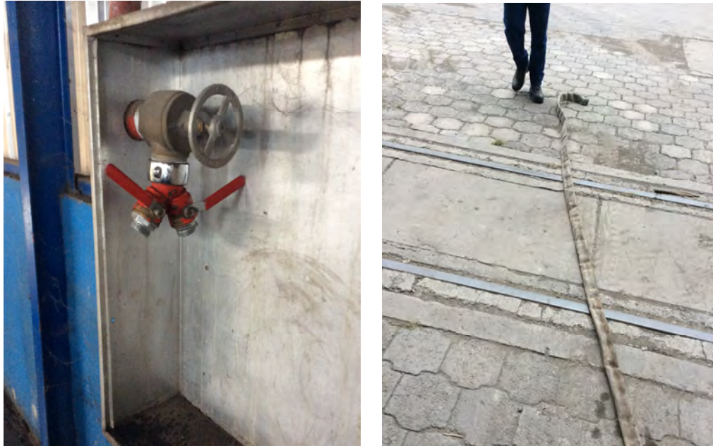
Figura 2.4. Gabinete y manguera usados en prueba de sistema de supresión contra incendios.
