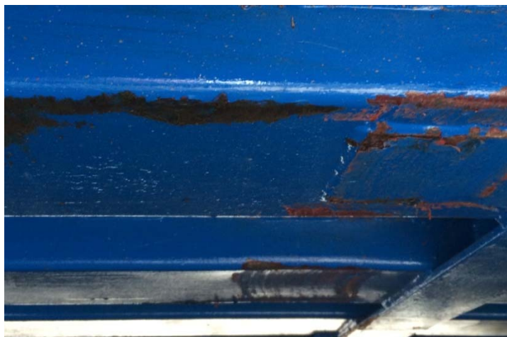
Figura 7. Corrosión en elementos estructurales de las básculas
