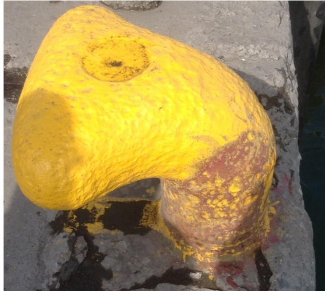
Figura 3. Bitas presentan corrosión
