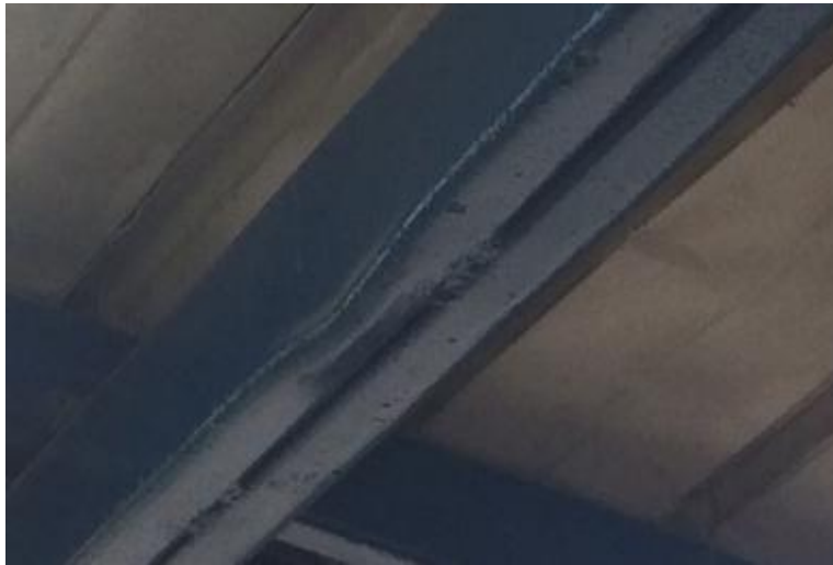
Figura 4. Elementos estructurales con deformaciones
