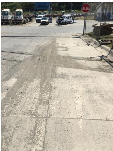
Figura 31. Deterioro de señal horizontal en calle 3.
