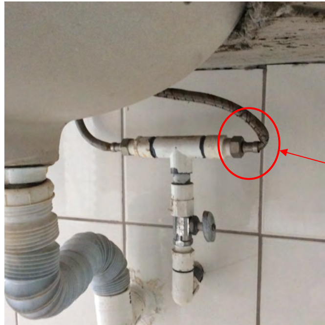
Figura 2.43. Tubo de abasto de lavatorio doblado.
