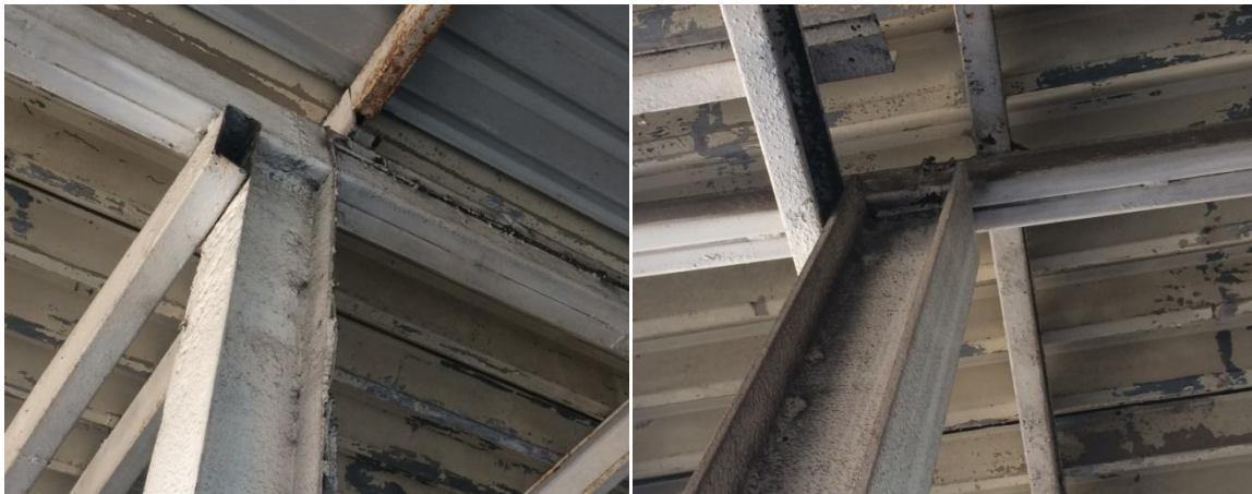
Figura 6. Conexiones entre elementos en mal estado
