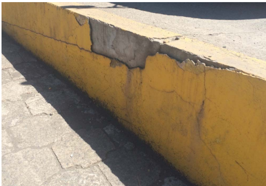
Figura 4. Pérdida de recubrimiento de pintura al concreto
