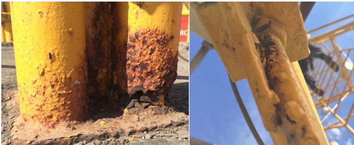
Figura 7. Corrosión presente en toda la estructura
