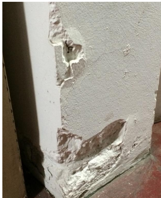
Figura 4. Fisura en columna
