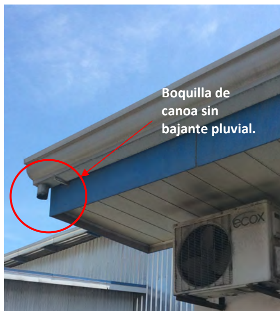
Figura 2.3. Canoas y bajante de edificio M.
