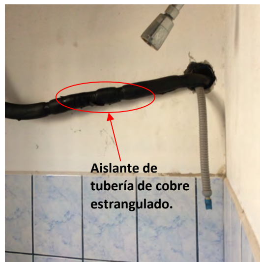
Figura 2.1 Desagüe del aire acondicionado de esta zona.
