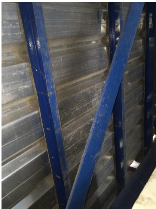
Figura 2. Arriostramiento lateral de marcos de nave industrial
