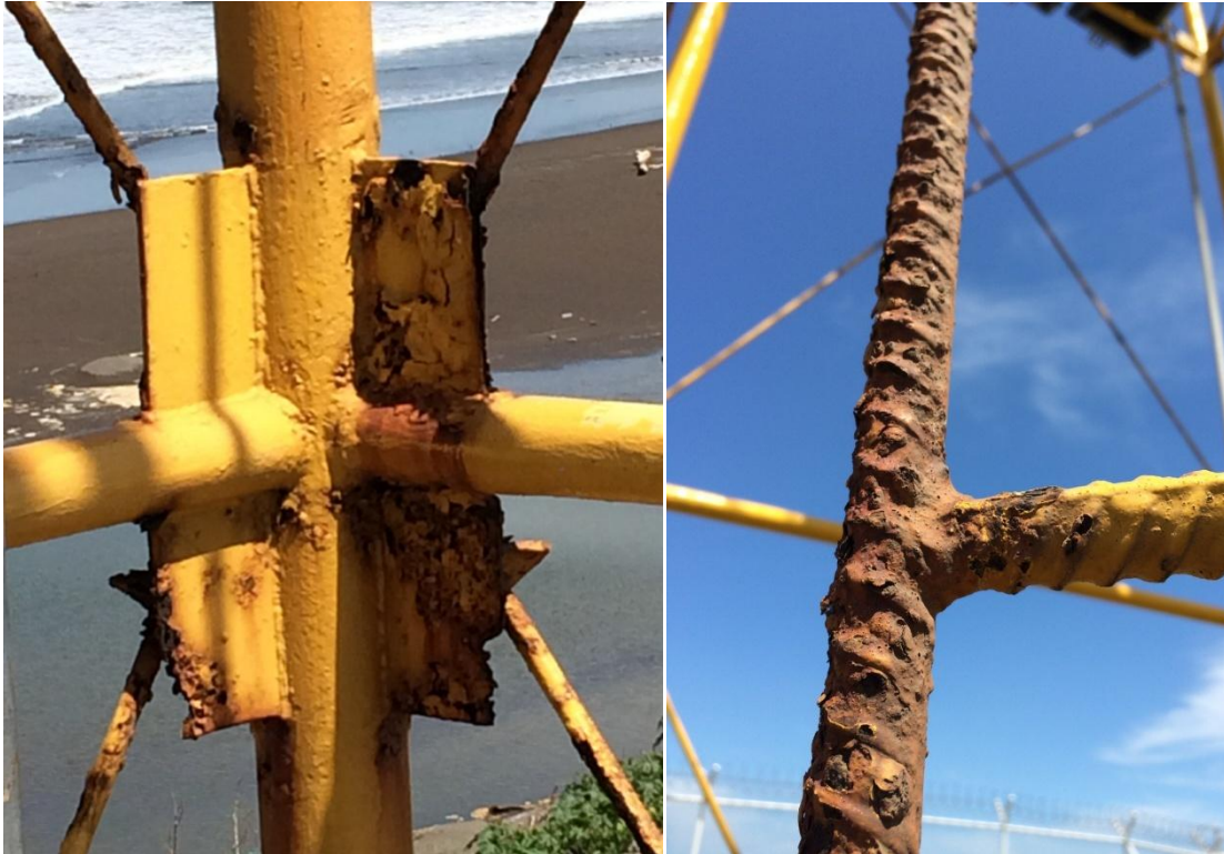
Figura 4. Corrosión presente en toda la estructura
