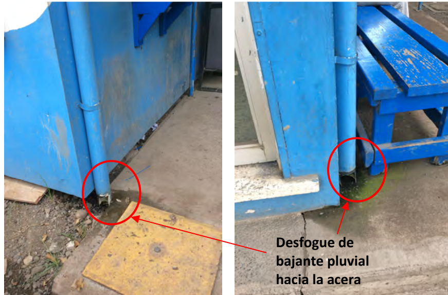
Figura 2.2. Bajantes del sistema de aguas pluviales del edificio V.
