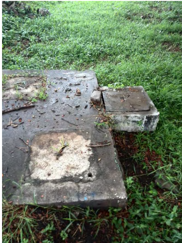
Figura 2.1 Tanque séptico detrás de los talleres, edificio J (fuera de uso).
