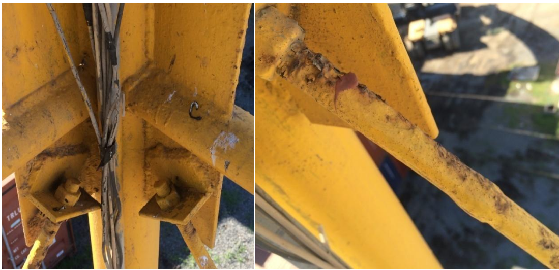
Figura 6. Corrosión en la estructura
