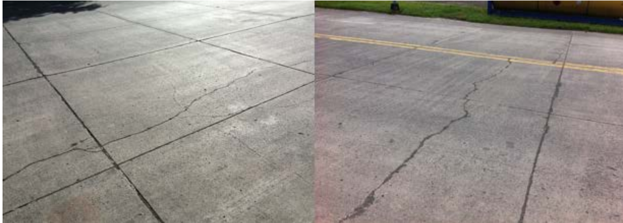
Figura 16. Agrietamiento Longitudinal con severidades Media y Alta
