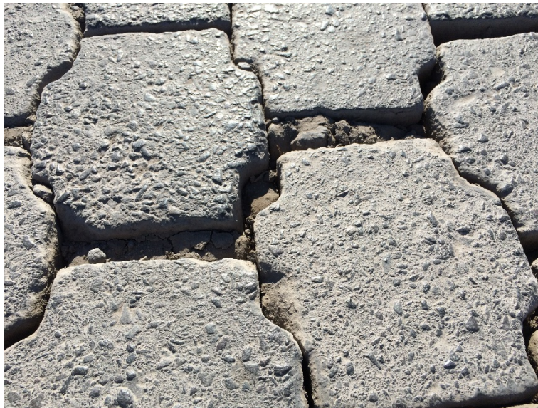
Figura 14. Hundimiento con Severidad Alta en AV3-8
