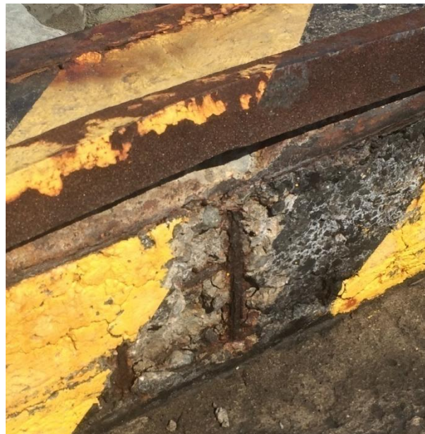
Figura 2. Corrosión en acero de refuerzo
