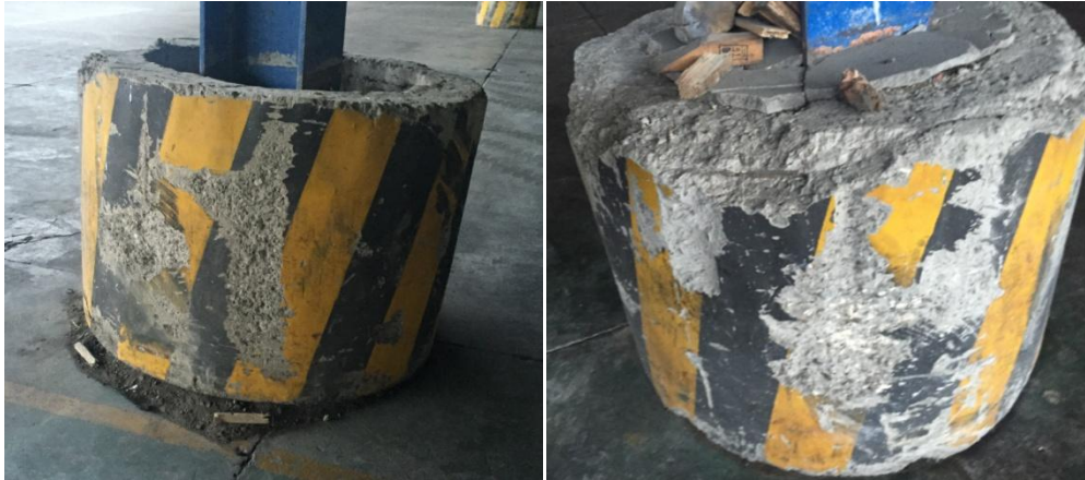
Figura 3. Protectores en bases de columnas con pérdida de recubrimiento y repello
