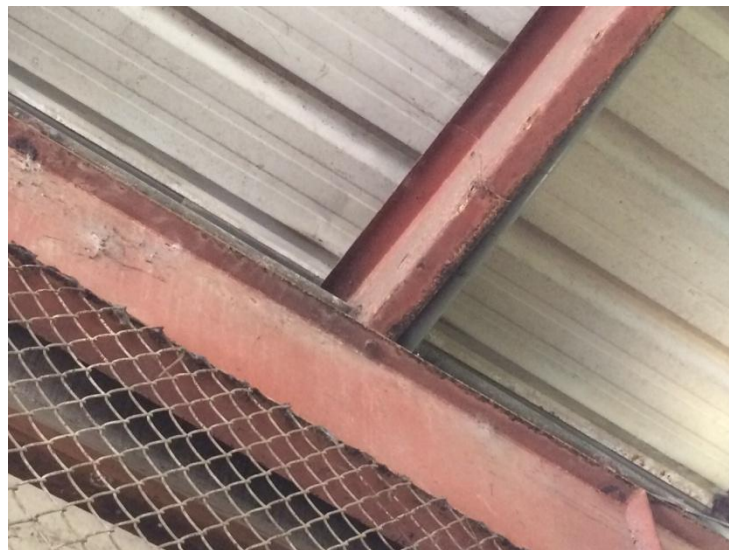
Figura 9. Corrosión en estructura de techo
