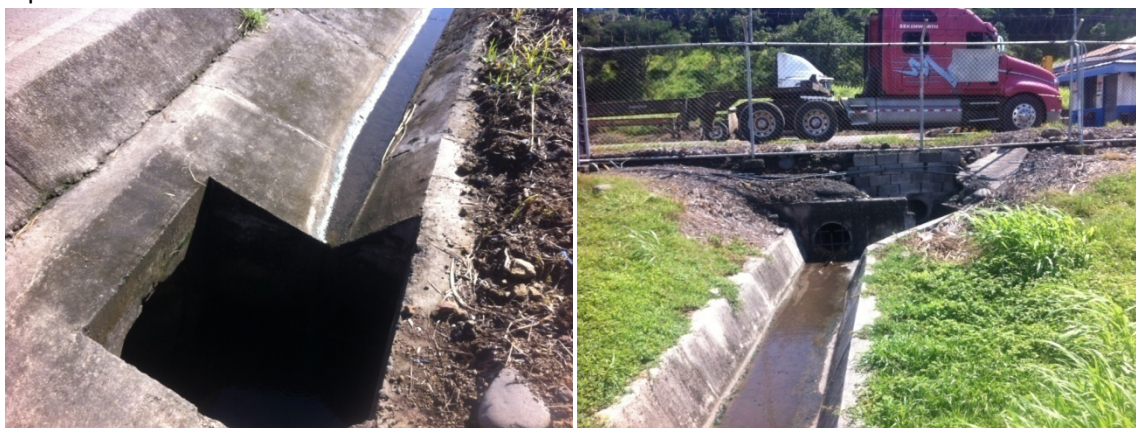
Figura 56. Alcantarilla 4, cuenta con una tubería de concreto de 650mm de diámetro.
