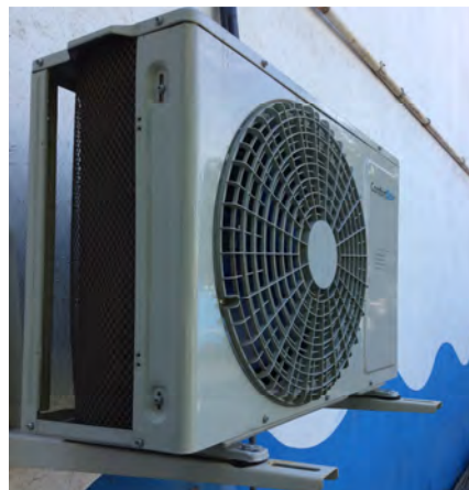
Figura 2.5. Condensador del aire acondicionado nuevo instalado en el laboratorio.
