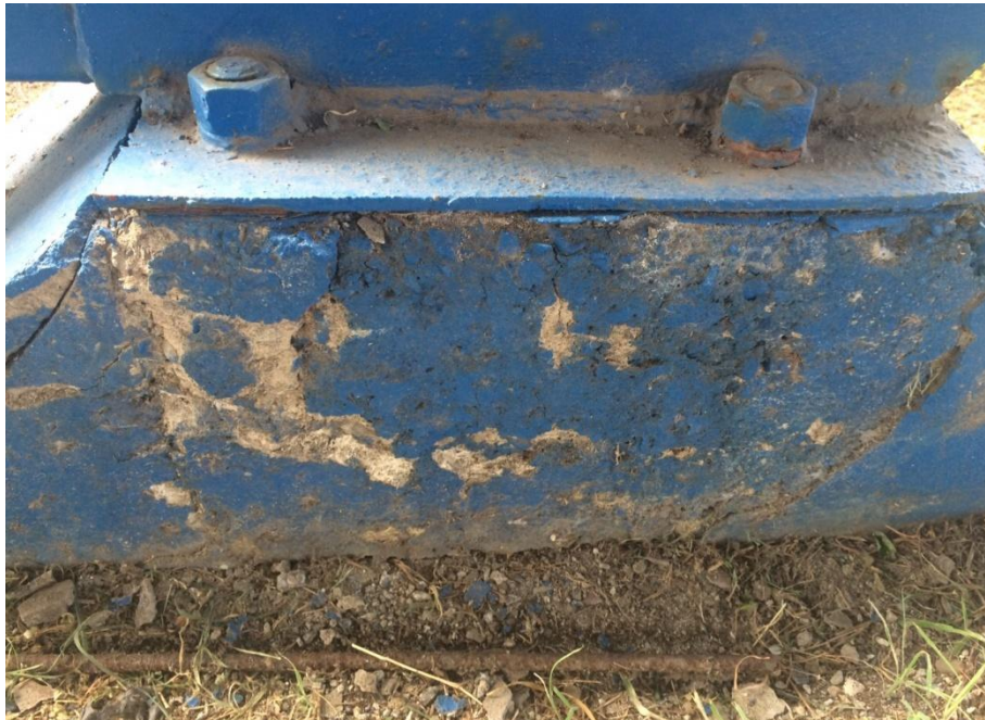
Figura 6. Concreto de pedestales deteriorado
