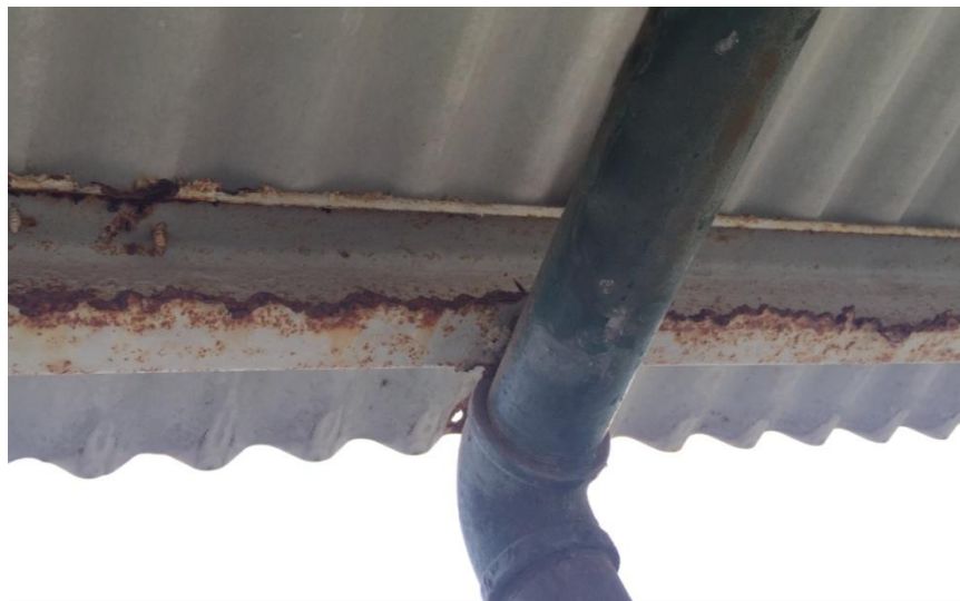
Figura 2. Soldaduras entre largueros y el marco en mal estado
