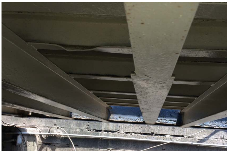
Figura 2. Deformaciones en vigas de básculas de pesaje
