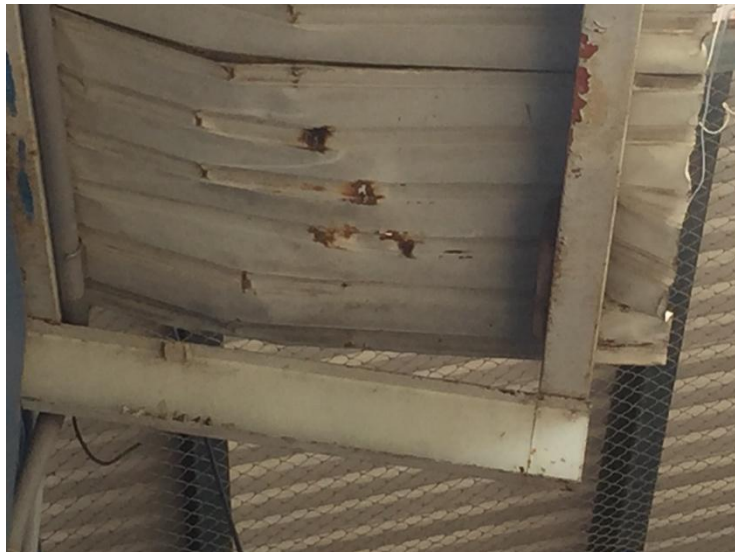
Figura 8. Cubierta de techo en mal estado
