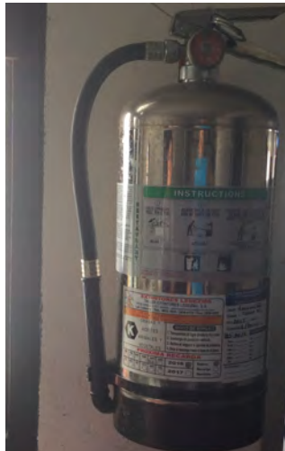
Figura 2.17. Extintor en cocina de comedor general, clase K.
