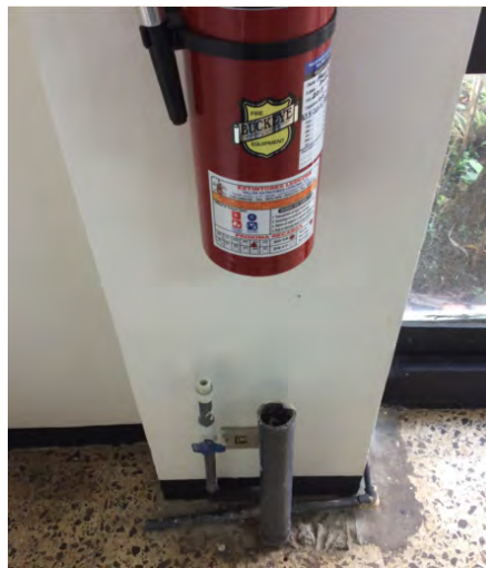
Figura 2.16. Extintor en comedor general, clase BC.
