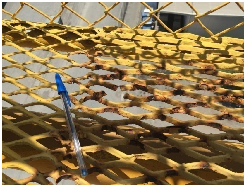
Figura 9. Plataforma de Jordomex deteriorada por corrosión.
