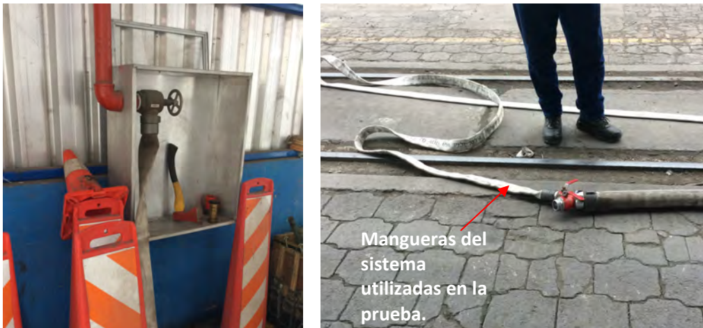
Figura 2.5. Gabinete y manguera usados en prueba de sistema de supresión contra incendios.
