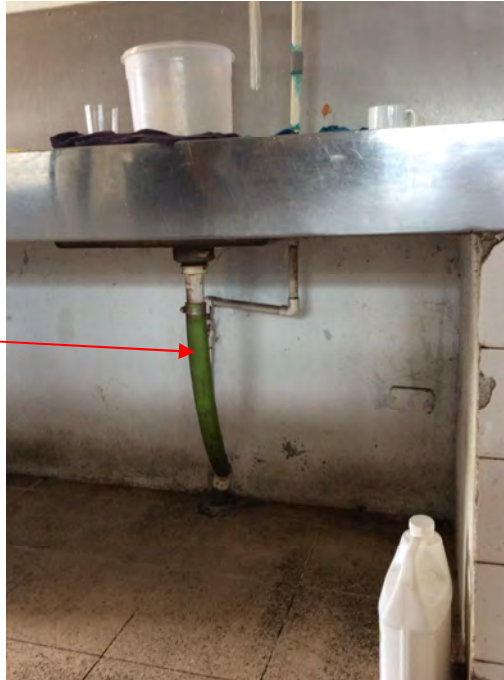
Figura 2.3. Fregadero sin sifón ubicado en la cocina.
