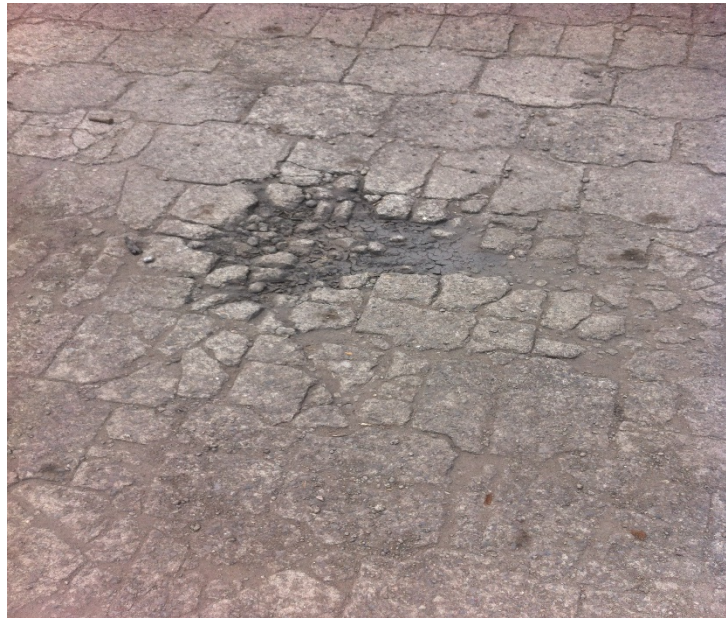
Figura 15. Piezas dañadas con Severidad Alta en P1-D7
