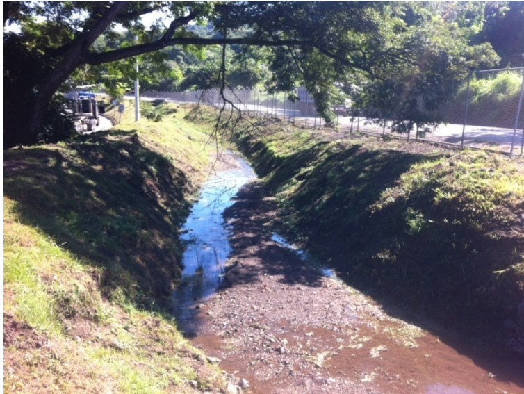
Figura 57. Sedimento acumulado en canal al que desaguan las alcantarillas 1, 2 y 3.
