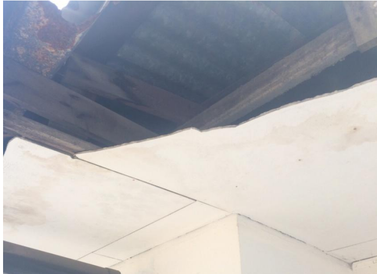
Figura 7. Cielos en mal estado
