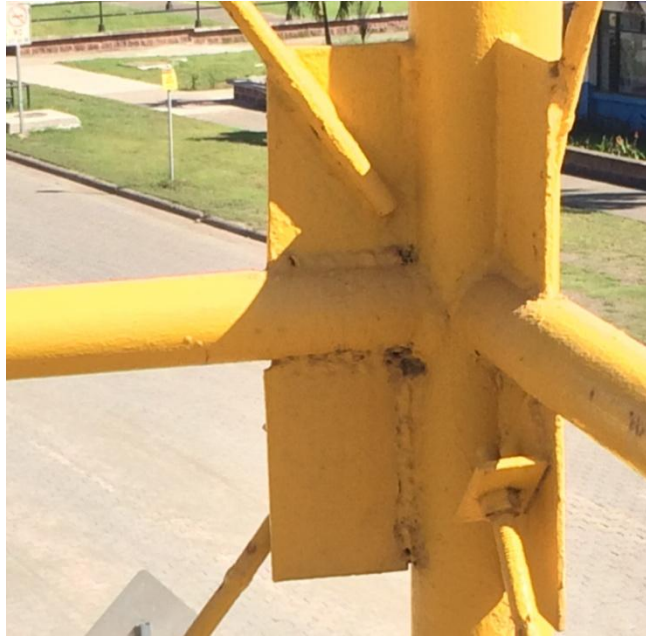
Figura 3. Conexión de arriostres inadecuado
