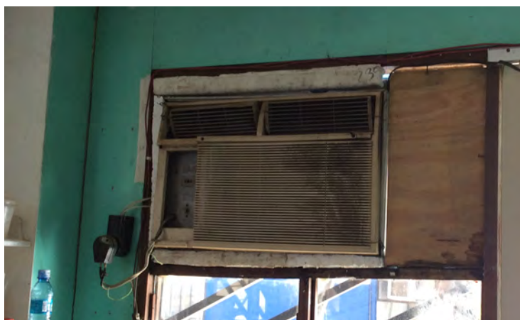
Figura 2.1. Aire acondicionado de ventana.
