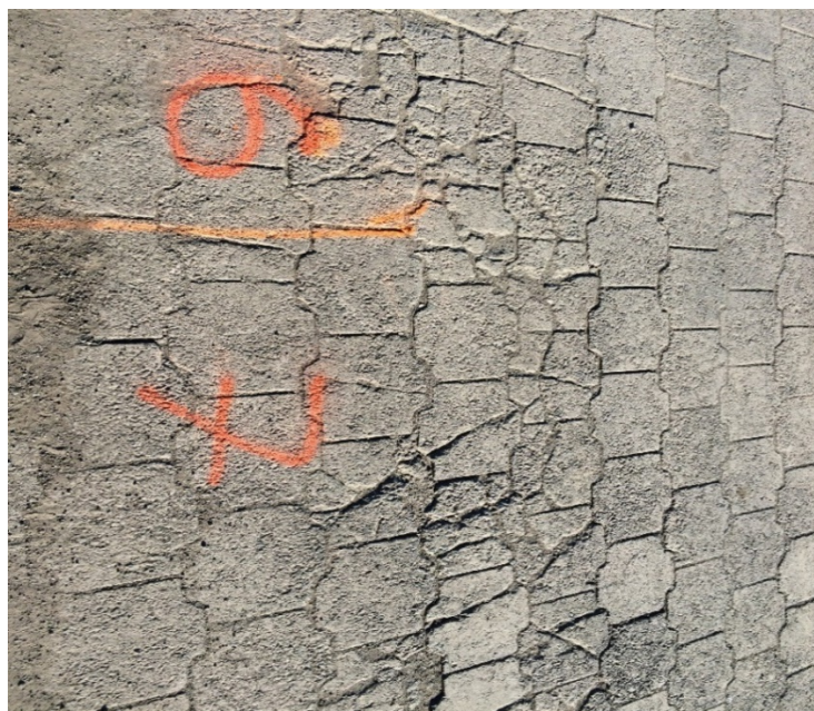
Figura 11. Piezas de Adoquín Dañadas, Avenida 3
