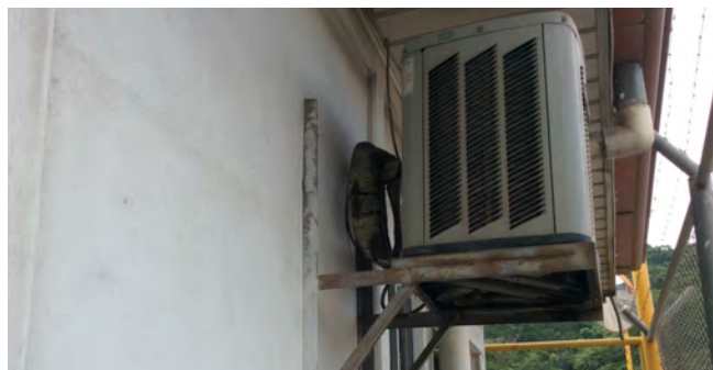
Figura 2.6. Condensador de aire acondicionado de cajeta de vigilancia.
