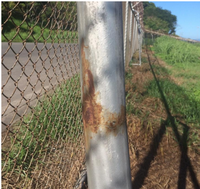
Figura 5. Corrosión en tubos de acero de la malla perimetral
