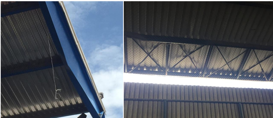
Figura 6. Deformación en elementos metálicos
