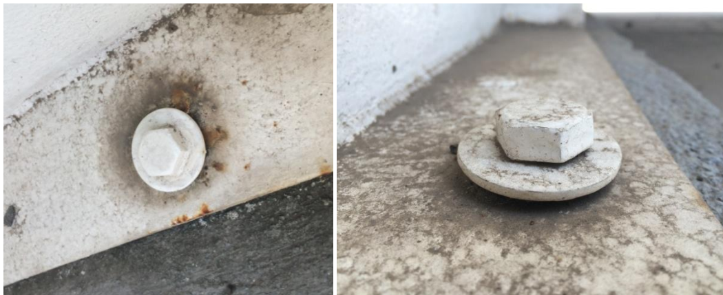
Figura 8. Pernos en la base del tanque de combustible con corrosión
