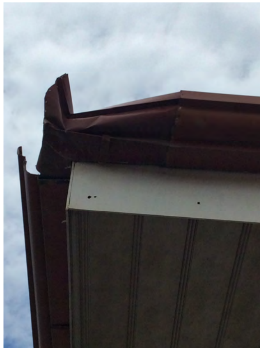
Figura 2.7. Tramo de canoa dañada, caseta de vigilancia almacén fiscal.
