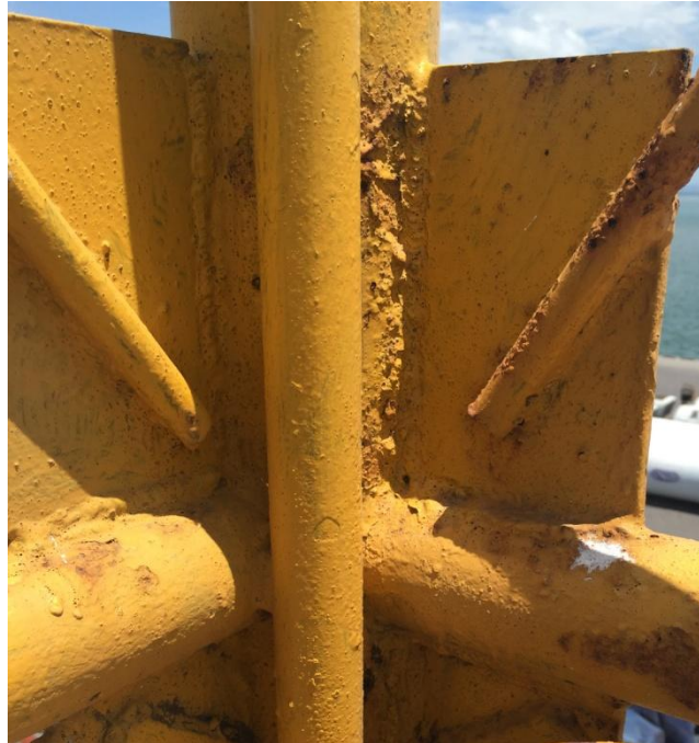
Figura 3. Conexión de arriostres inadecuado
