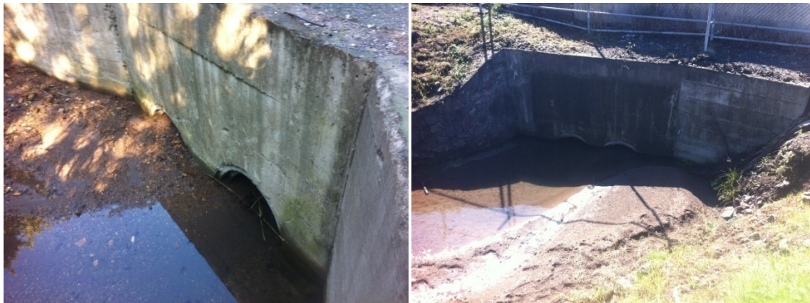
Figura 55. Alcantarilla 3, cuenta con dos tuberías de concreto de 1.0m de diámetro. Como se puede ver en las imágenes, la alcantarilla se encuentra aterrada, por lo que esta aproximadamente a un 20% de capacidad.
