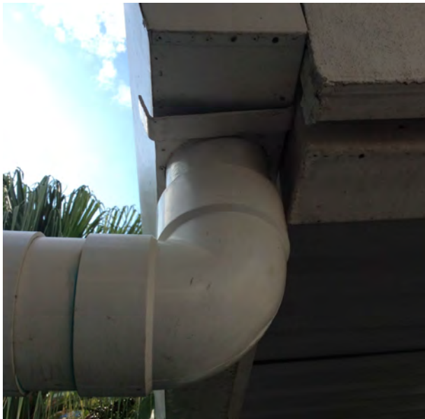
Figura 2.1 Canoa del parqueo #2 y conexión de bajante a boquilla de la canoa.
