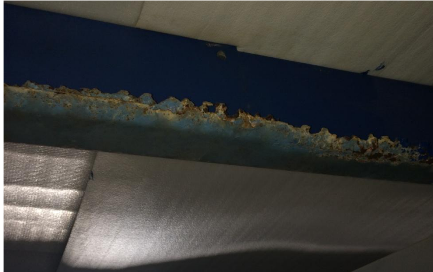
Figura 10. Pérdida de volumen de elementos estructurales por corrosión
