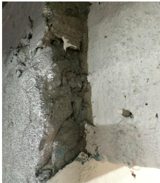
Figura 7. “Hormiguero” en concreto
