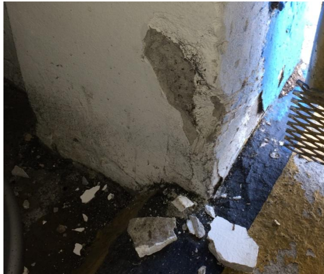
Figura 5. Pérdida del recubrimiento en una columna
