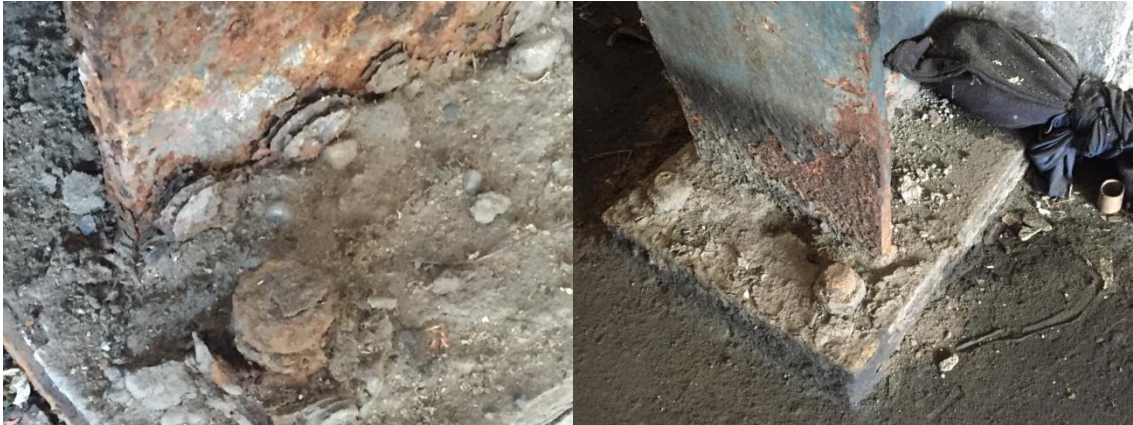
Figura 11. Corrosión en placas y pernos en la base de las columnas
