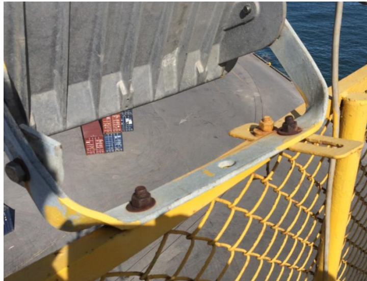
Figura 5. Anclaje indebido de luminaria
