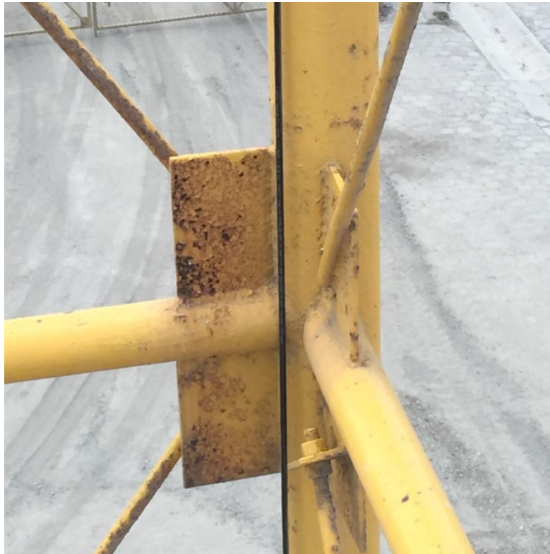
Figura 3. Conexión de arriostres inadecuado
