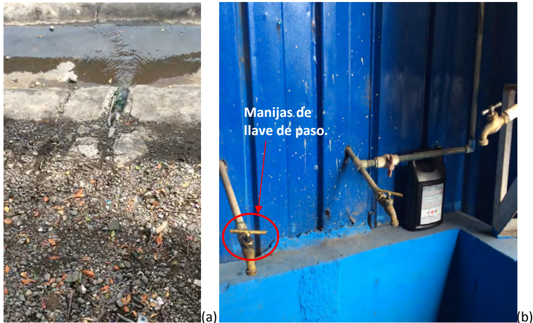
Figura 2.2. Tubería de desagüe de la pileta de taller de soldadura (a), llaves inadecuadas de los grifos (b).
