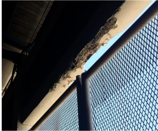
Figura 3. Dintel con golpes y acero de refuerzo expuesto
