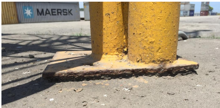
Figura 4. Placa de asiento separada de concreto
