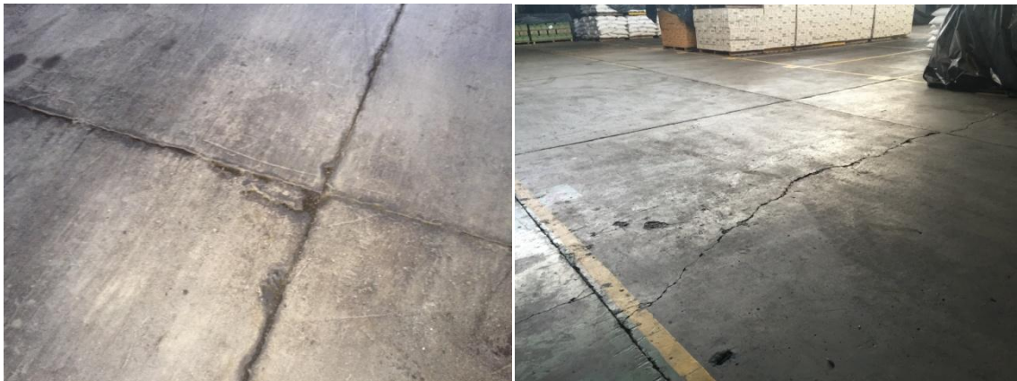
Figura 4. Juntas de losas en mal estado y fisuramiento.
