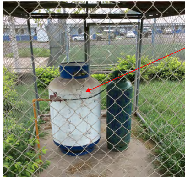
Figura 2.6. Tanques de gas de la cocina de la soda.
