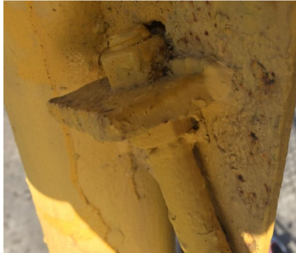
Figura 3. Conexión de arriostres inadecuado
