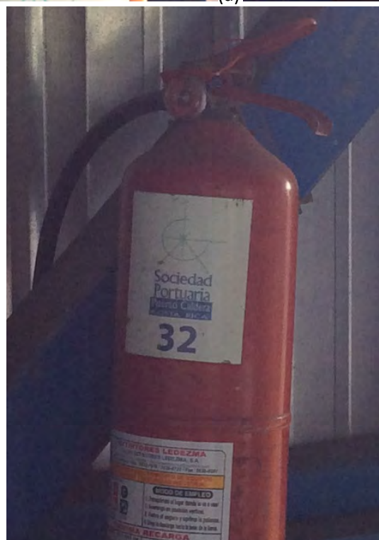
Figura 2.3. Extintor en parte norte del edificio P, manómetro indica sobrecarga (a), rotulación del extintor (b), cordón de soldadura en el cilindro del extintor (c).
