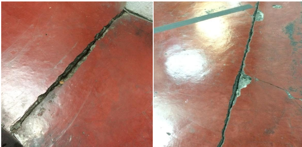
Figura 9. Juntas en losa de piso en mal estado
