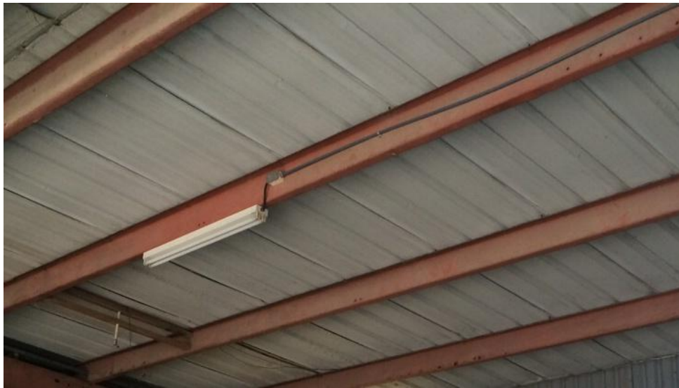
Figura 2. Largueros en posición inercial desfavorable y sin arriostramiento medio
