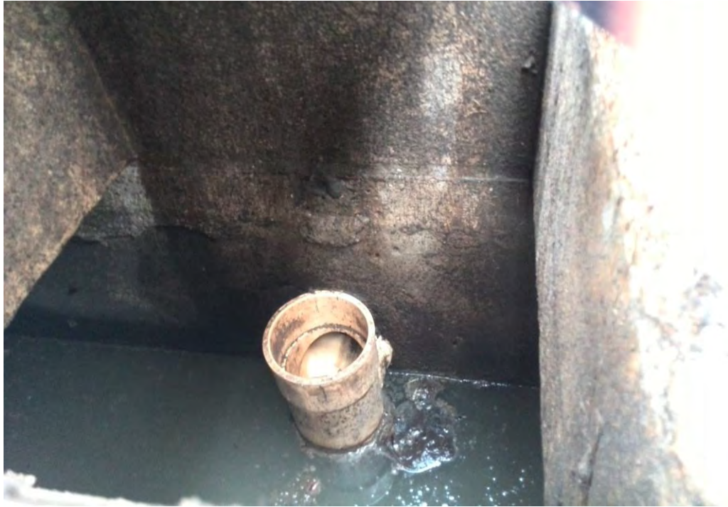
Figura 2.5 (c) Tanque séptico para las aguas de los edificios P y Q.
