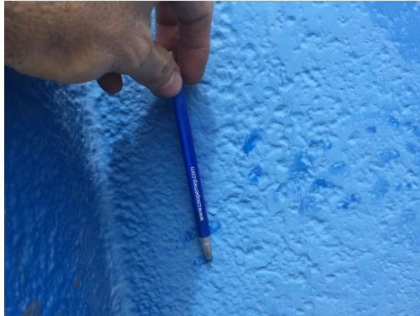
Figura 13. Porosidad en columnas debida a la corrosión
