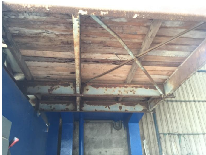
Figura 3. Estructura de soporte de baño del segundo nivel
