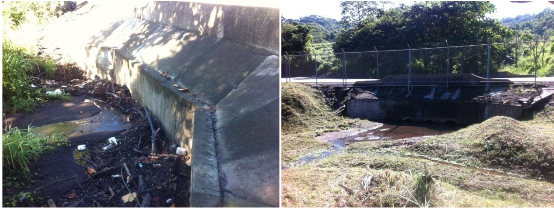
Figura 70. Alcantarilla 2, cuenta con tres tuberías de concreto de 1.0m de diámetro. Como se puede ver en las imágenes, la alcantarilla se encuentra aterrada, por lo que esta aproximadamente a un 30% de capacidad.
