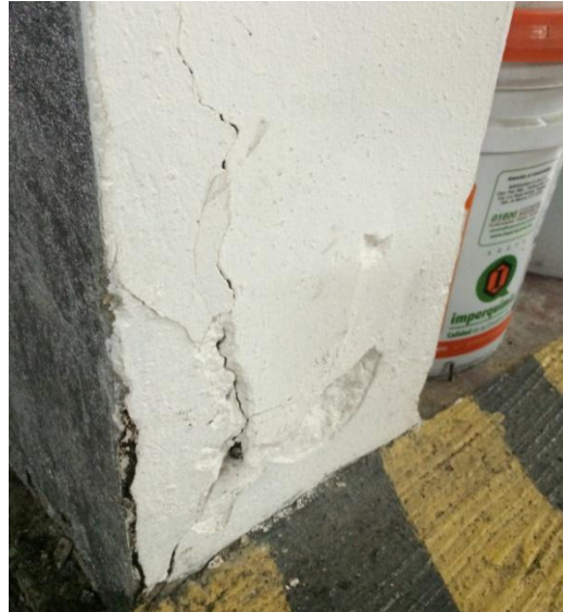
Figura 3. Fisura en columna
