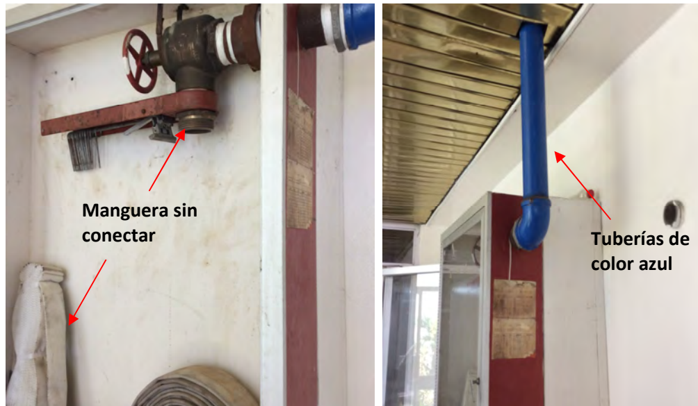
Figura 2.25. Gabinete clase II del sistema de supresión contra incendios.
