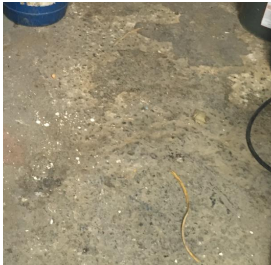
Figura 5. Losa de piso con abrasión
