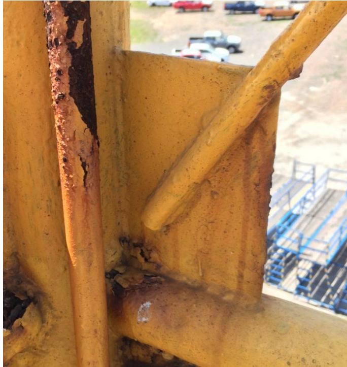
Figura 3. Conexión de arriostres inadecuado
