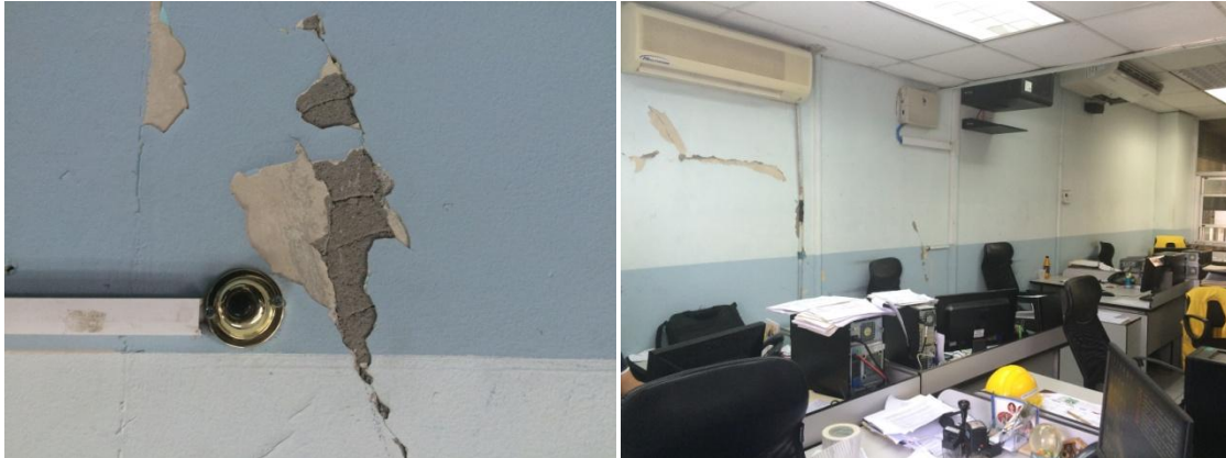
Figura 4. Fisuras por cortante en muro estructural
