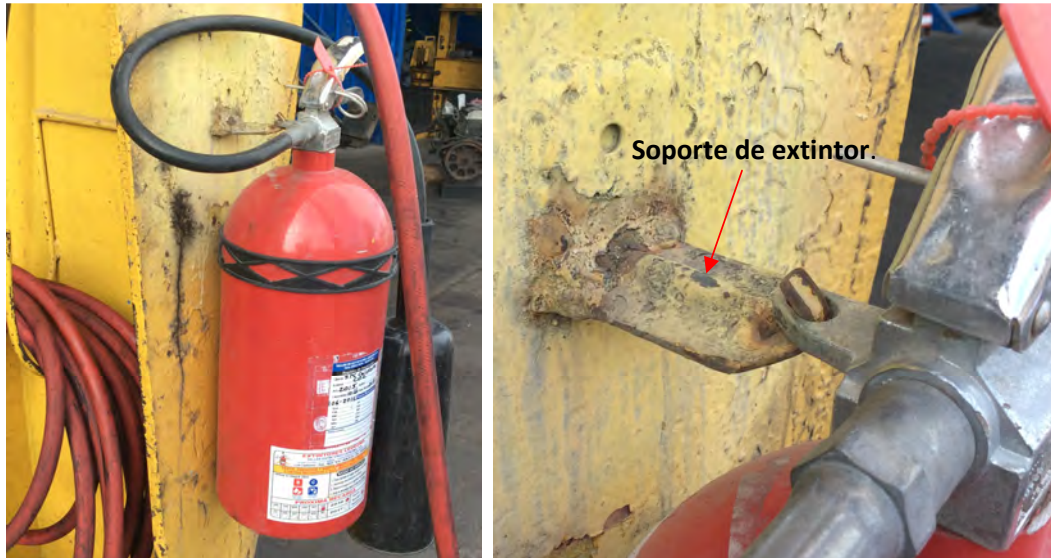
Figura 2.3. Extintor colocado en viga, soporte de extintor.
