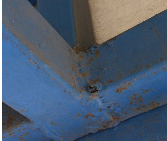
Figura 3. Soldaduras en mal estado
