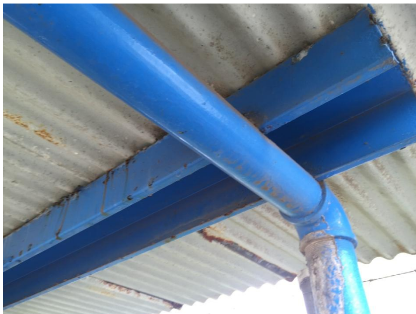
Figura 5. Corrosión superficial en marcos de tuberías
