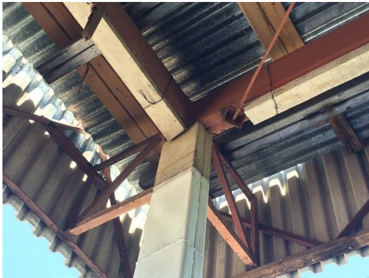
Figura 2. Conexión viga-columna inadecuada (columna por debajo de las vigas)
