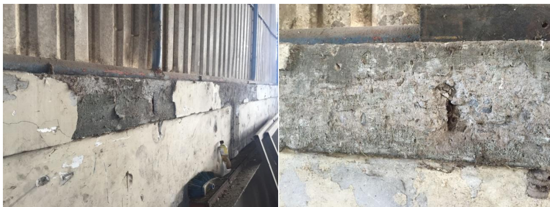
Figura 10. Zócalo de mampostería con deterioro
