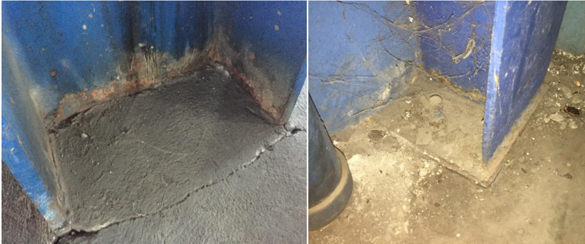
Figura5. Óxido en columnas de acero
