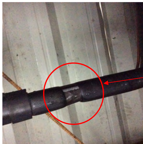
Figura 2.47. Tubería de cobre con aislamiento, con cinta muy ajustada y presenta condensación.
