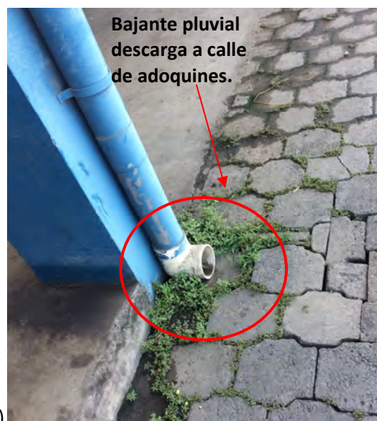
Figura 2.2. Canoas del edificio N (a), bajantes desconectados y descarga del mismo (b) y (c) respectivamente.
