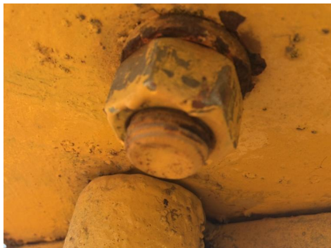
Figura 8. Pernos en mal estado
