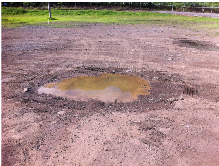
Figura 18. Muestra con Hundimiento Severo (patio 7)
