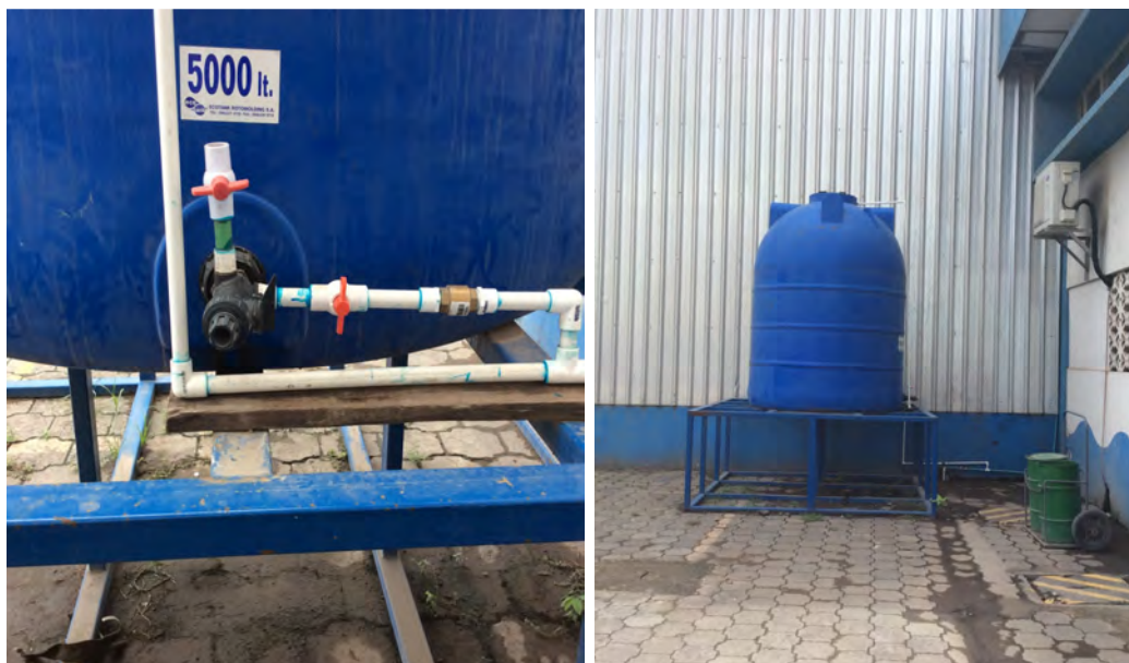
Figura 2.3. Tanque de agua potable ubicado en el exterior del edificio Q.
