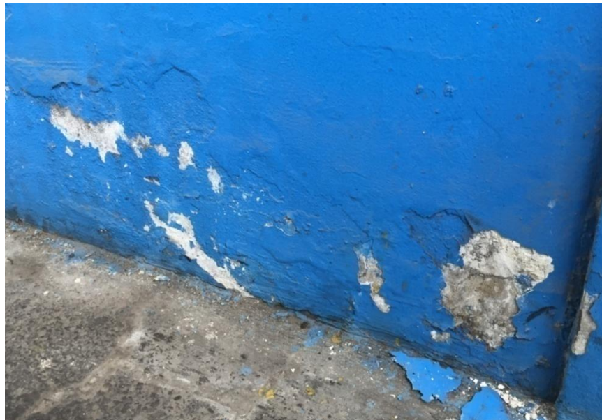
Figura 7. Pintura en mal estado
