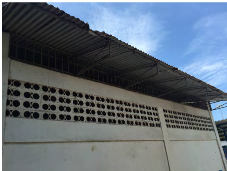
Figura 2.3. Techo sin canoas del edificio F.
