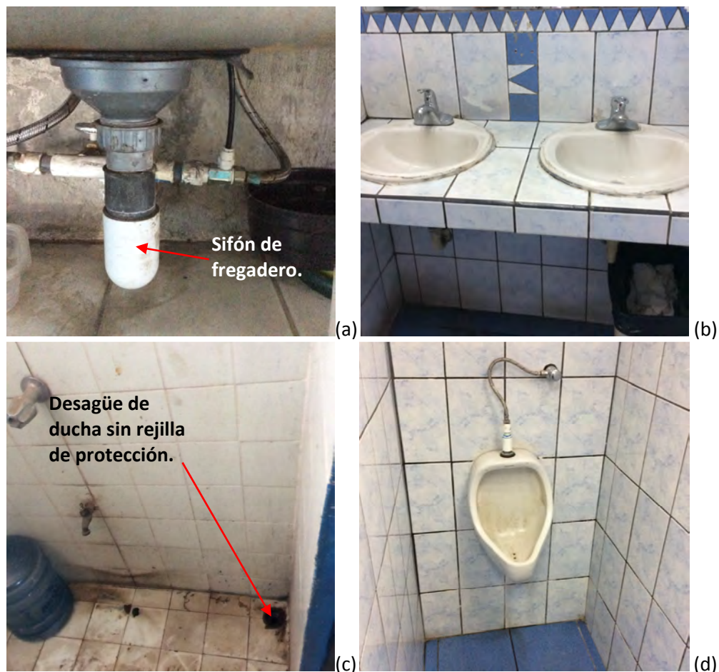
Figura 2.2. Tubería de descarga de fregadero (a), lavatorios (b), desagüe de ducha sin rejilla (c), mingitorios del baño en buenas condiciones (d).
