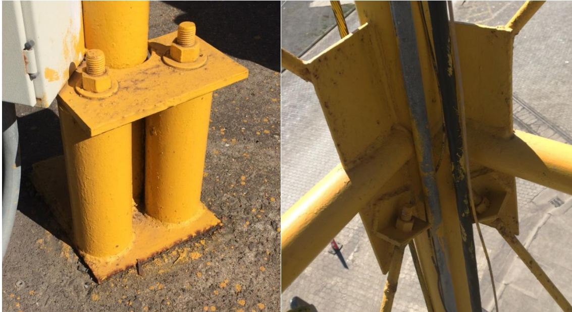
Figura 7. Placas de la base y uniones entre marcos y arriostres en mal estado
