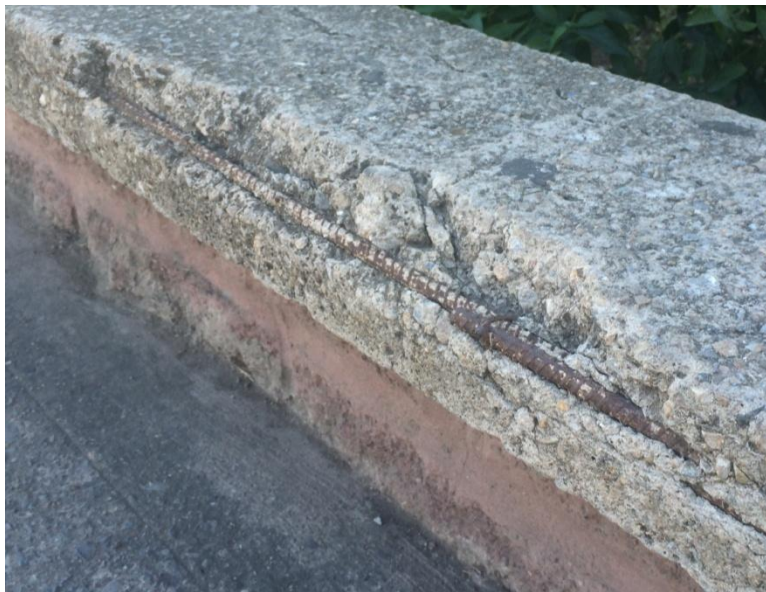
Figura 2. Zócalo exterior con acero de refuerzo expuesto
