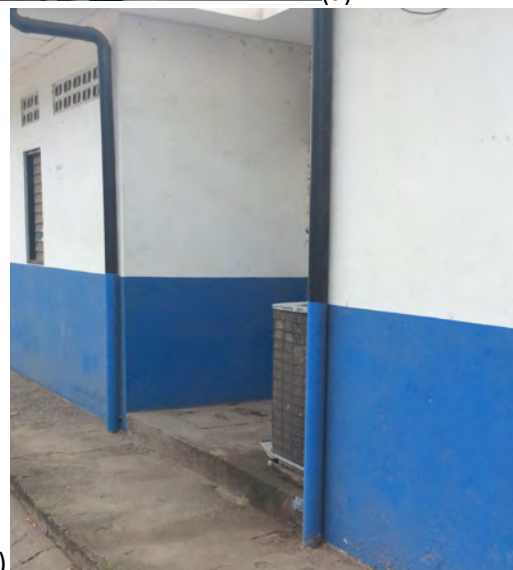
Figura 2.3. Canoas en mal estado (a), caja de registro obstruida (b), sistema de bajantes del edificio E (c).
