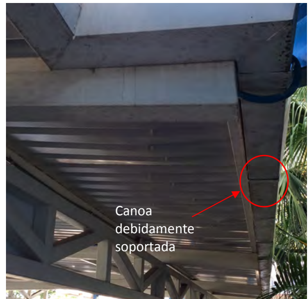
Figura 2.1 Canoa del parqueo #2 y conexión de bajante a boquilla de la canoa.
