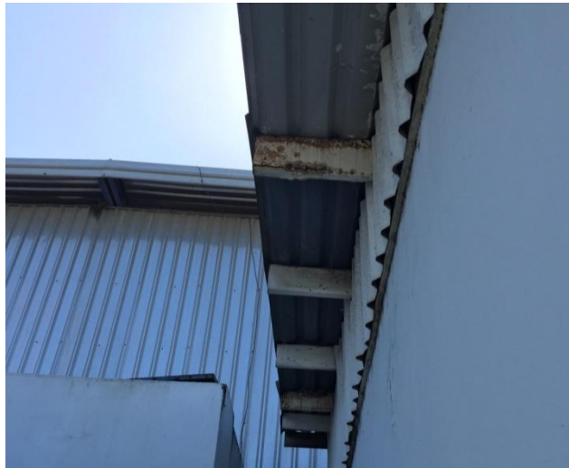
Figura 5. Vigas de techo con corrosión
