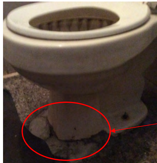
Figura 2.3. Servicio sanitario dañado, baño con ventilación natural.
