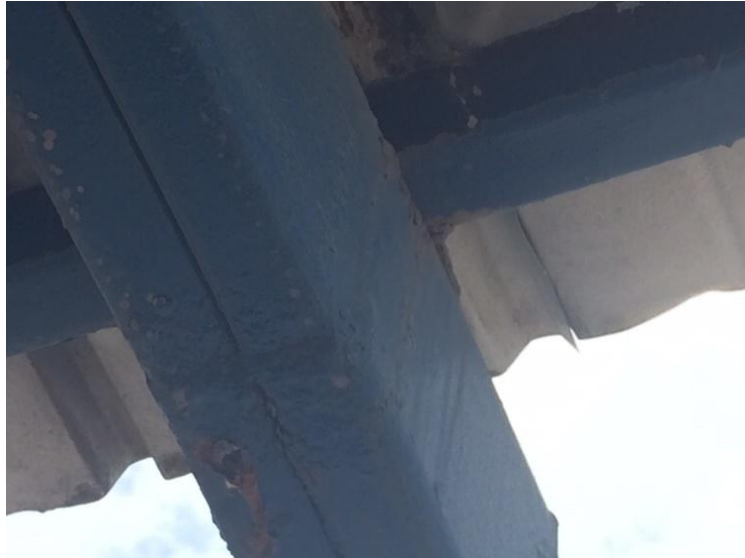
Figura 5. Elementos estructurales corroídos y pintura inadecuada
