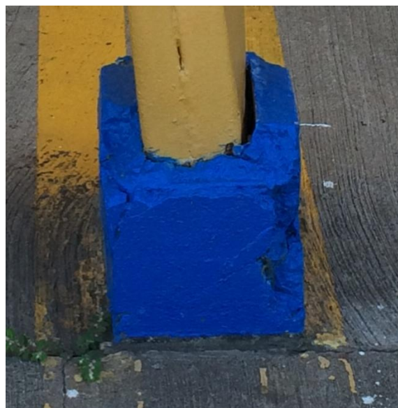
Figura 4. Pérdida de recubrimiento en pedestal de concreto
