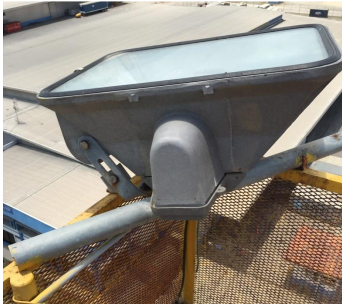
Figura 5. Anclaje indebido de luminaria
