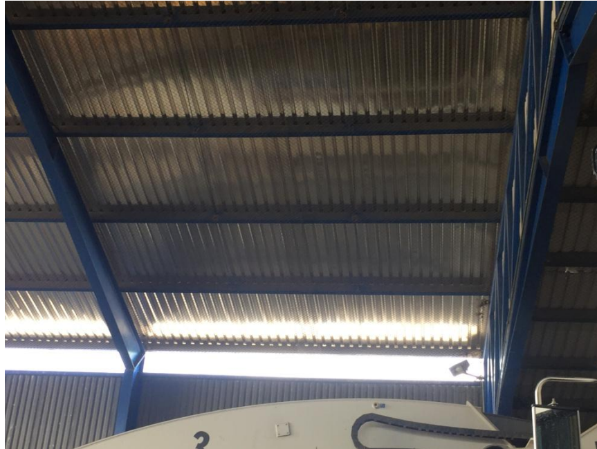
Figura 3. Largueros de techo sin arriostramiento medio.
