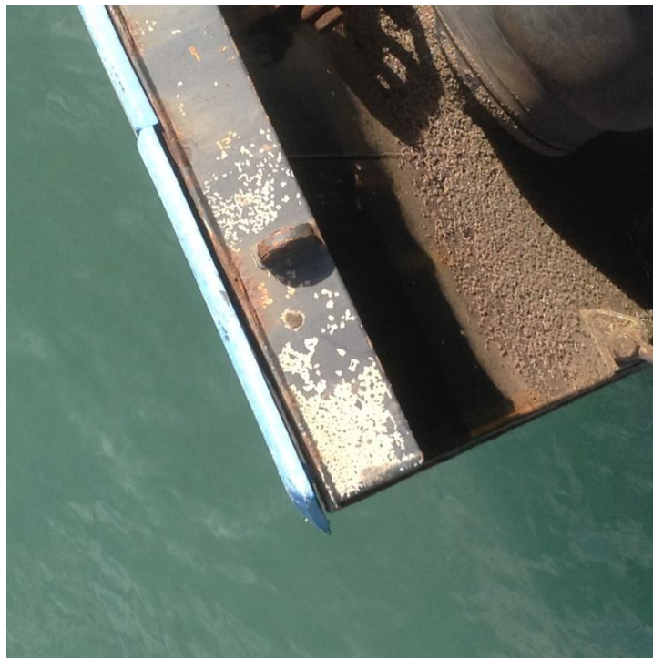
Figura 2. Defensas con baquelitas desgastadas o desmontadas
