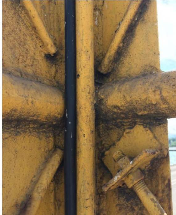
Figura 3. Conexión de arriostres inadecuada
