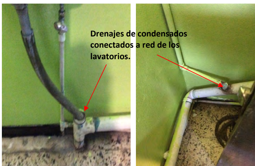
Figura 2.4. Drenajes de condensados hacia tuberías de lavatorio.
