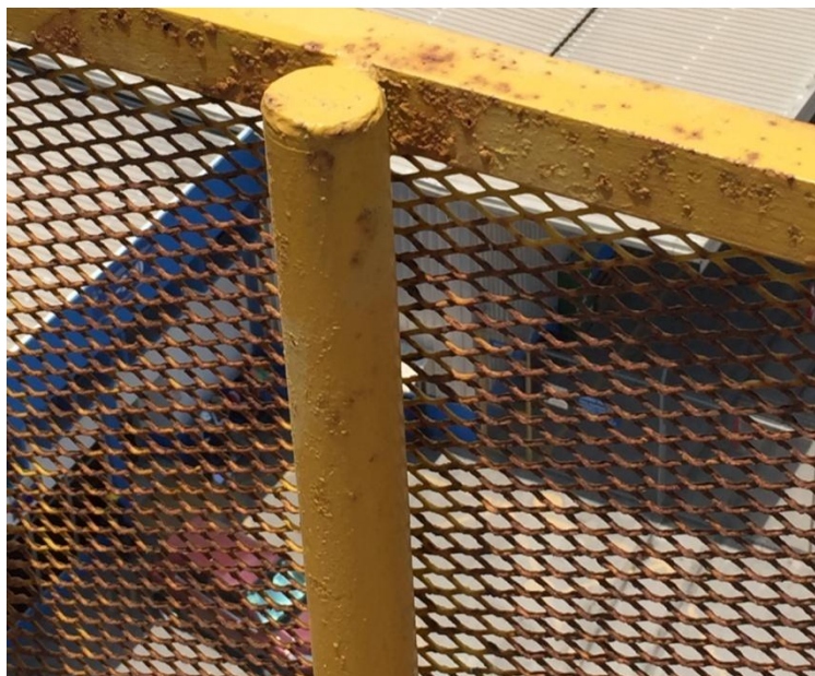
Figura 7. Baranda de seguridad con corrosión.
