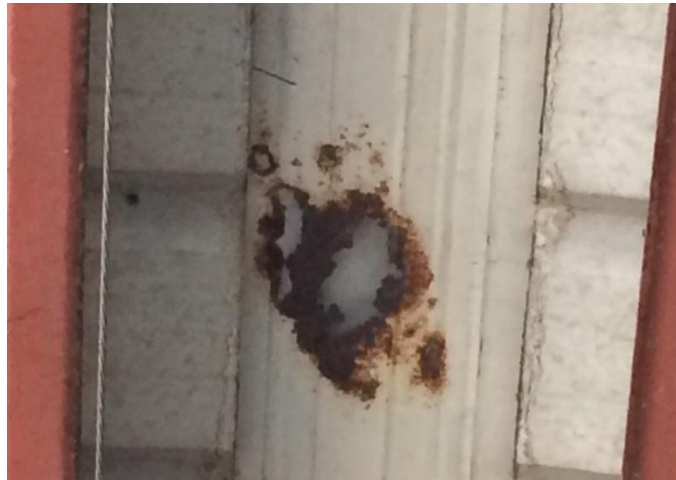
Figura 8. Cubierta de techo en mal estado
