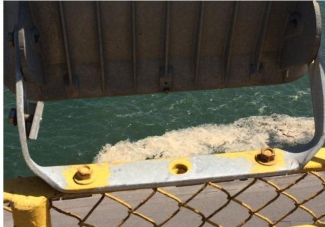
Figura 5. Anclaje indebido de luminaria
