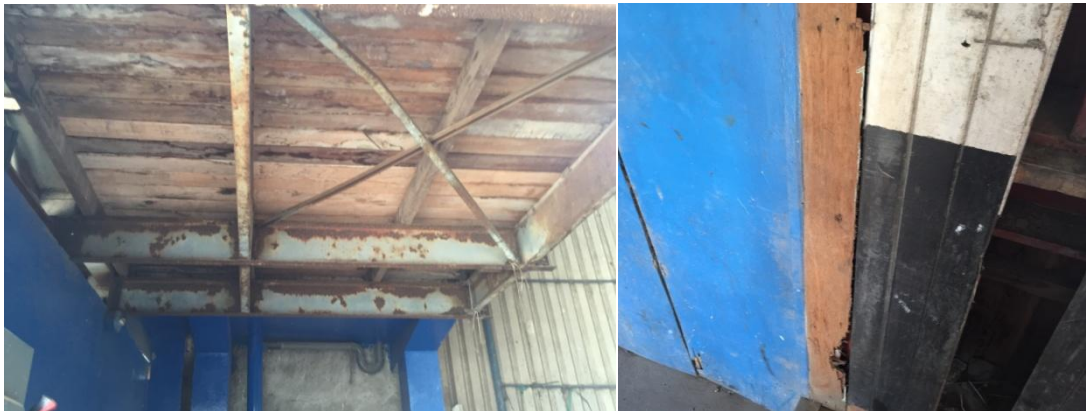
Figura 7. Entrepiso y paredes livianas en mal estado
