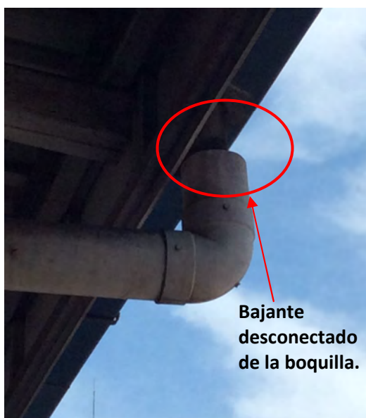
Figura 2.2. Canoas del edificio N (a), bajantes desconectados y descarga del mismo (b) y (c) respectivamente.
