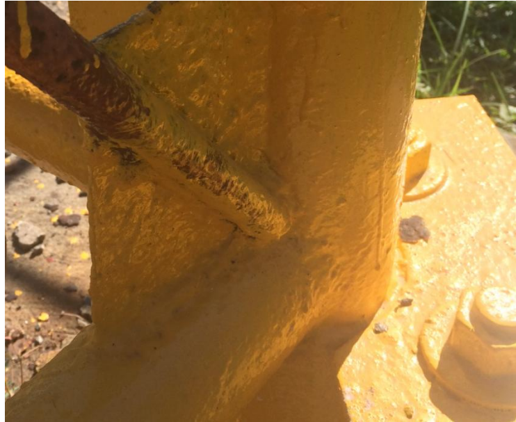
Figura 3. Conexión de arriostres inadecuado
