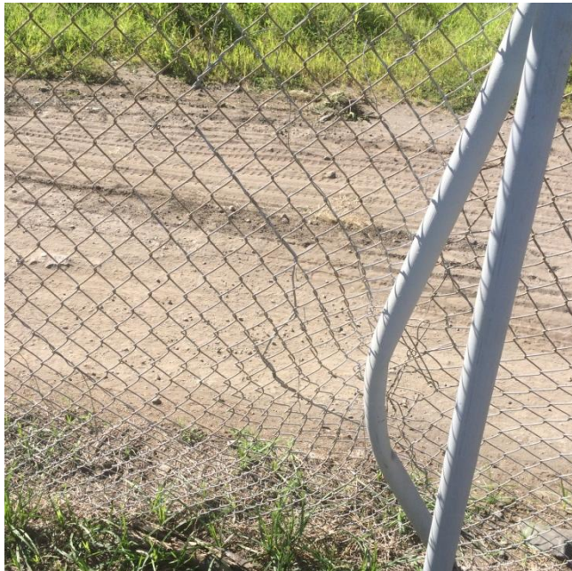
Figura 3. Pandeo visible en tubos de acero de la malla
