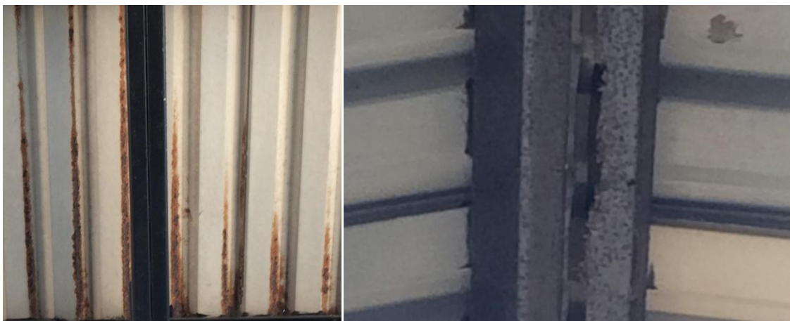
Figura 2. Cubierta de techo y largueros con deterioro por corrosión
