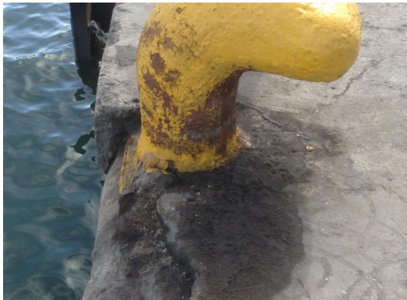
Figura 2. Bases de bitas expuestas
