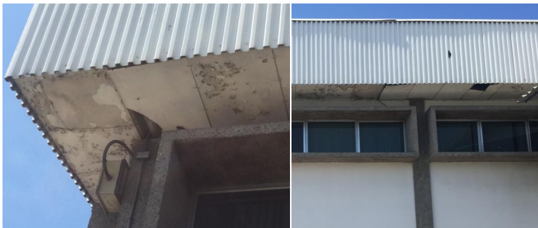
Figura4. Cielos en aleros en mal estado
