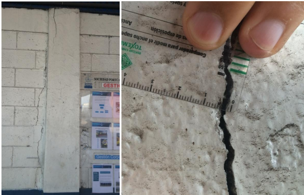
Figura 4. Fisuras en pared de mampostería y en una columna
