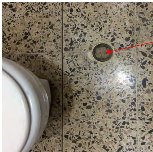
Figura 2.2. Drenaje obstruido en baño de tesorería.
