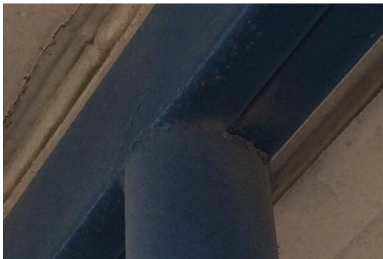
Figura 6. Soldaduras porosas y en mal estado
