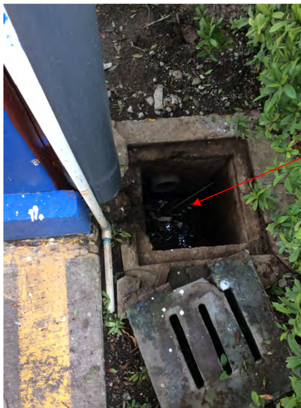
Figura 2.1. Caja de registro para bajante del techo del parqueo #1.
