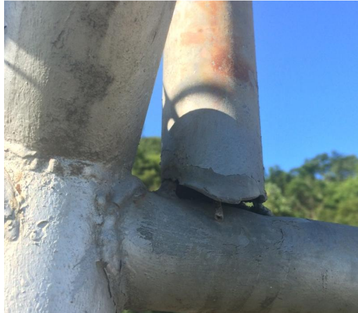
Figura 6. Soldadura en mal estado
