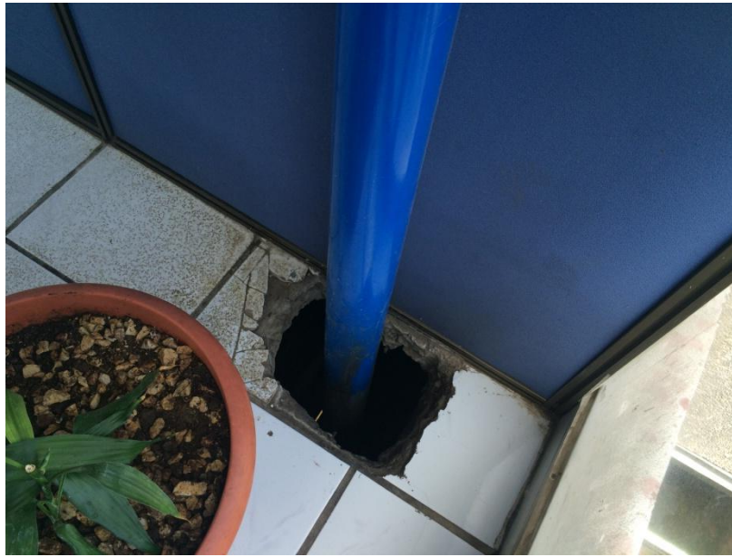
Figura 3. Instalaciones mecánicas sin pasantes
