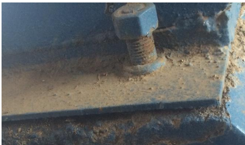
Figura 9. Elementos de unión en mal estado
