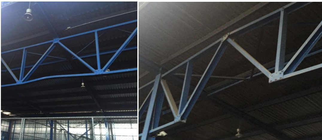
Figura 4. Elementos de acero faltantes o con deformaciones
