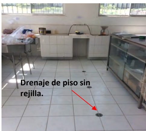
Figura 2.7. Drenajes de piso en cuarto sucio.
