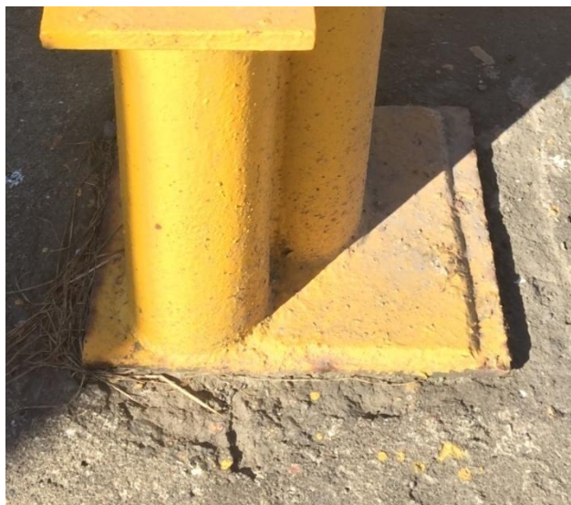
Figura 5. Placa de asiento separada de concreto
