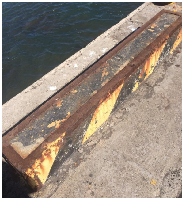
Figura 1. Muro guarda ruedas
