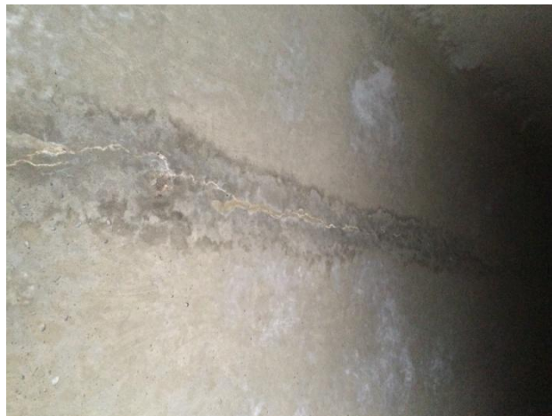
Figura 7. Fisuras en losa de concreto
