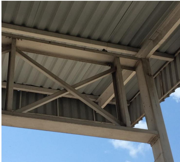
Figura 3. Conexión inadecuada entre cercha de amarre y columna
