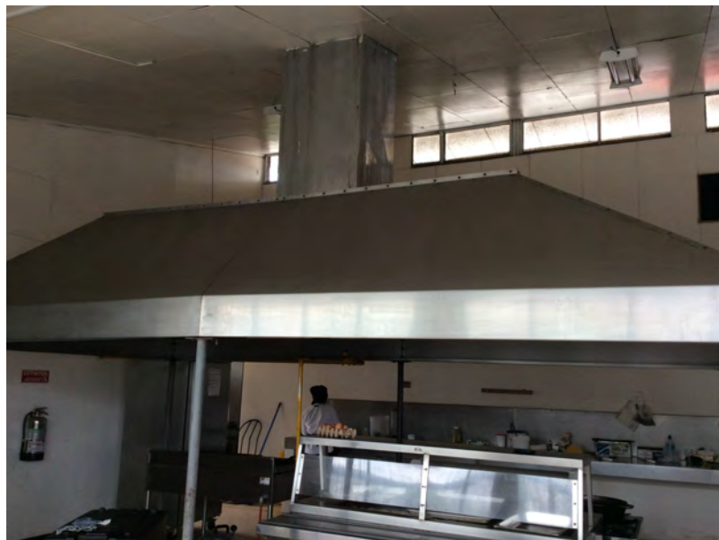
Figura 2.4. Campana de extracción en la cocina.
