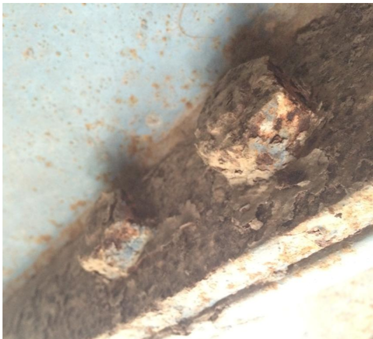
Figura 11. Pernos presentan alta corrosión
