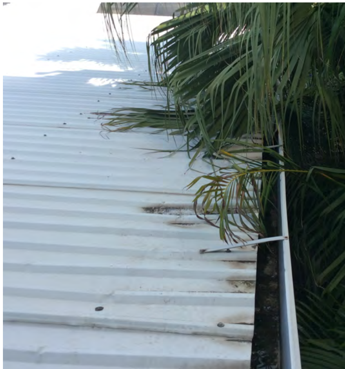
Figura 2.2. Canoas obstruidas por hojas de palmera.
