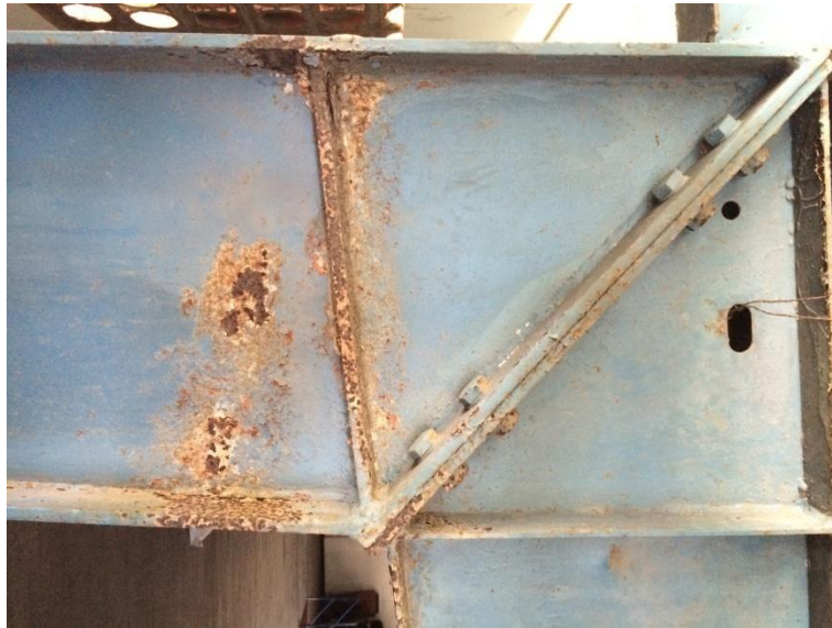
Figura 12. Elementos estructurales presentan corrosión
