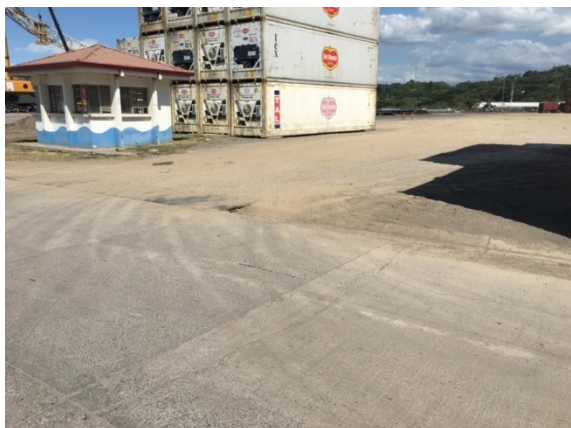
Figura 34. Señal horizontal deteriorada, al lado de acceso al patio 4
