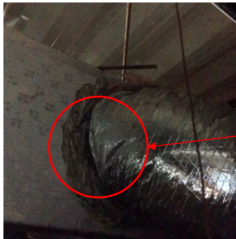
Figura 2.46. Conexión de ducto flexible a rígido en el departamento de Contabilidad.
