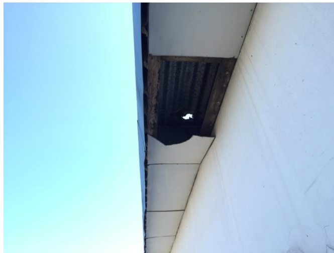
Figura 6. Sección de cielorraso faltante y orificio en cubierta de techo
