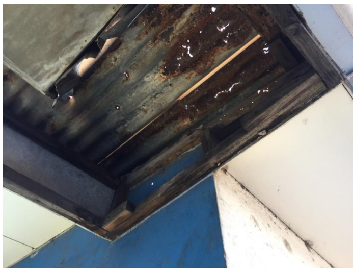
Figura 5. Cubierta de techo con óxido
