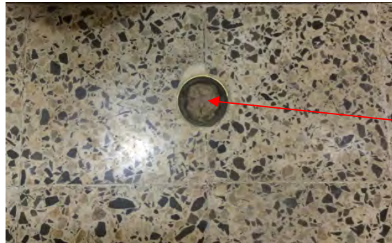
Figura 2.37. Desagües de piso obstruidos.
