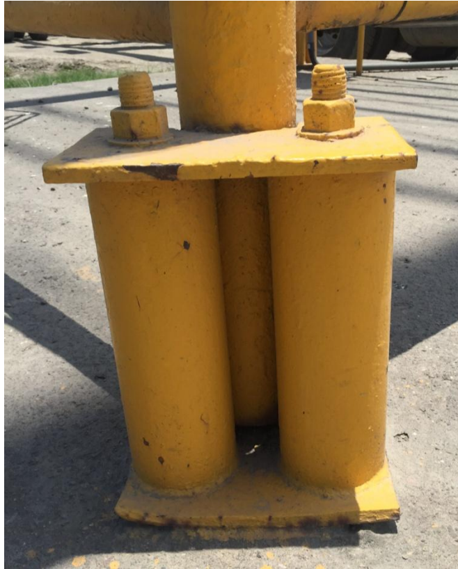
Figura 4. Placa de asiento separada de concreto
