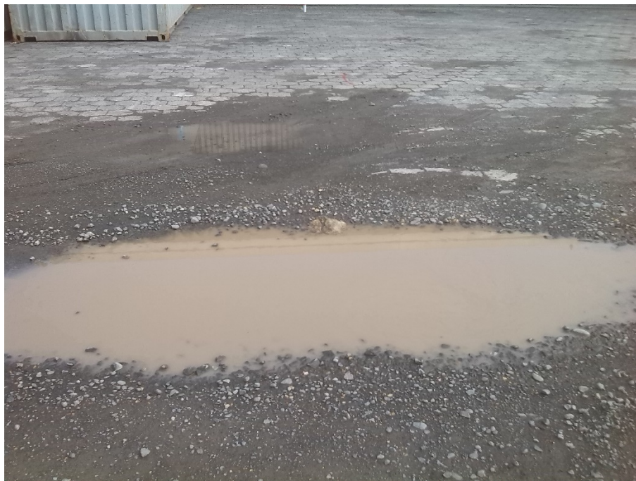
Figura 20. Hundimiento y Contaminación de con agregados en Sección de Almacén Fiscal Sur
