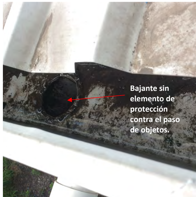
Figura 2.1. Boquilla de la canoa del parqueo #3.
