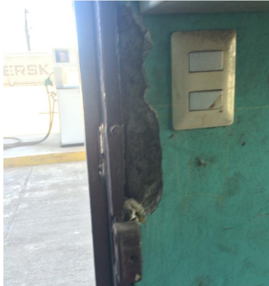
Figura 7. Buque de puerta con pérdida de recubrimiento
