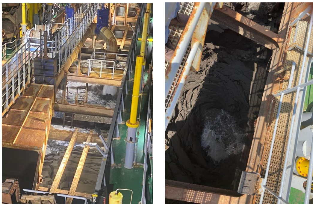
Figura N. 9 Descarga en sitio de botado (Izq.) Vista General (Der.) Vista de la tolva Fuente: Fotografía tomada por Millán Ingeniería
