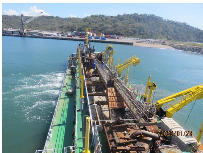
Dragado de la dársena 2023
