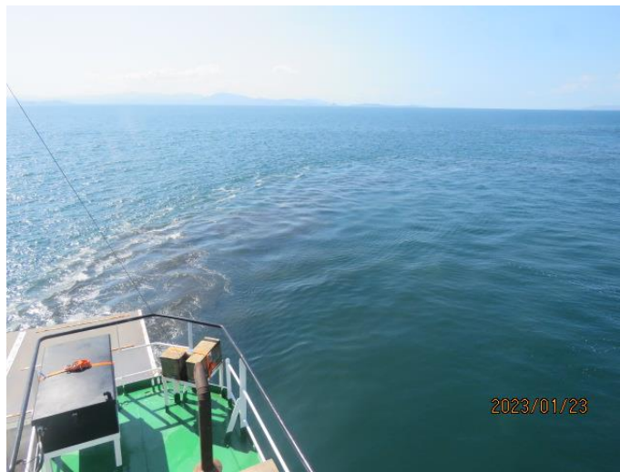
La regencia verifica que el material dragado se hunde rápidamente en el sitio de descarga.
