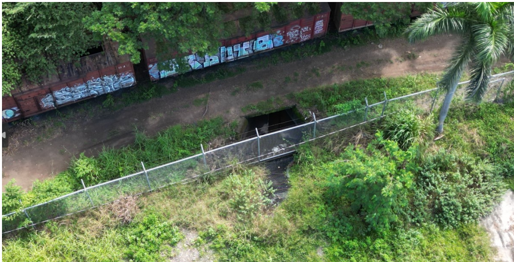
Figura 11. Alcantarilla para el manejo de aguas en el camino de acceso; obstruida por material vegetal y basura
