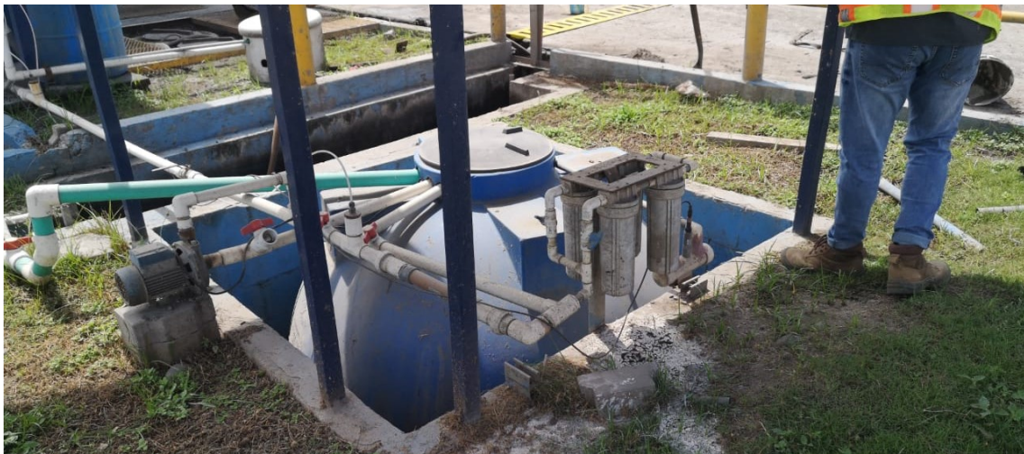
Figura 18. Planta de tratamiento de aguas residuales.
