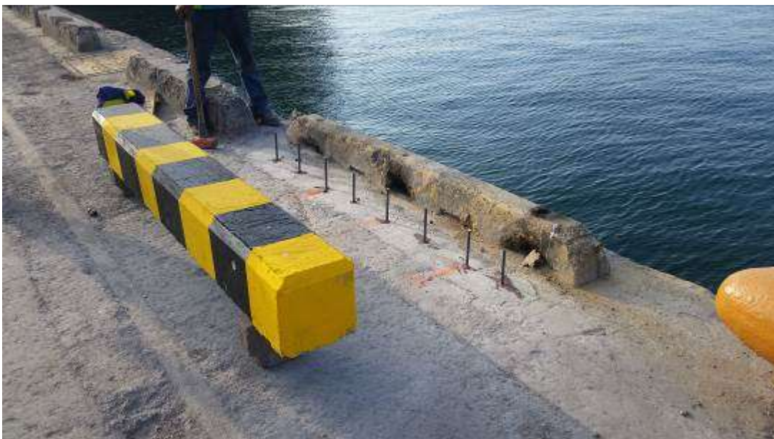
Figura 18. Colocación de muros guardaruedas prefabricados en puesto uno.
