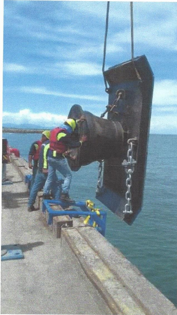
Figura 19. Instalación de panel reparado en puesto 2
