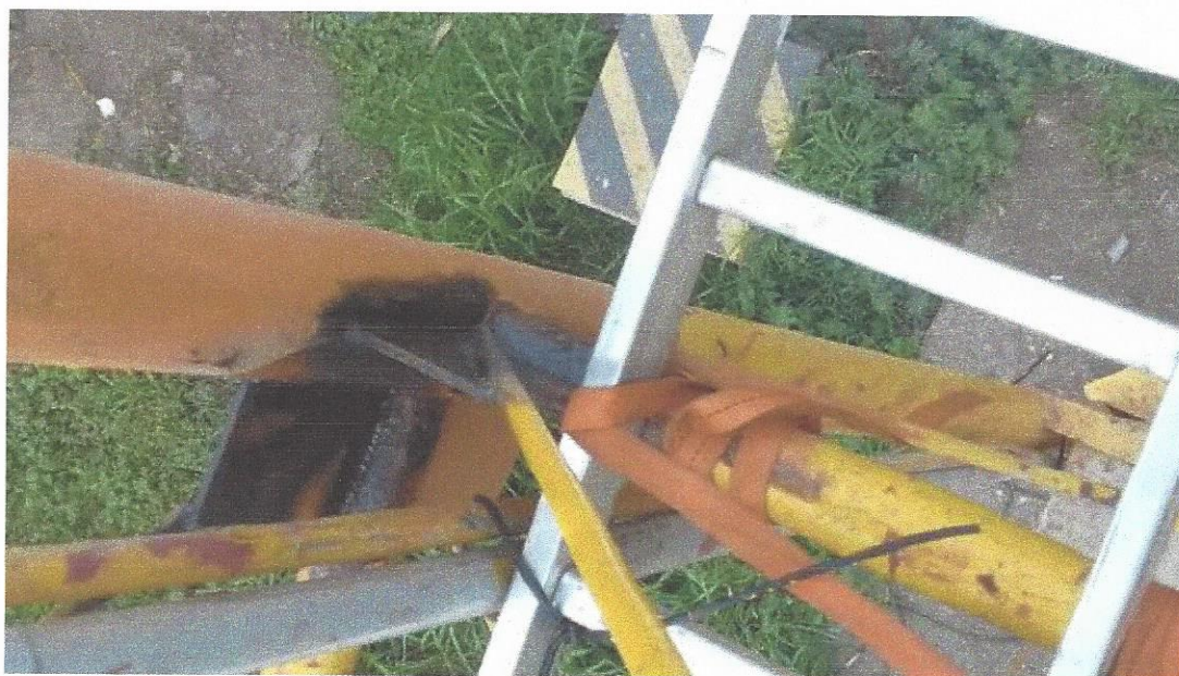
Figura 51. Placa metálica y tensora nuevas instaladas
