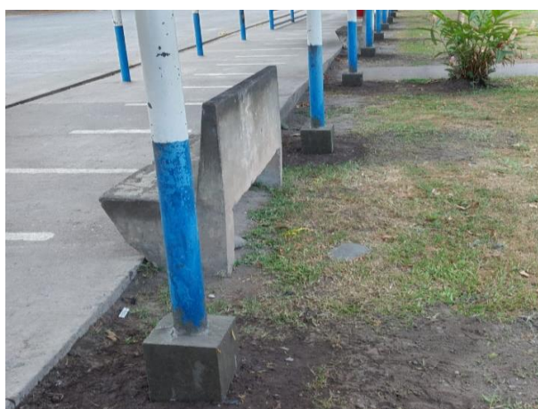
Figura 2. Reparación de bases de postes paso techado acceso ECO 3
