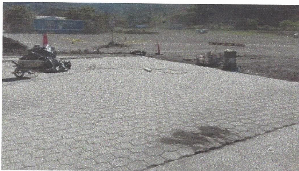
Figura 8. Reparación de adoquines junto a intersección de concreto
