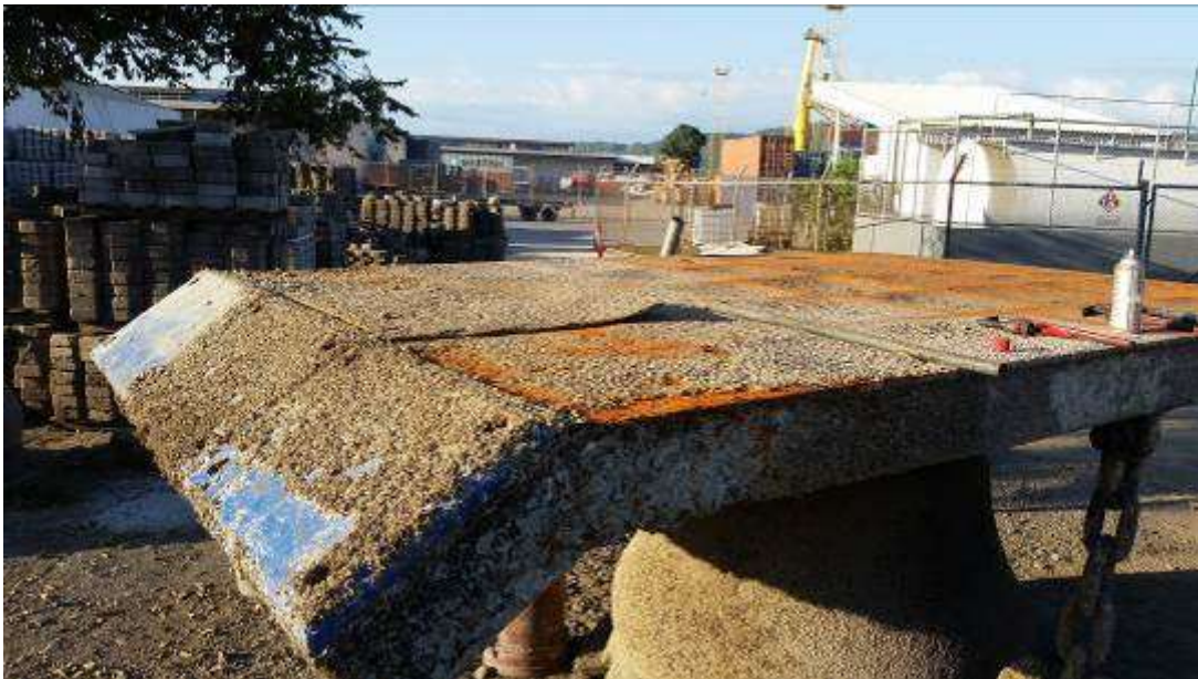
Figura 36. Panel de defensa marina extraída para mantenimiento
