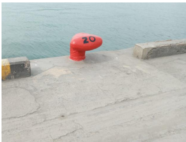
Figura 27. Proceso de acabado final para bitas que dividen puestos de atraque
