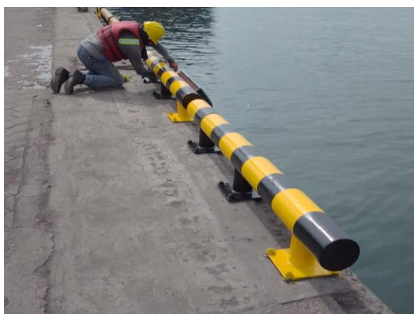
Figura 29. Muro guardarueda fabricado e instalado
