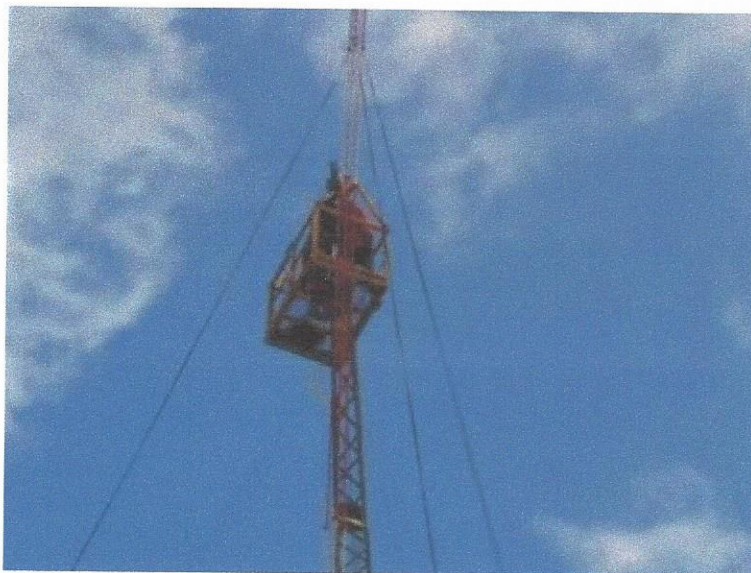
Figura 59. Mantenimiento sistema contra descargas atmosféricas revisión mástil en altura
