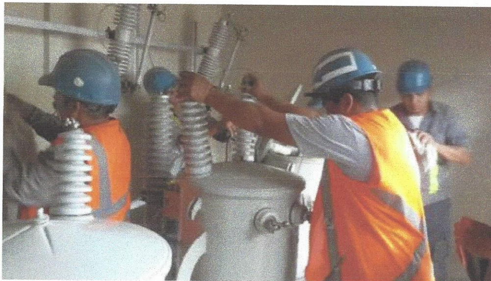
Figura 52. Mantenimiento bancos de transformadores preparación
