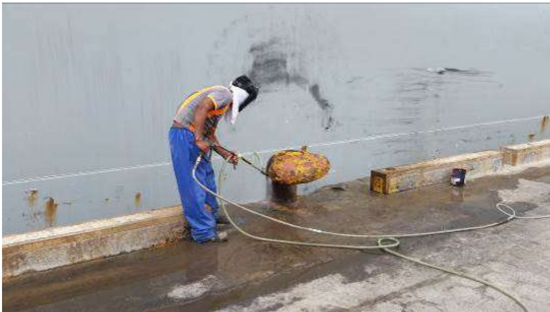
Figura 14. Proceso de mantenimiento de bitas
