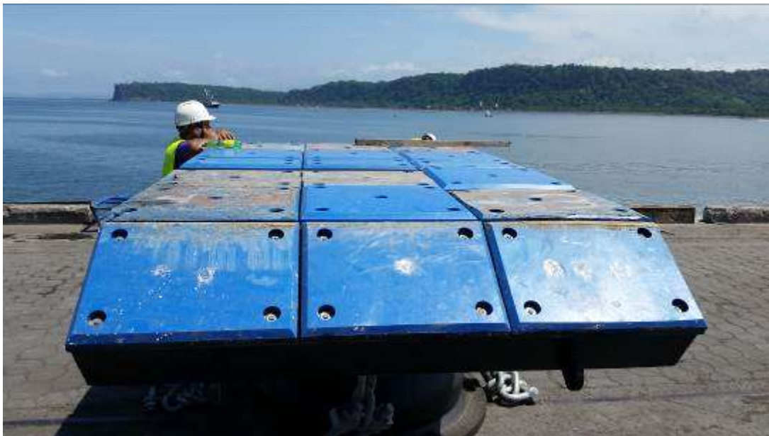
Figura 39. Panel de defensa marina ya reparado y listo para colocarse nuevamente.
