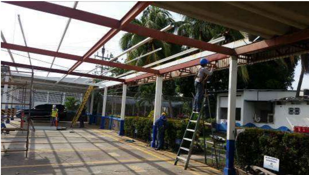
Figura 41. Instalación de nuevos clavadores y pintura de estructura metálica existente
