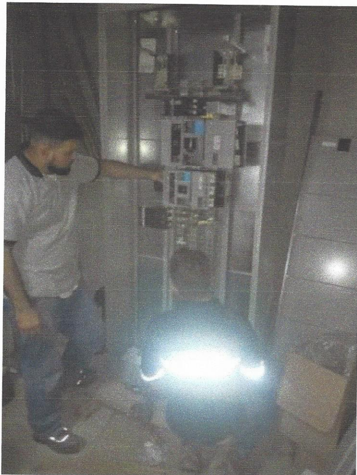
Figura 72. Cambio centro de carga INCOP instalación nuevo panel
