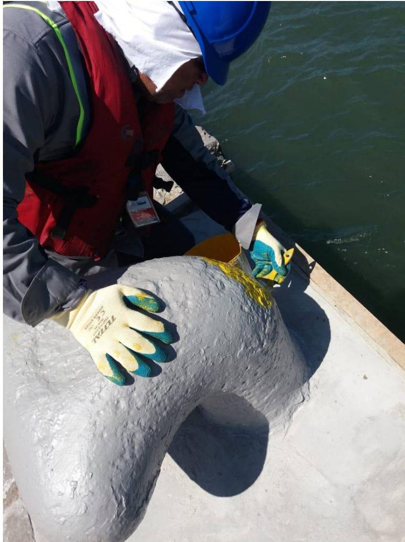
Figura 25. Bita con pintura base ya aplicada
