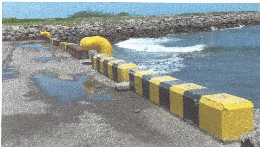
Figura 17. Nuevos muros instalados en pantalla de atraque
