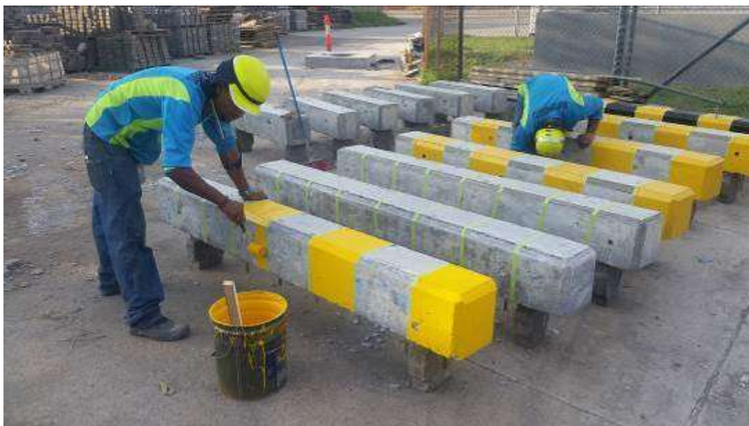
Figura 17. Preparación de muros guardaruedas prefabricados
