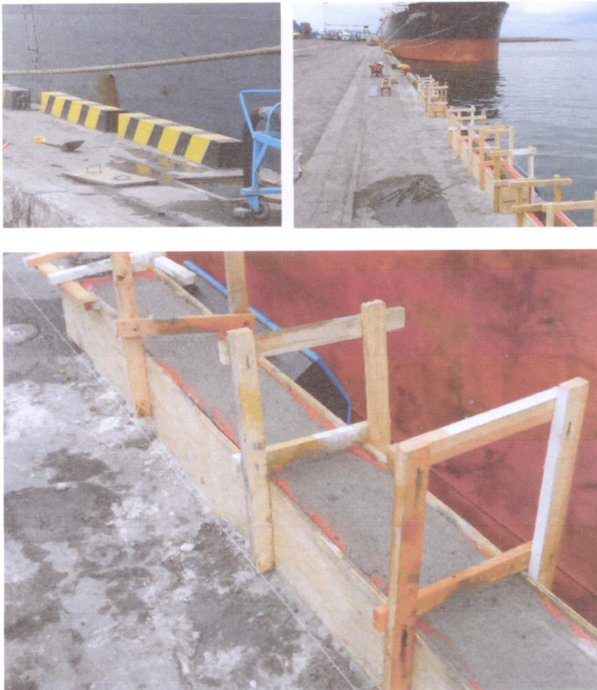
Figura 4. Mantenimiento de guarda ruedas
