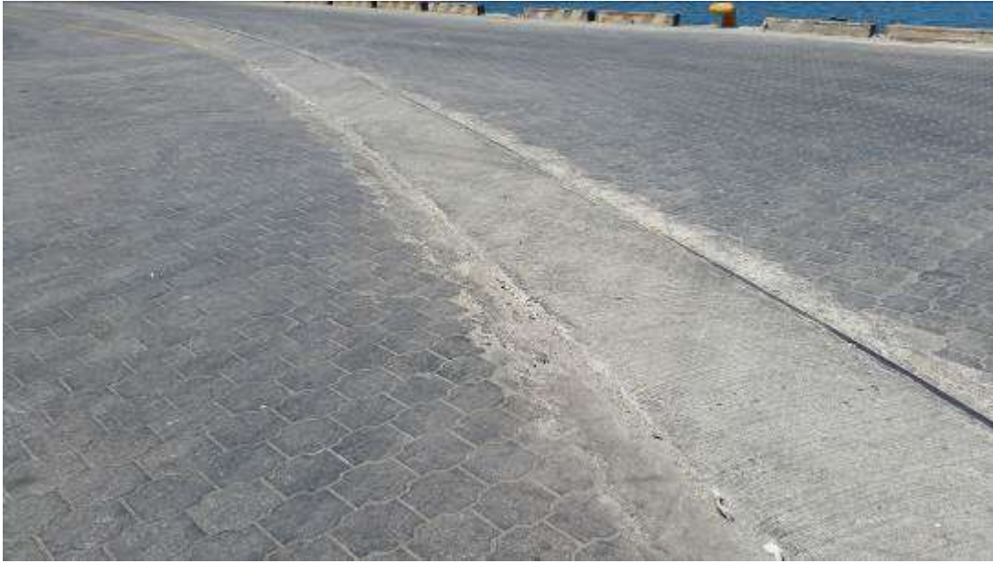
Figura 10. Reparación de línea del ferrocarril según priorización
