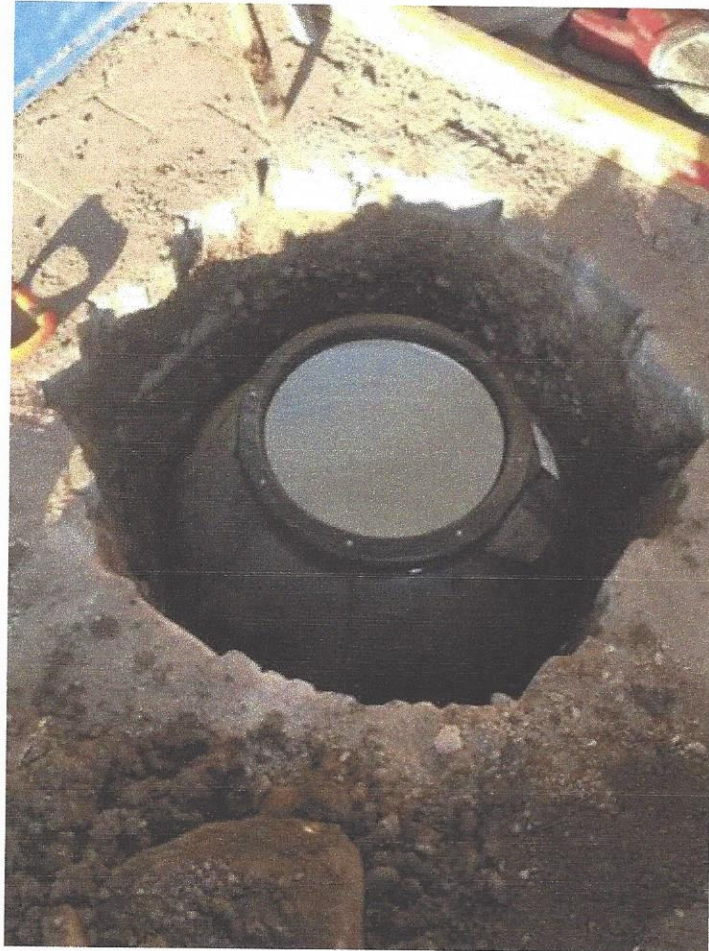
Figura 66. Cambio transformador bodega 1 ubicación tanque para derrames
