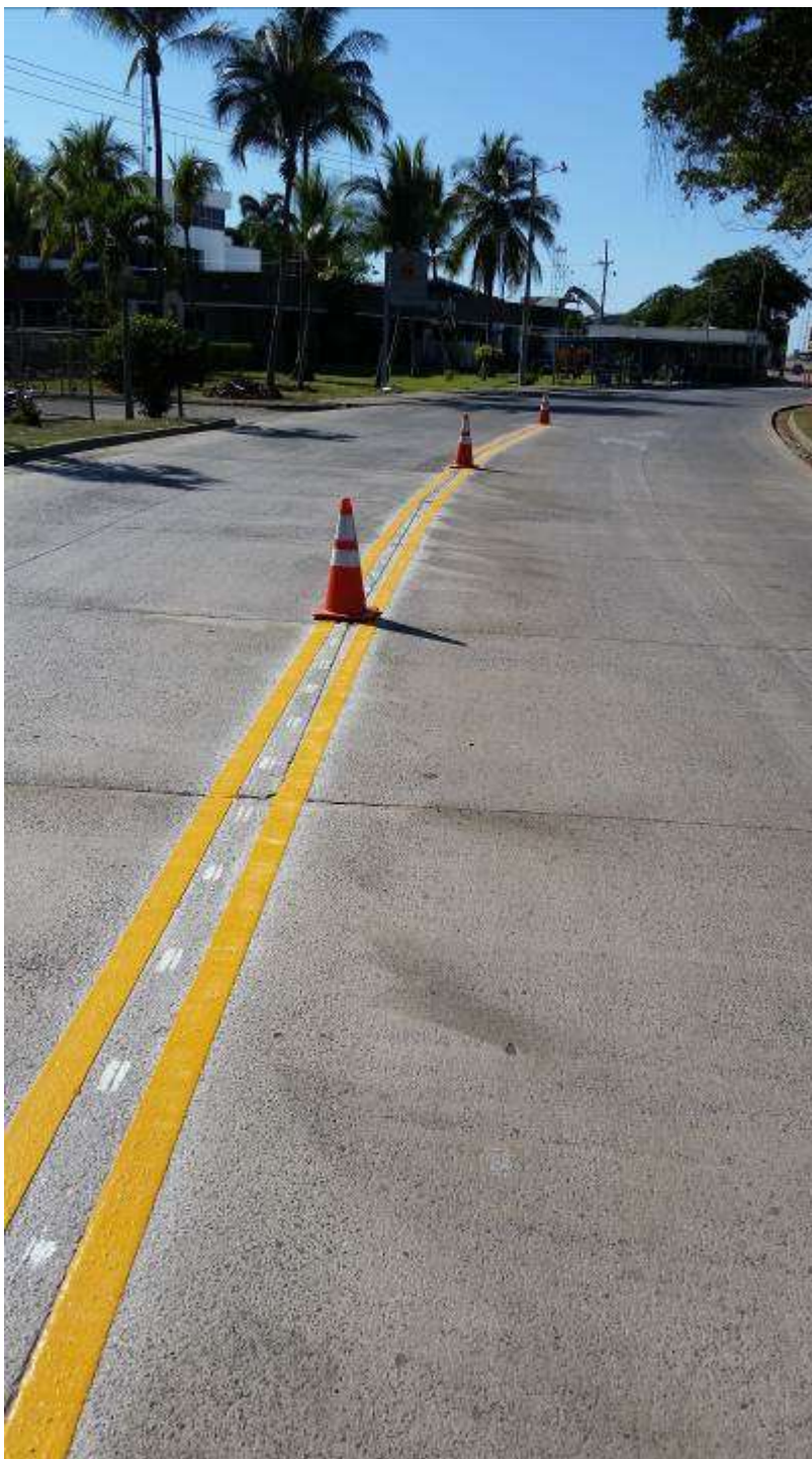
Figura 7. Acabado de doble línea amarilla con pintura termoplástica
