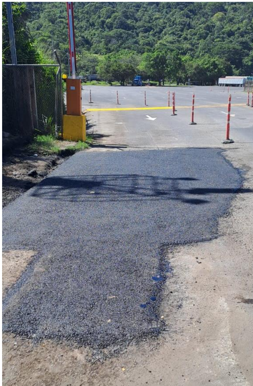
Figura 19. Reparación hundimiento a la salida de ECO 1
