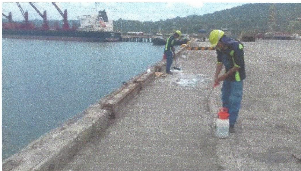
Figura 27. Acabado con mortero de nivelación sobre los canales intervenidos.
