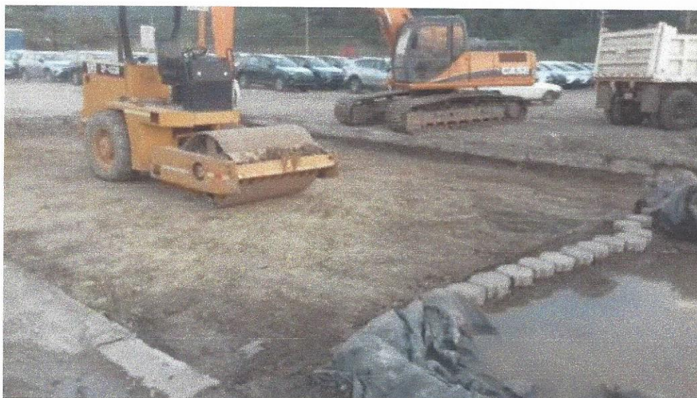
Figura 5. Gaveta de reparación pavimento de adoquines
