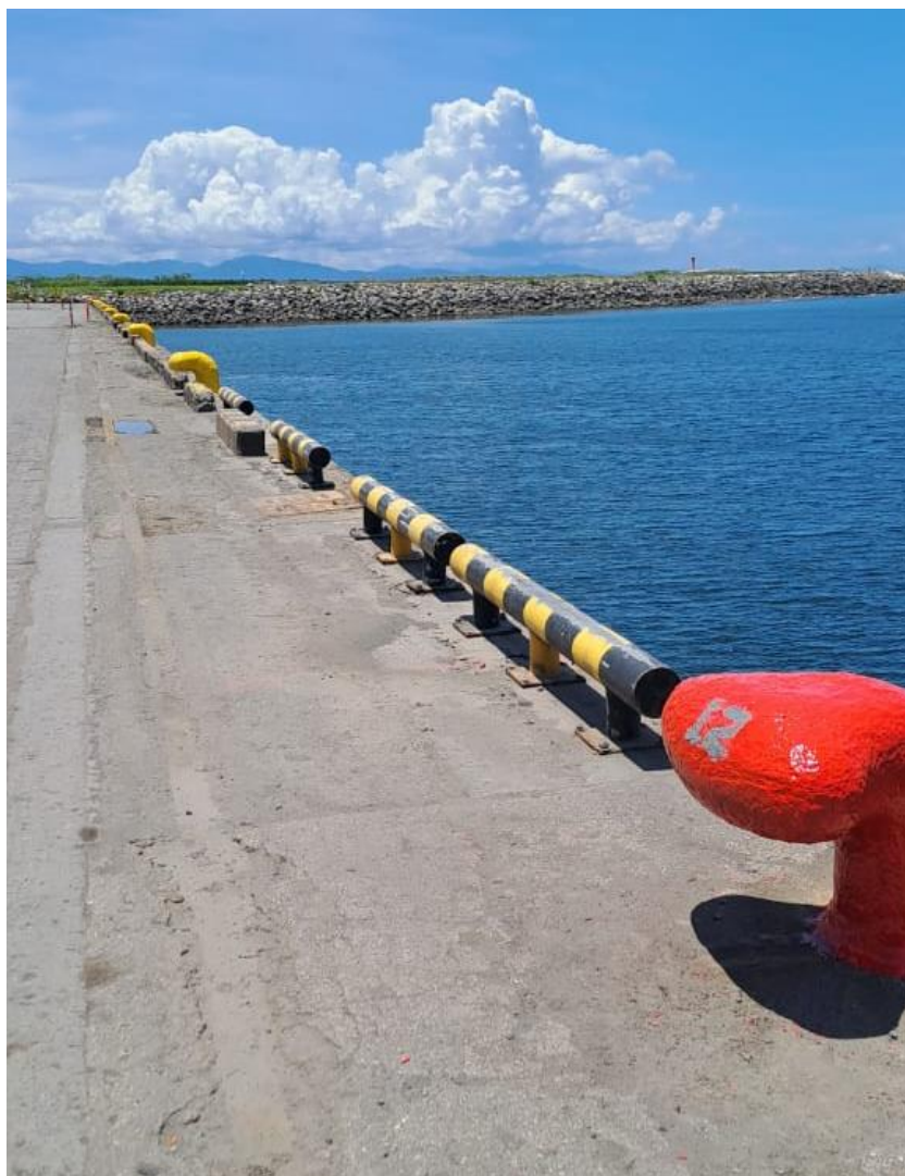
Figura 26. Bitas con pintura de acabado y numeración
