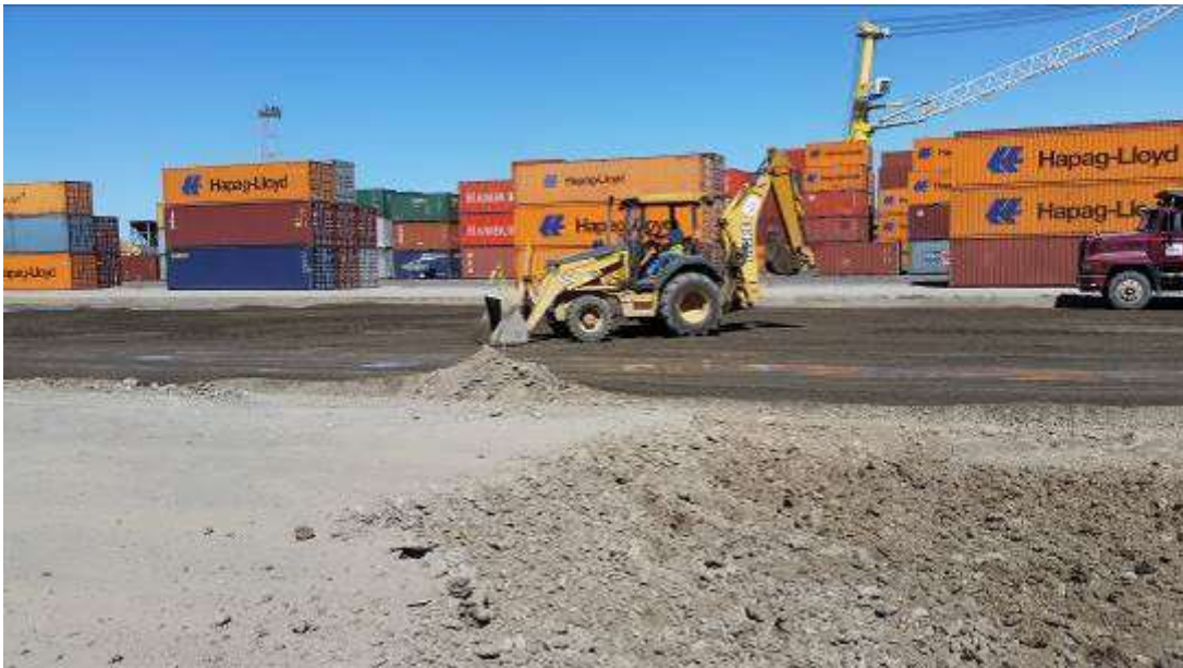
Figura 21. Trabajos de conformación del relleno de patio dos.
