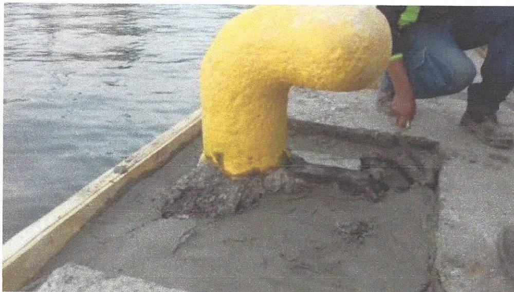
Figura 14. Proceso de aplicación de mortero de reparación en bases
