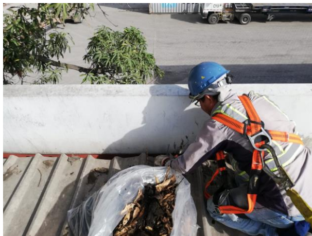
Figura 3. Limpieza y reparaciones en canoas
