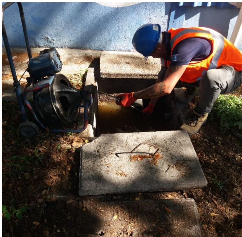
Figura 4. Limpieza de tanques sépticos y sondeo de tuberías
