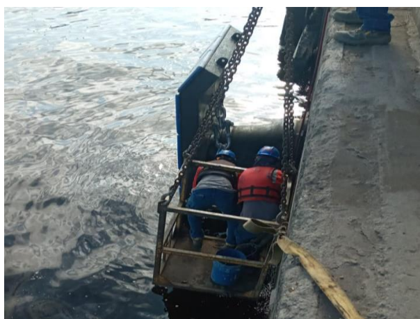
Figura 32. Instalación defensas en sitio
