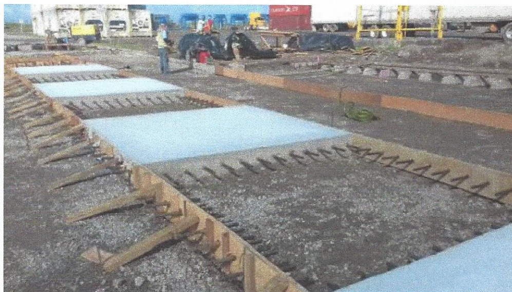
Figura 3. Colado de losas de concreto
