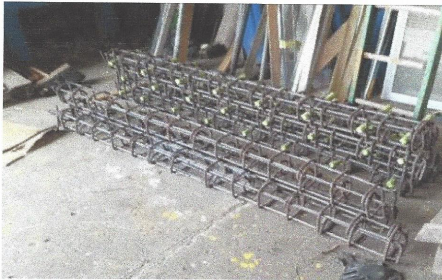
Figura 15. Confección de armaduras para muros guardaruedas
