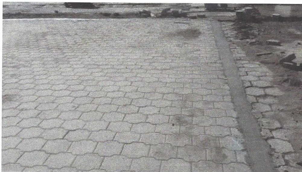
Figura 9. Confinamiento perimetral de área de adoquines intervenida
