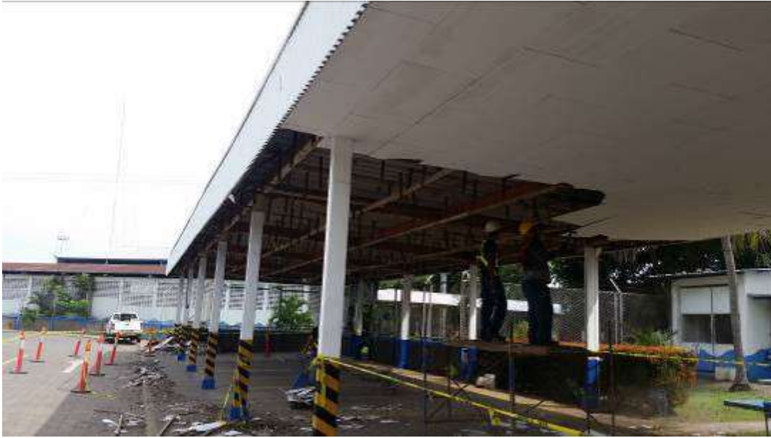
Figura 40. Desmantelamiento del parqueo existente
