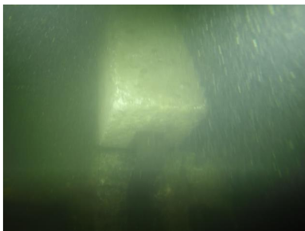
Figura 55. Ánodo instalado
