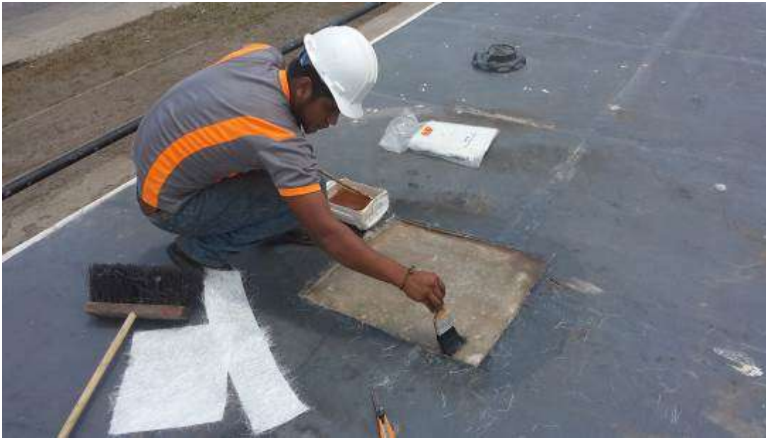
Figura 27. Reparación en perforación de muelle tender
