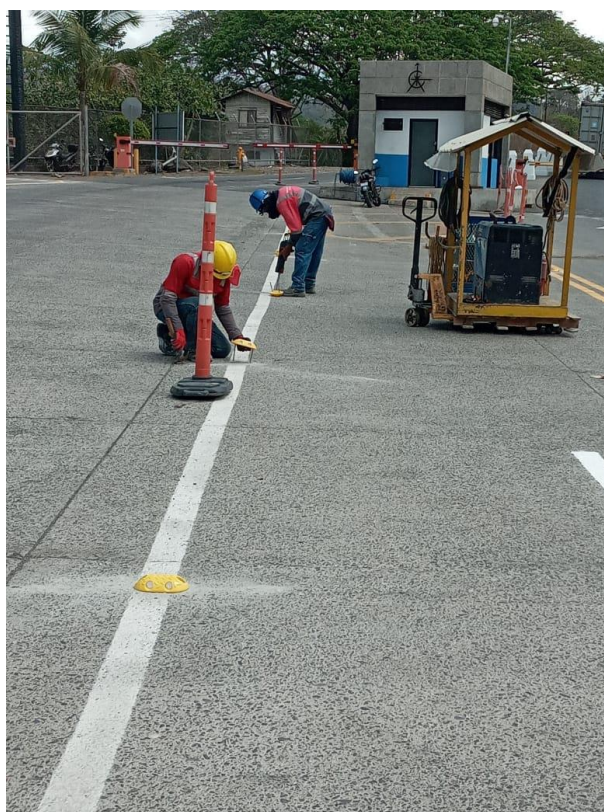
Figura 40. Instalación de capta luces
