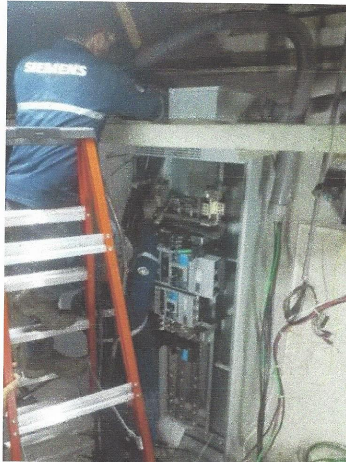
Figura 74. Cambio centro de carga INCOP, detalles
