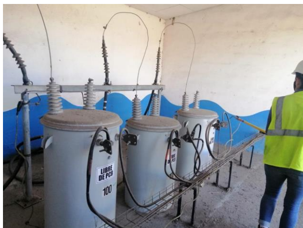
Figura 9. Mantenimiento bancos de transformadores
