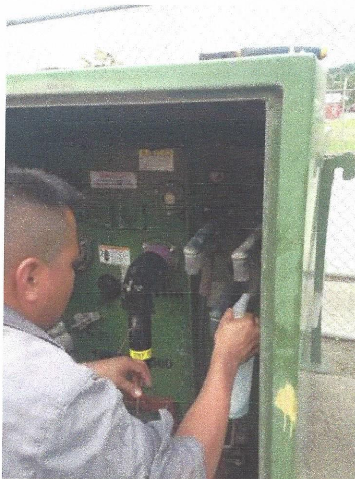
Figura 55. Mantenimiento banco de transformadores limpieza
