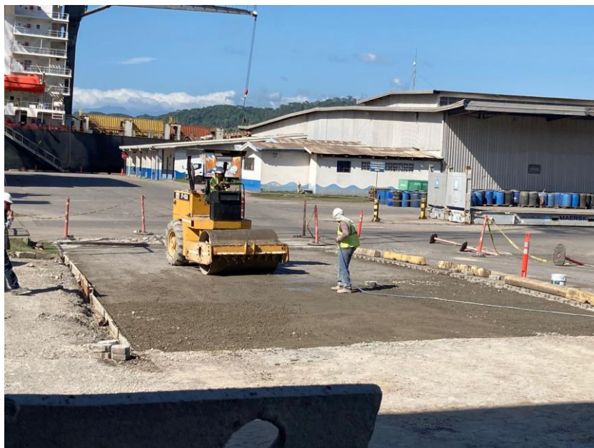
Figura 14. Trabajos de compactación intersección torre 6
