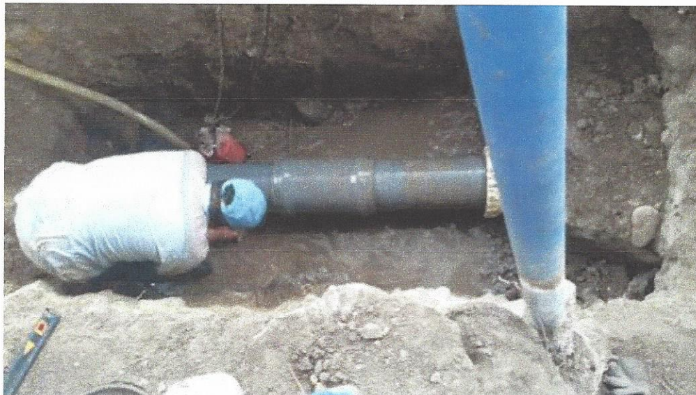
Figura 45. Reparación fuga de agua frente a puesto de revisión de eco 3
