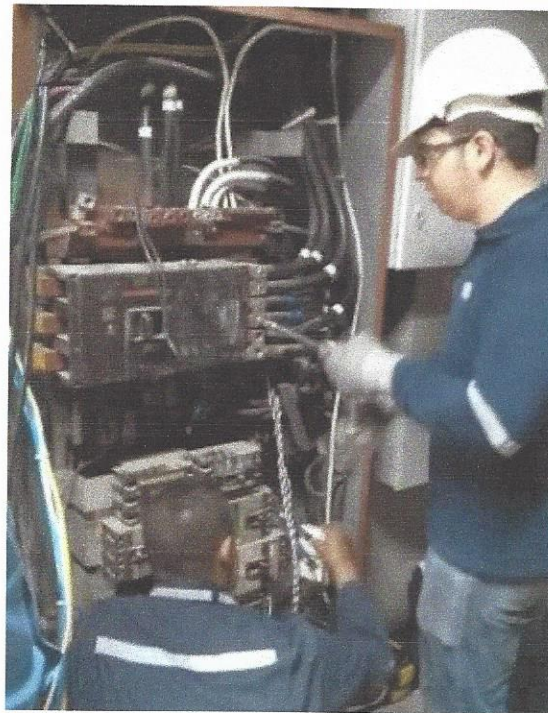
Figura 70. Cambio centro de carga INCOP desinstalación antiguo
