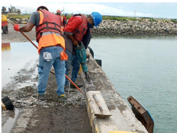
Figura 21. Trabajos de demolición en muros guardarruedas
