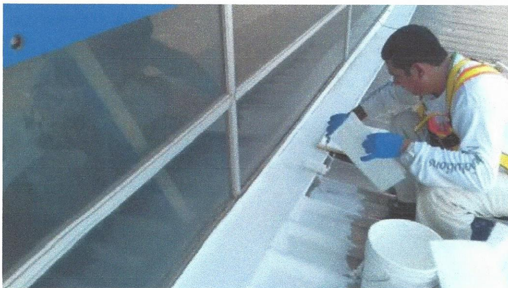
Figura 46. Sello en base de monitores de bodegas 1 y A-220
