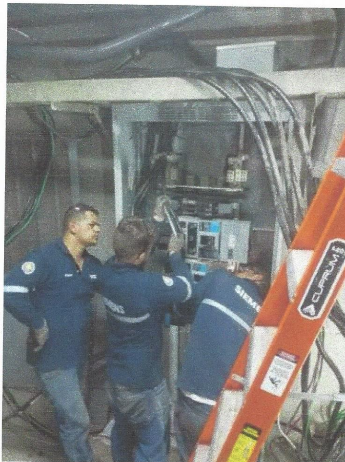
Figura 73. Cambio centro de carga INCOP, instalación acometidas
