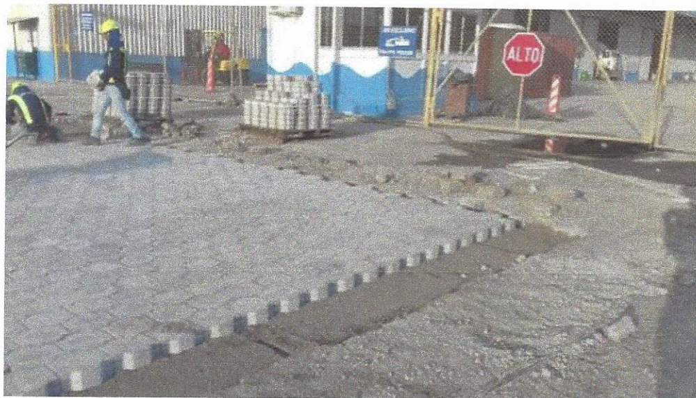
Figura 7. Reparación de adoquines junto a entrada principal almacén fiscal A-220
