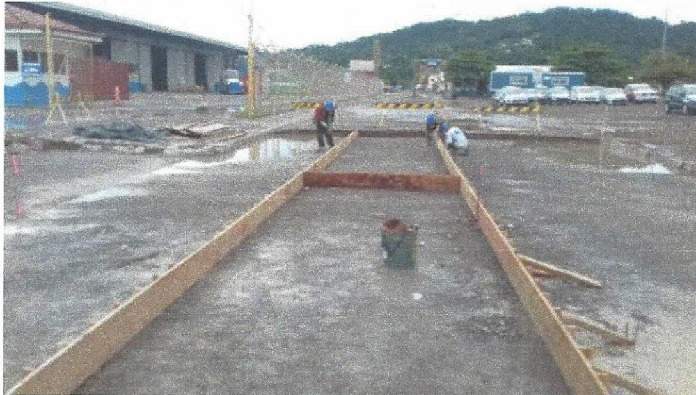
Figura 2. Inicio de colocación de formaleta en intersección de concreto
