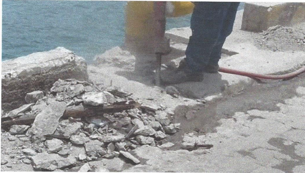
Figura 13. Proceso demolición alrededor de bases de bitas
