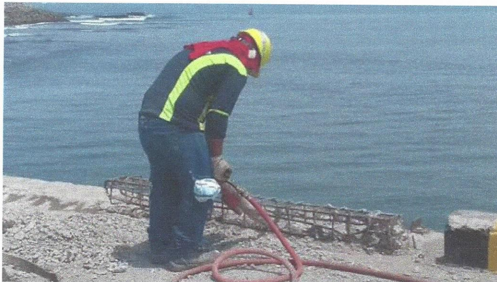
Figura 16. Proceso de demolición de muros dañados en pantalla de atraque
