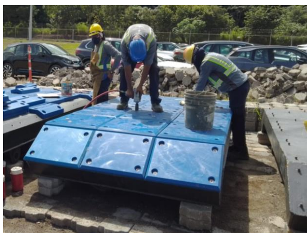
Figura 31. Instalación de baquelitas
