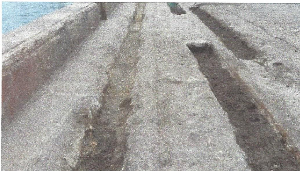
Figura 25. Estado inicial de los trabajos sobre la viga cabezal
