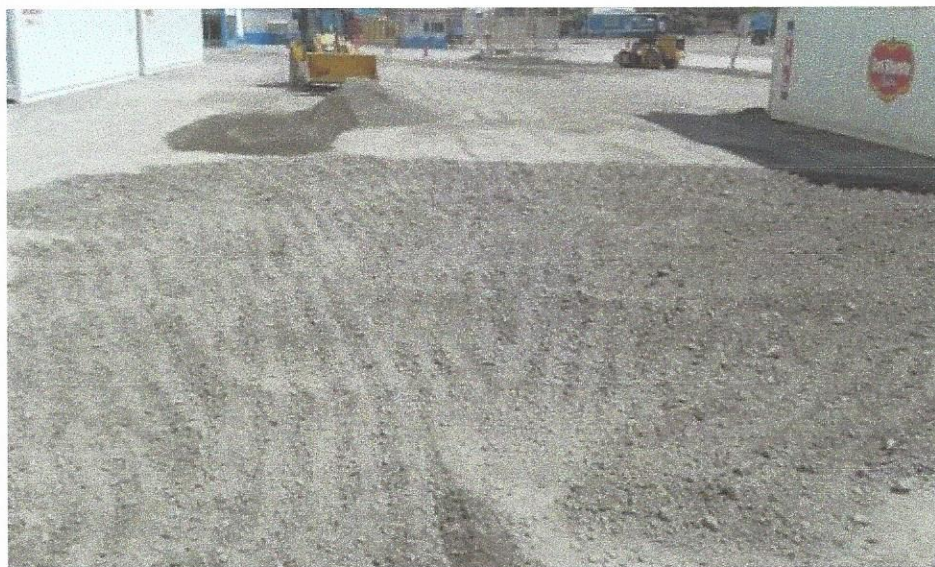
Figura 28. Escarificación y extendido de nuevo material en patio dos
