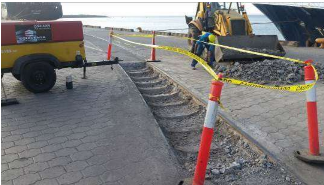
Figura 9. Reparación en pavimentos de concretos entre líneas del ferrocarril puesto 3
