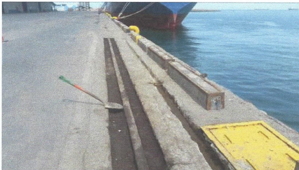
Figura 26. Preparación de canales para colado
