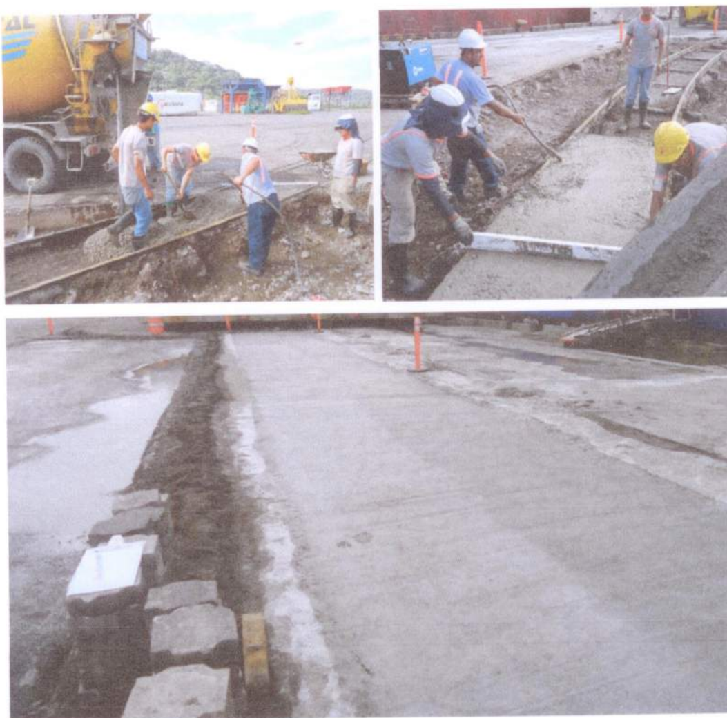
Figura 3. Reparación de pavimentos de concreto
