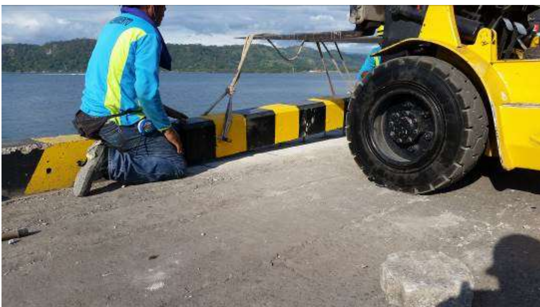
Figura 19. Colocación de muros guardaruedas prefabricados
