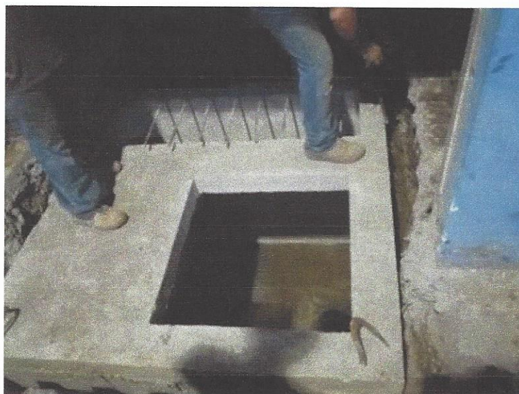
Figura 61. Cambio transformador bodega 1 caja registro eléctrico
