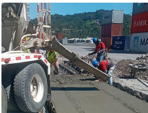
Figura 18. Trabajos de colado con mezcladora
