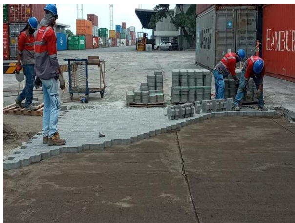
Figura 16. Trabajos en Patio 3 colocación adoquines
