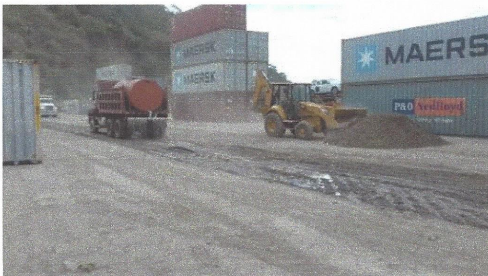
Figura 32. Relleno y humedecimiento previo a la compactación del material de base, patio seis.
