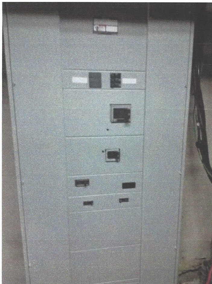
Figura 75. Cambio centro de carga INCOP, trabajo concluido
