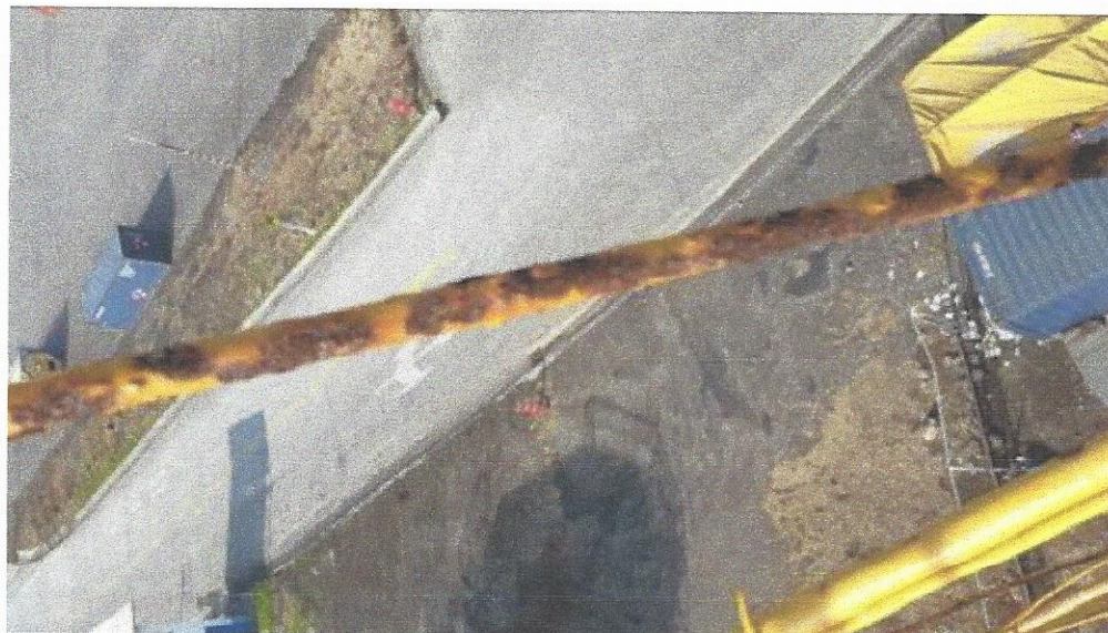
Figura 49. Estado previo de la mayor parte de las tensores intervenidas
