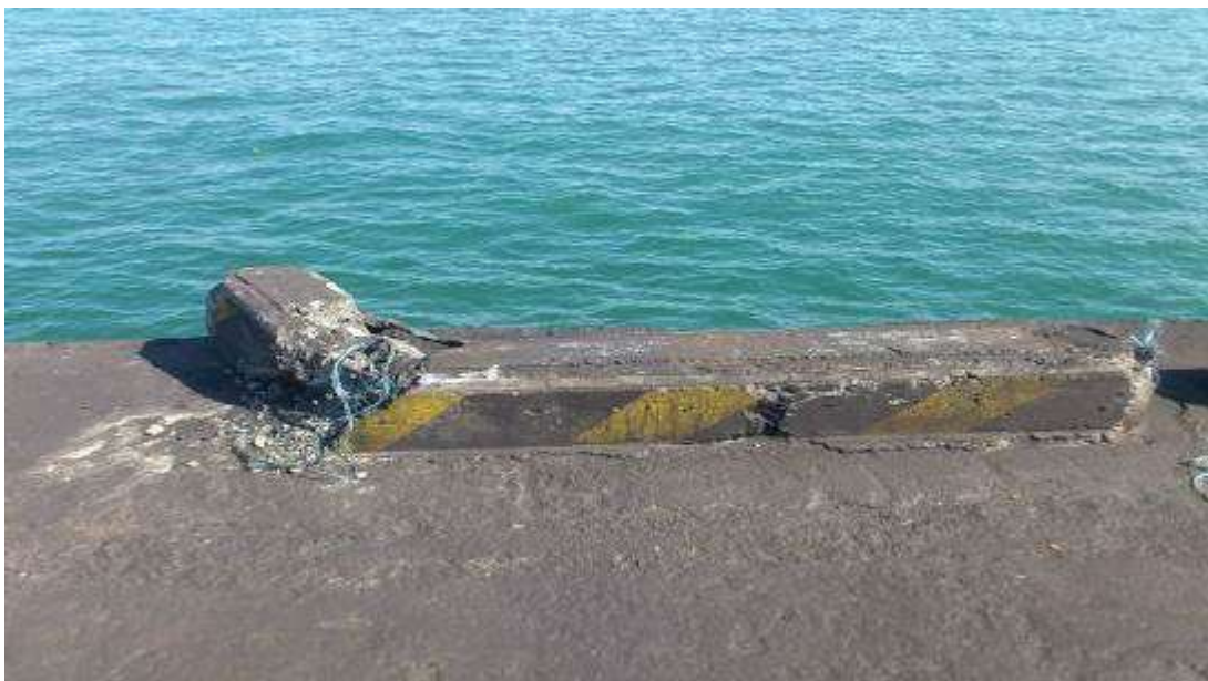
Figura 16. Estado previo de algunos muros guardaruedas
