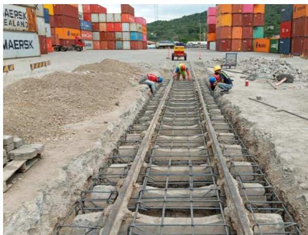
Figura 17. Colocación de armadura
