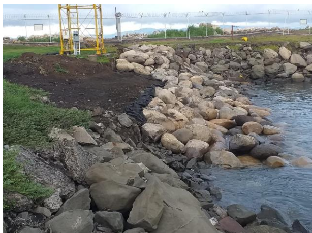
Figura 48. Colocación rocas seleccionadas
