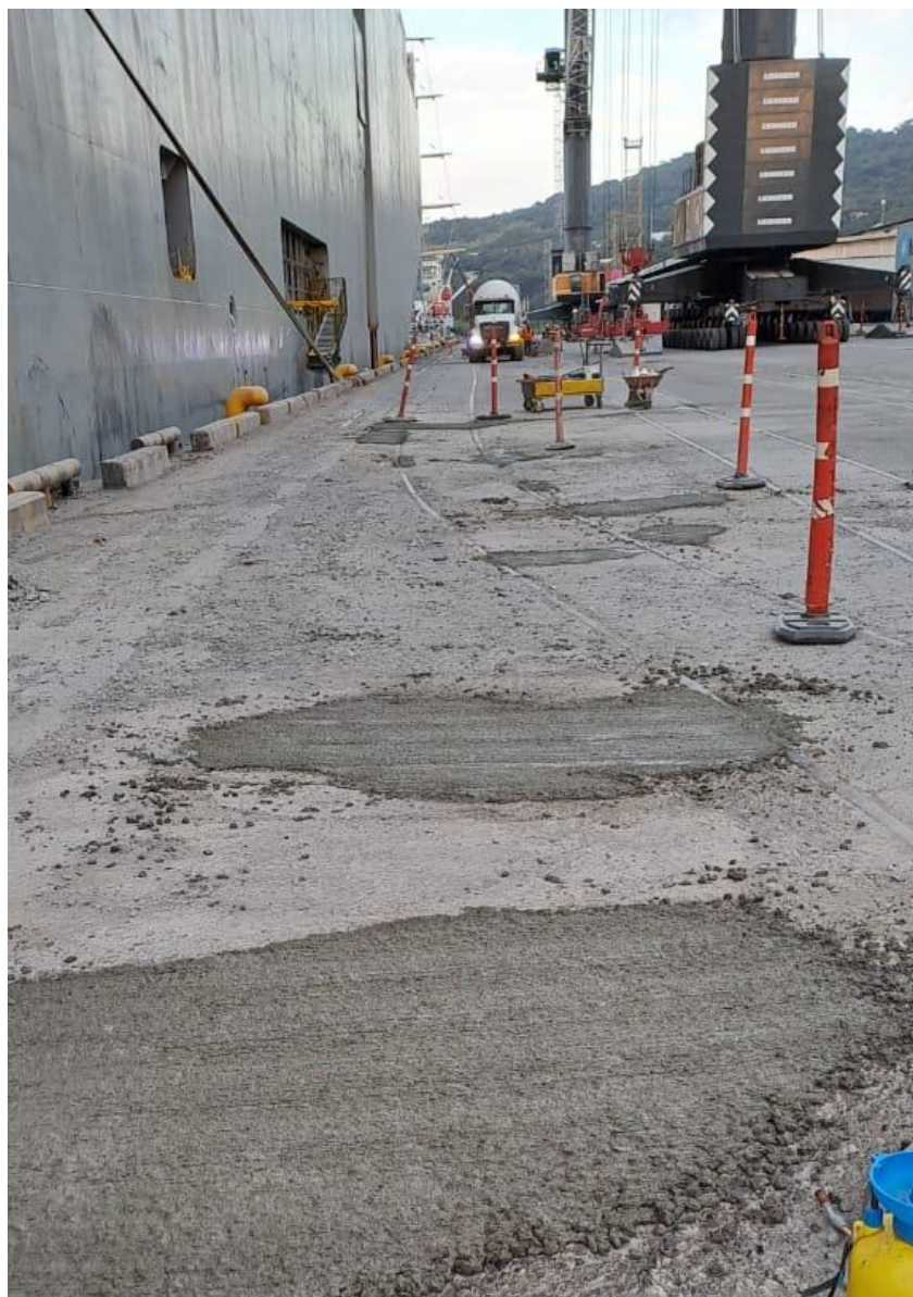
Figura 18. Reparaciones bacheo concreto pantalla entre bitas 3 y 5
