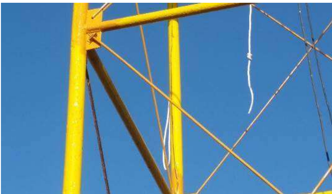
Figura 25. Placas y tensoras nuevas en torre N°4
