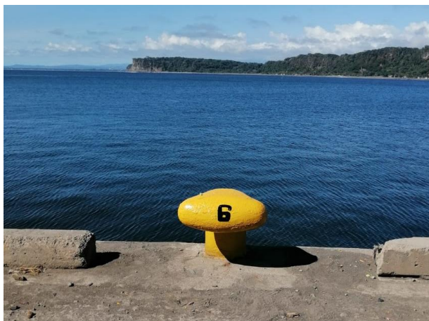
Figura 28. Proceso de acabado final que incluye numeración
