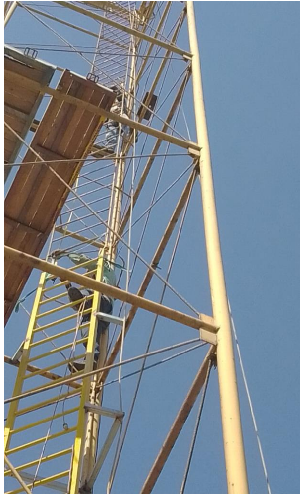
Figura 62. Cambio de escalera torre 3
