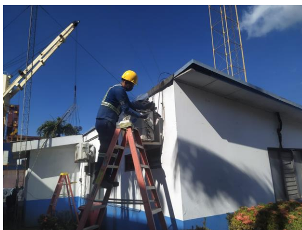
Figura 10. Mantenimiento de sistema de climatización
