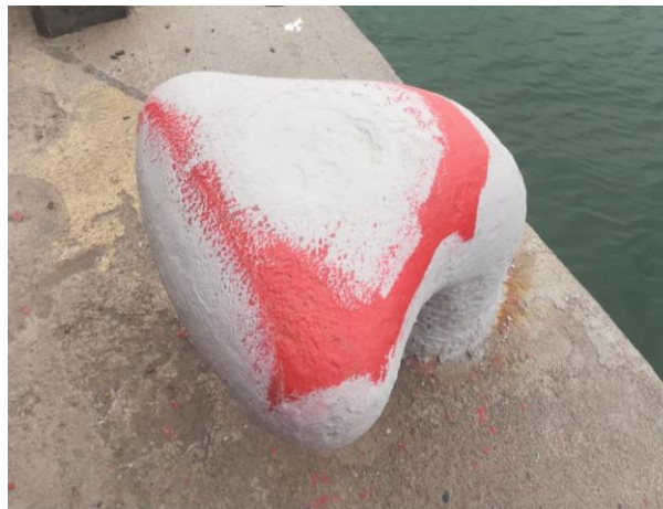
Figura 26. Aplicación de pintura base
