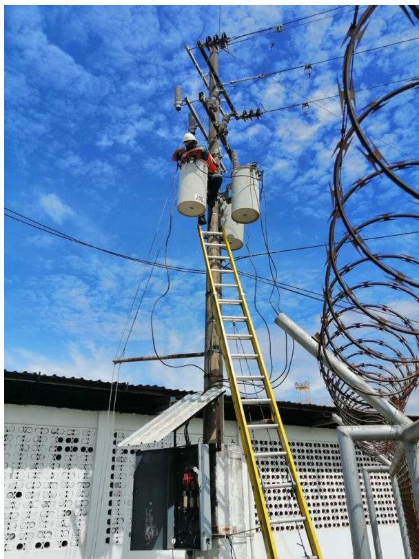
Figura 11. Mantenimiento bancos de transformadores
