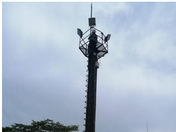
Figura 50. Revisión de dispositivo ionizante
