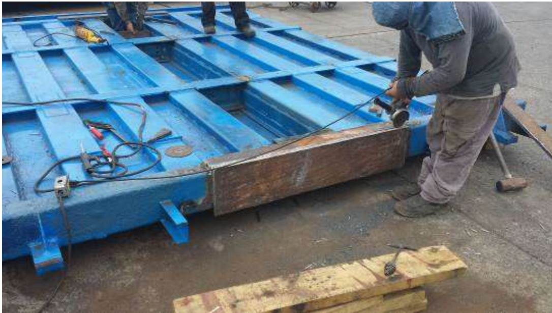
Figura 29. Segmento de puente de entrada reforzado en su estructura
