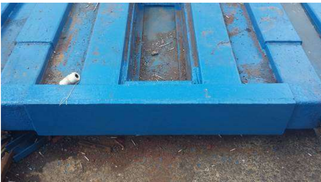
Figura 32. Puente de báscula de entrada reforzado
