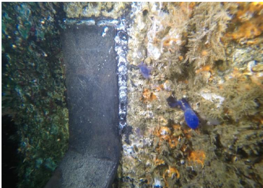
Figura 39. Detalle de soldadura subacuática en una de las patas del ánodo
