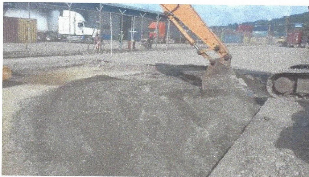
Figura 6. Preparación de base estabilizada
