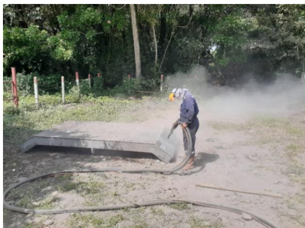
Figura 23. Intervención sand blasting
