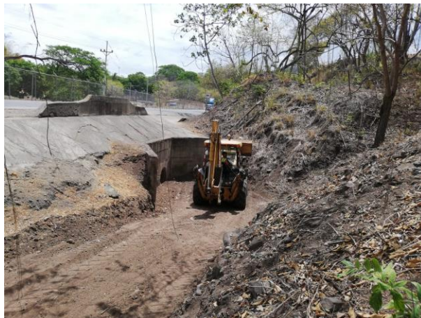
Figura 32. Limpieza sistema pluvial
