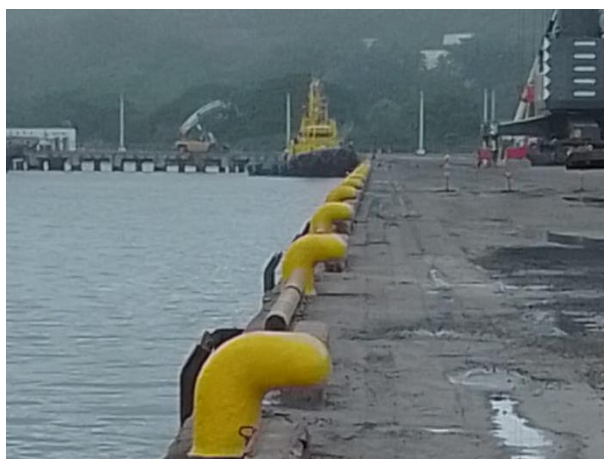
Figura 34. Proceso de acabado final para bitas
