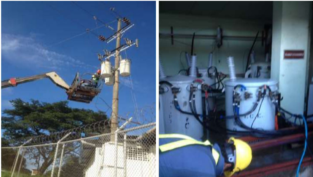
Figura 33. Mantenimiento bancos de transformadores
