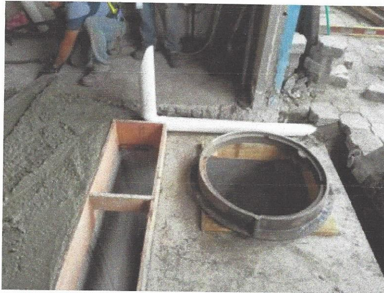
Figura 62. Cambio transformador bodega 1 colado de concreto
