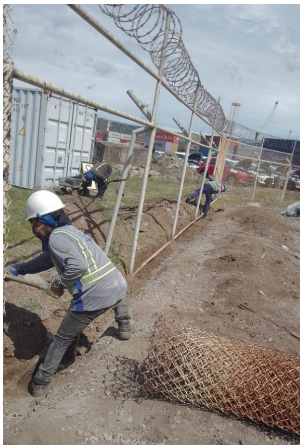
Figura 1. Reparaciones malla perimetral
