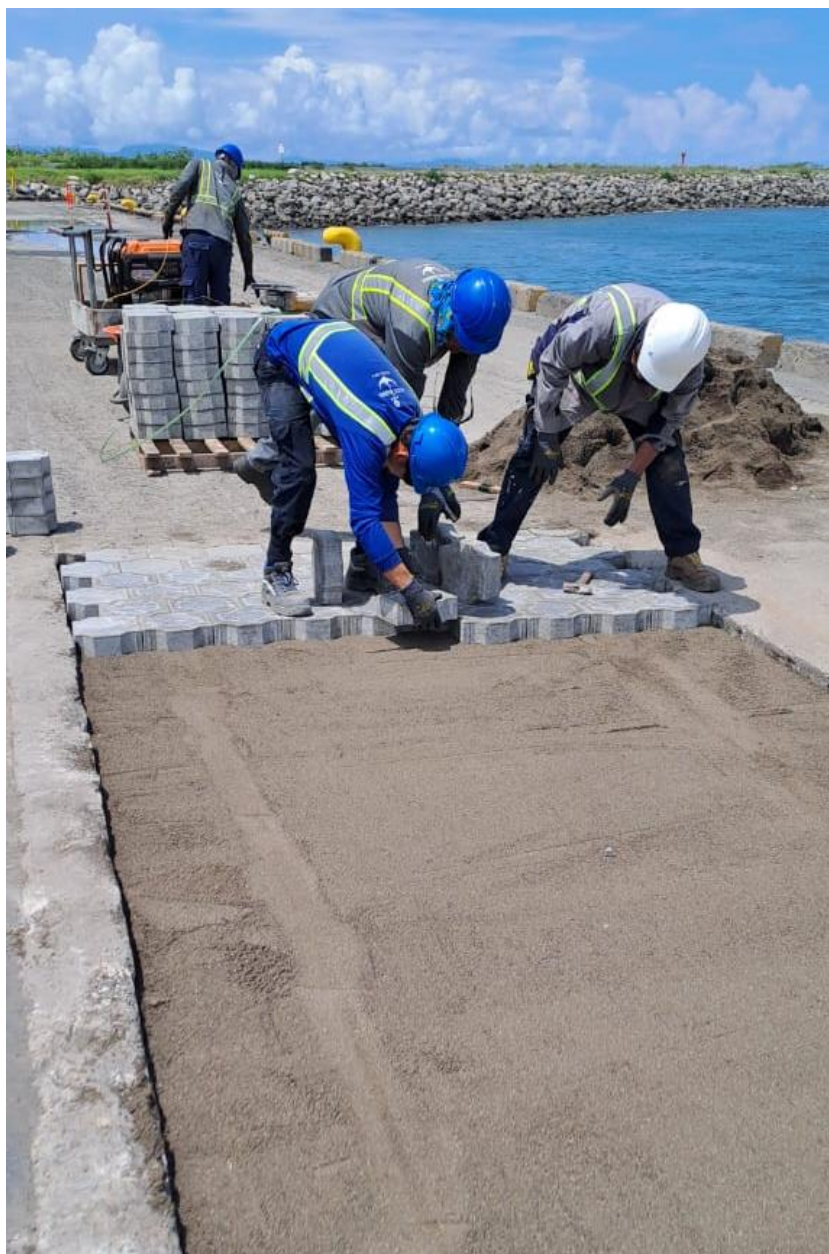
Figura 15. Trabajos colocación adoquín en puesto 1
