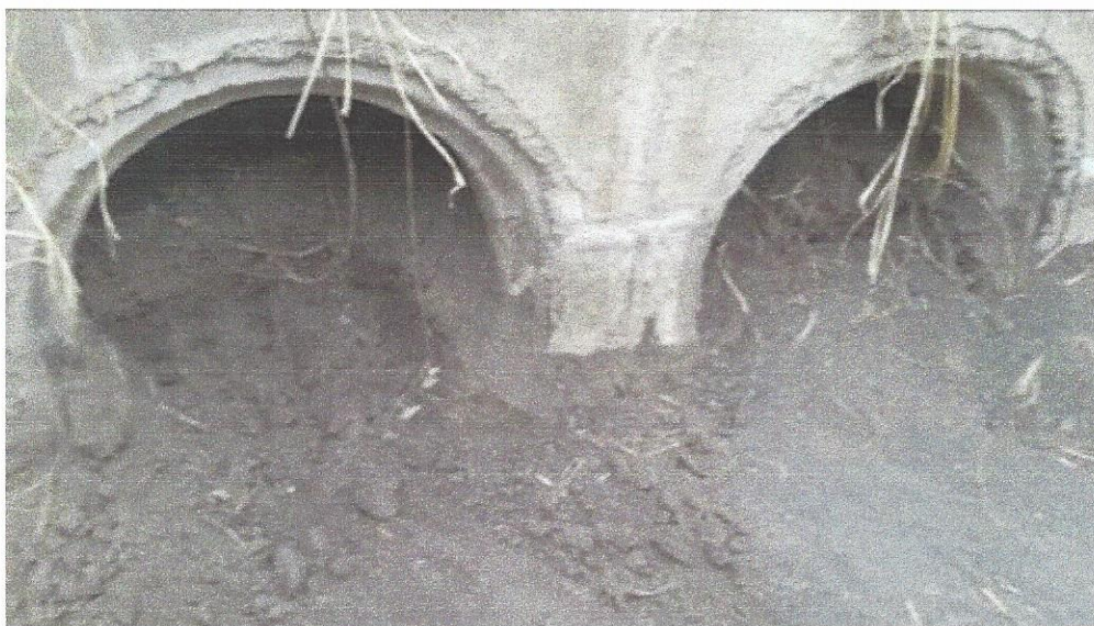
Figura 41. Estado previo de algunas entradas y salidas de alcantarillado pluvial
