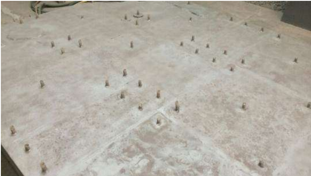
Figura 37. Limpieza de paneles de defensa marina por medio de sand blasting
