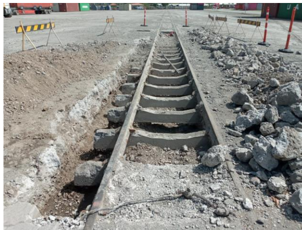
Figura 16. Trabajos de demolición de la zona a intervenir
