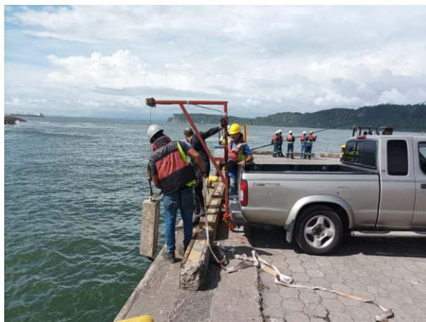
Figura 54. Preparación para instalación de ánodo
