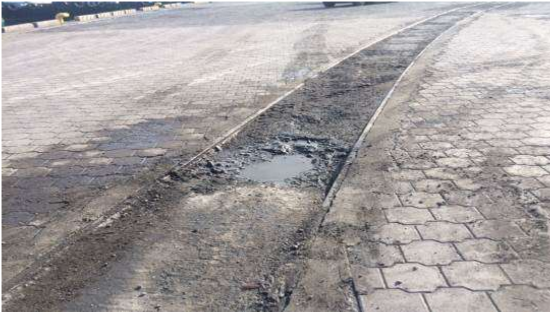
Figura 8. Estado previo a la reparación entre líneas del ferrocarril
