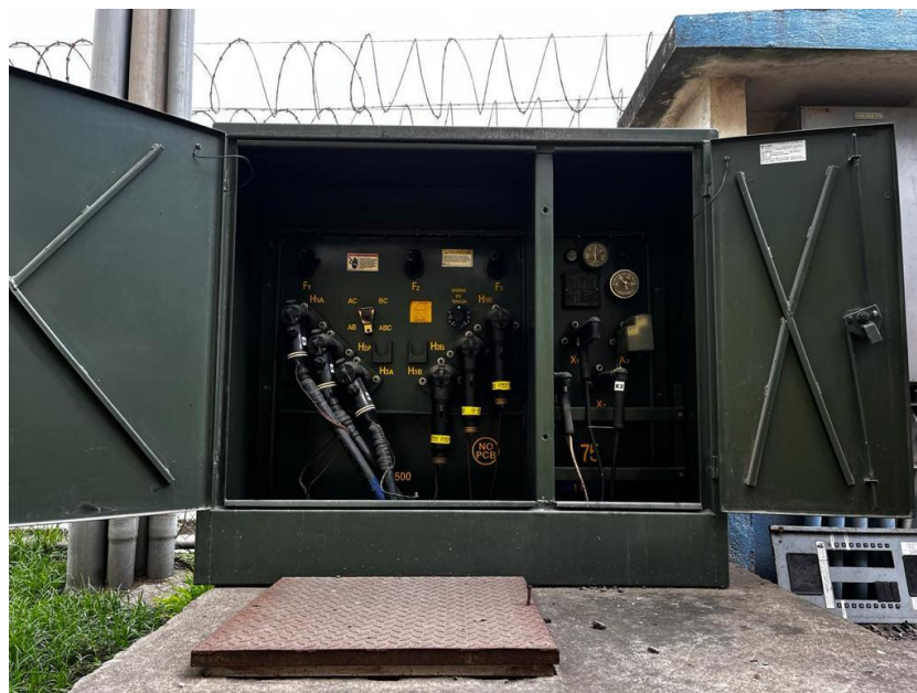
Figura 12. Mantenimiento bancos de transformadores zona postes iluminación
