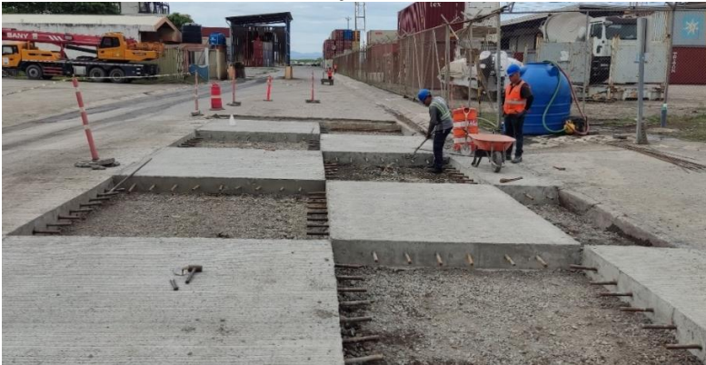
Figura N°1 Reconstrucción de losa de concreto, mejoramiento de vías en el recinto Portuario.
