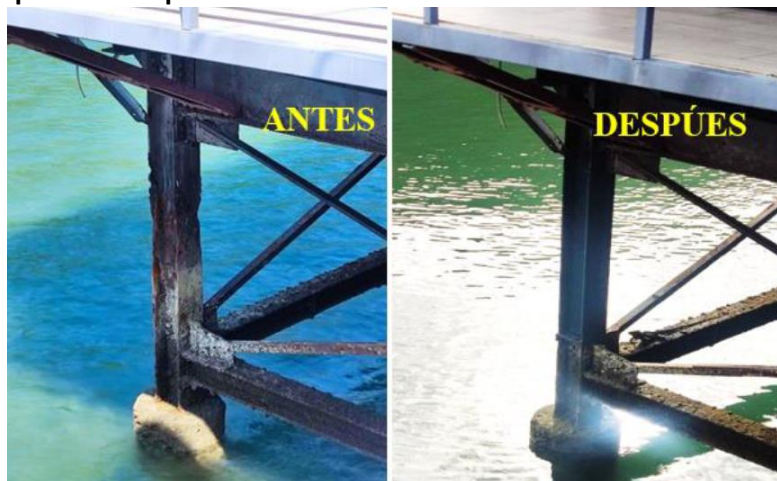
Figura N° 17. Reparación de pilote en la zona de las oficinas del Muelle de Golfito.
