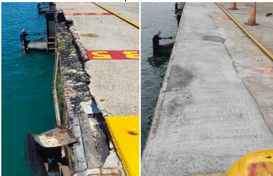
Figura N° 16. Antes y después de la reparación del daño en el Muelle de Golfito, producto de la colisión del buque atunero.
