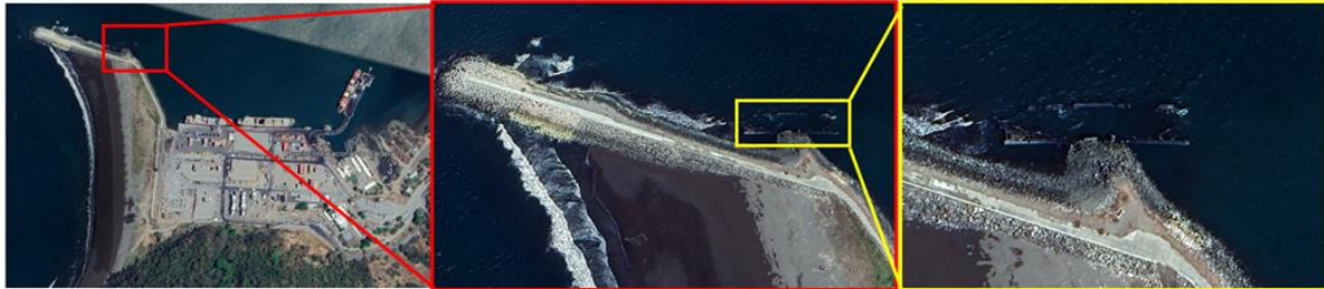
Figura 161: Ubicación del dique flotante hundido
