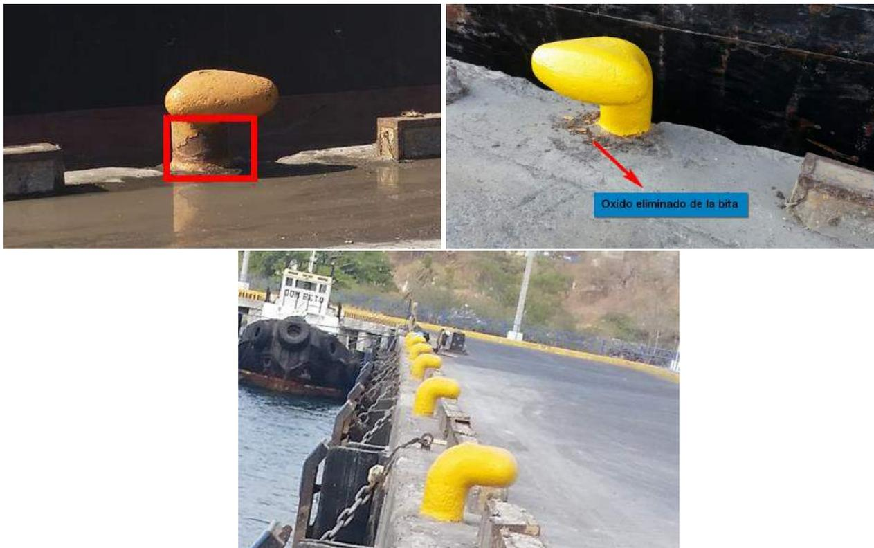
Figura 1.3. Conjunto fotográfico donde se observa el proceso de mantenimiento de las bitas
