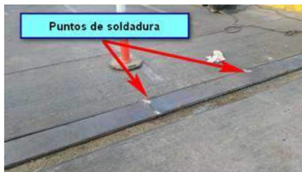
Figura 2.6. Intervención en pernos de sujeción de platinas en zonas de transición del puente
