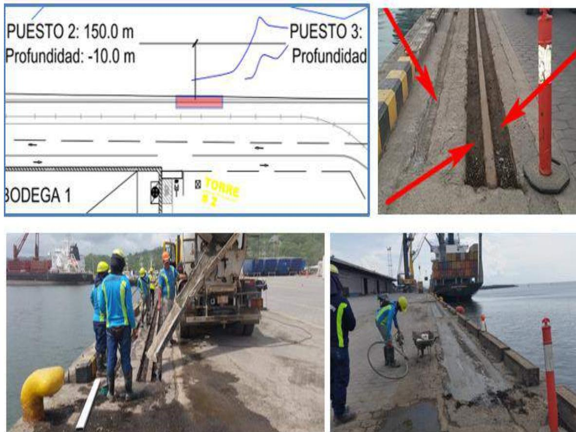
Figura 1.4. Conjunto fotográfico donde se observa el proceso de mantenimiento de la viga cabezal
